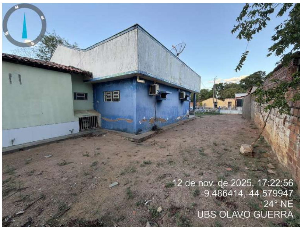
Figura 3: AMPLIAÇÃO DO ESTABELECIMENTO UBS PLANALTINA
