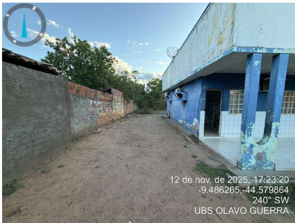
Figura 4: AMPLIAÇÃO DO ESTABELECIMENTO UBS PLANALTINA
