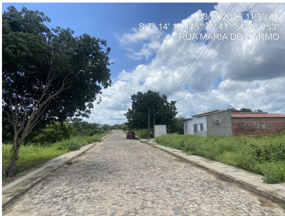
RUA MARIA DO CARMO (Trecho 1):
