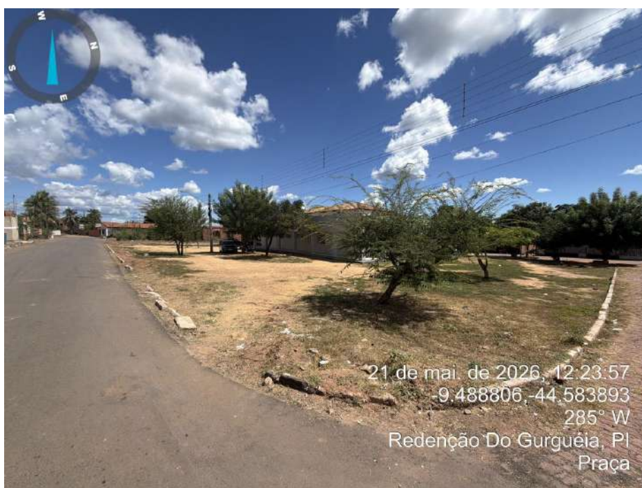
Figura 4: Local de Construção da Praça Pública
