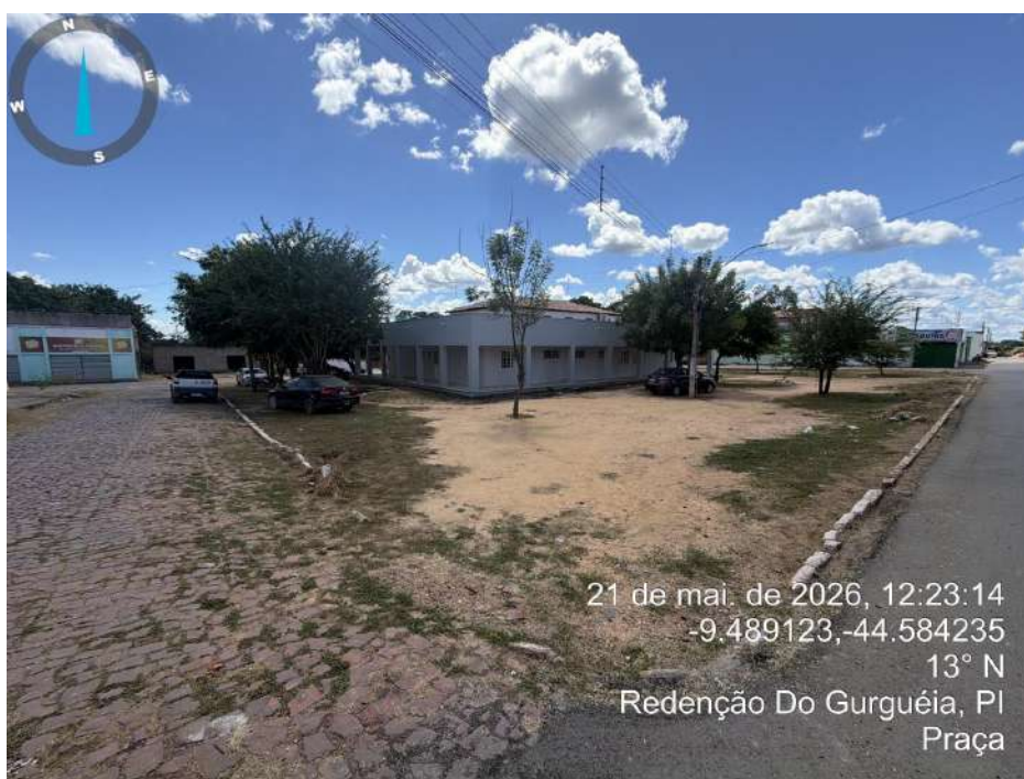
Figura 8: Local de Construção da Praça Pública
