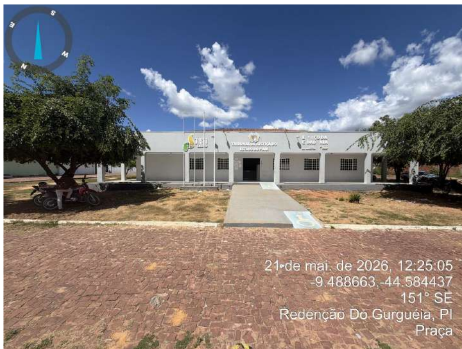
Figura 1: Local de Construção da Praça Pública
