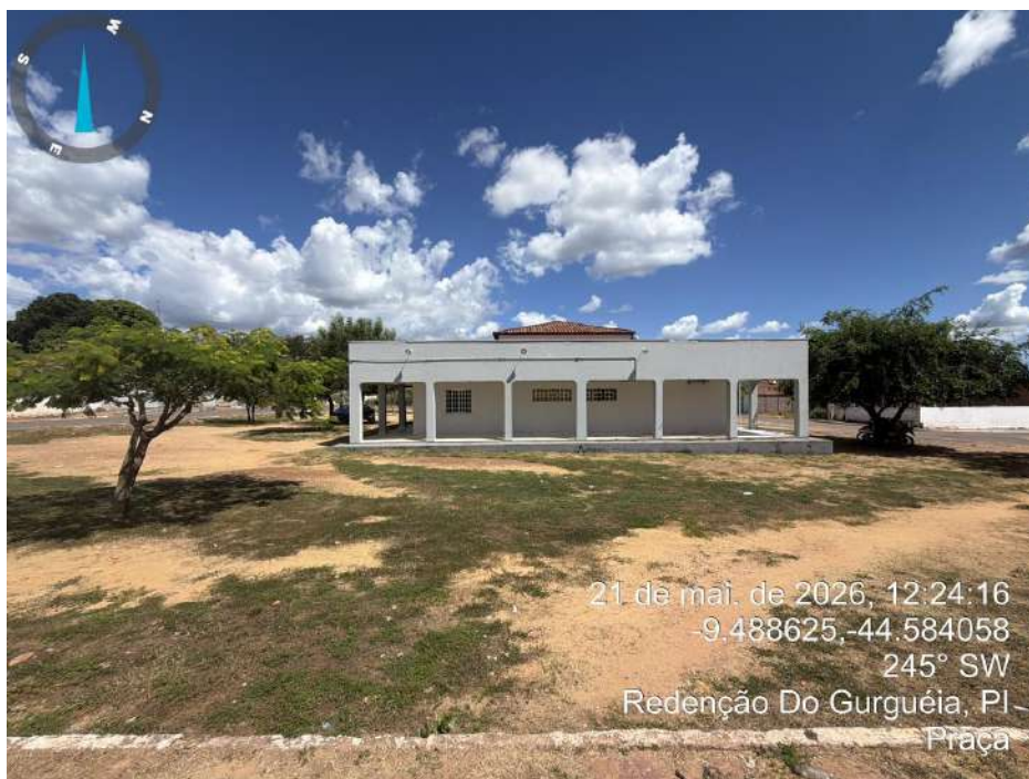
Figura 5: Local de Construção da Praça Pública
