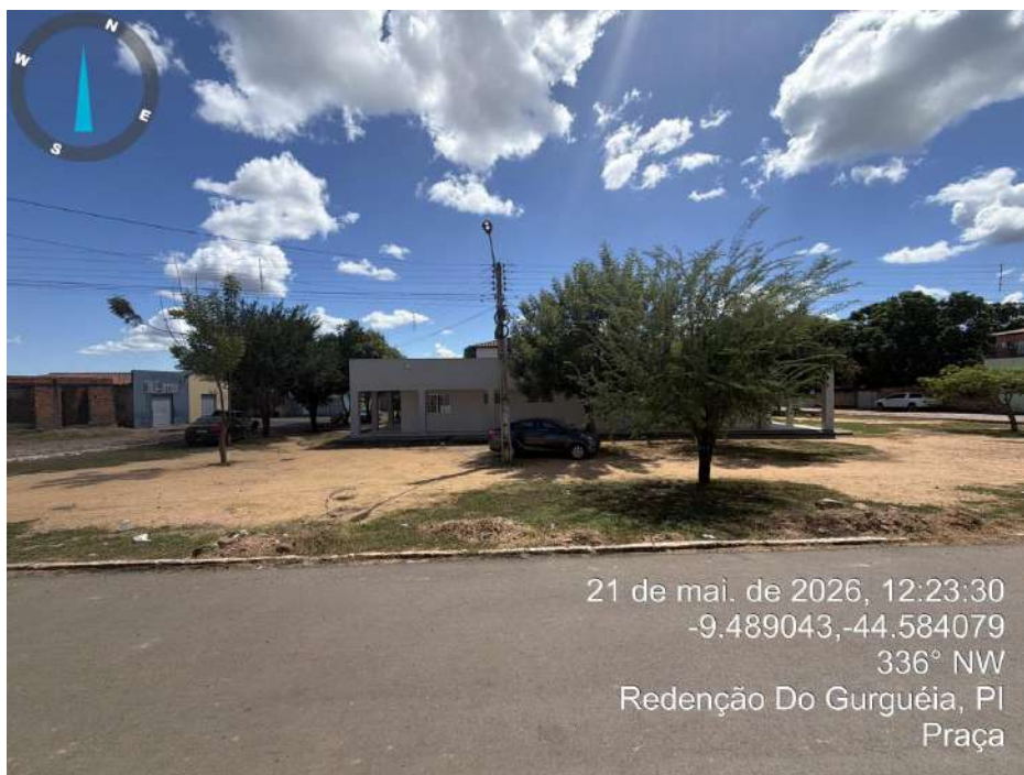
Figura 3: Local de Construção da Praça Pública
