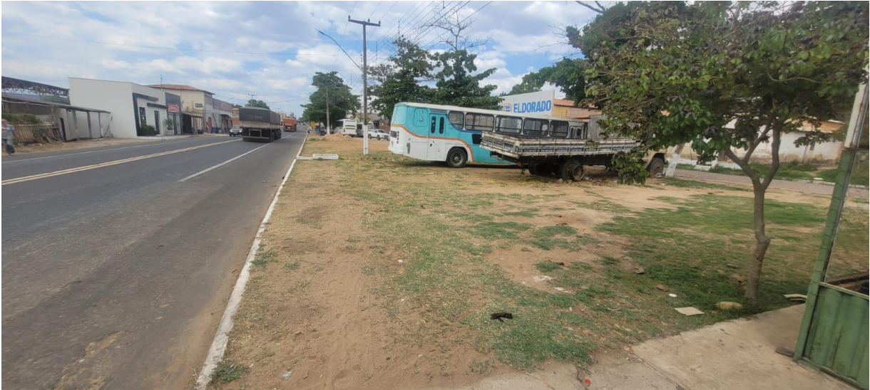
Foto 01: Local de Construção da Praça
