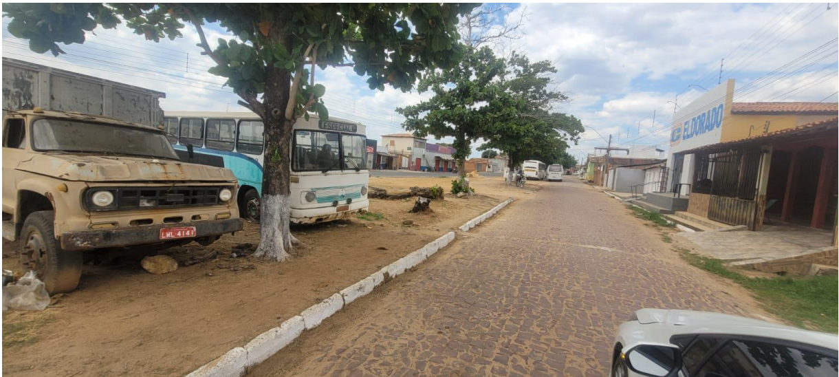
Foto 02: Local de Construção da Praça
