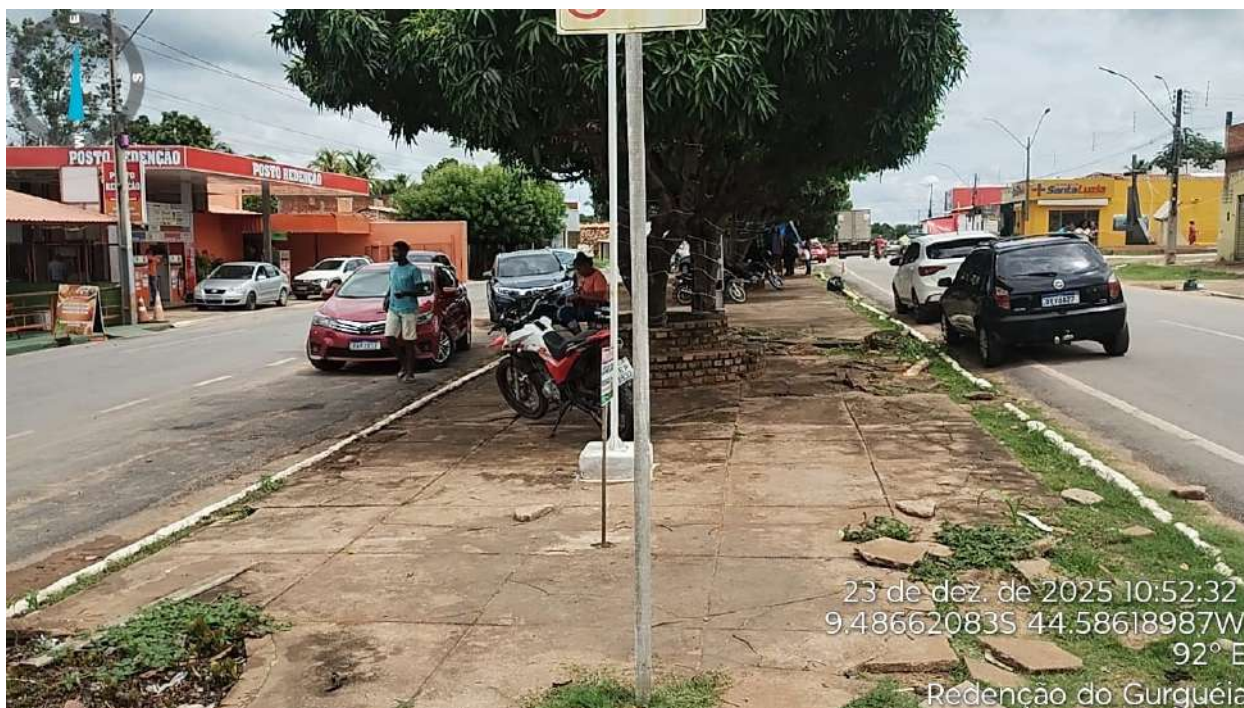
Figura 4: Local da Construção da Pista de Cooper
