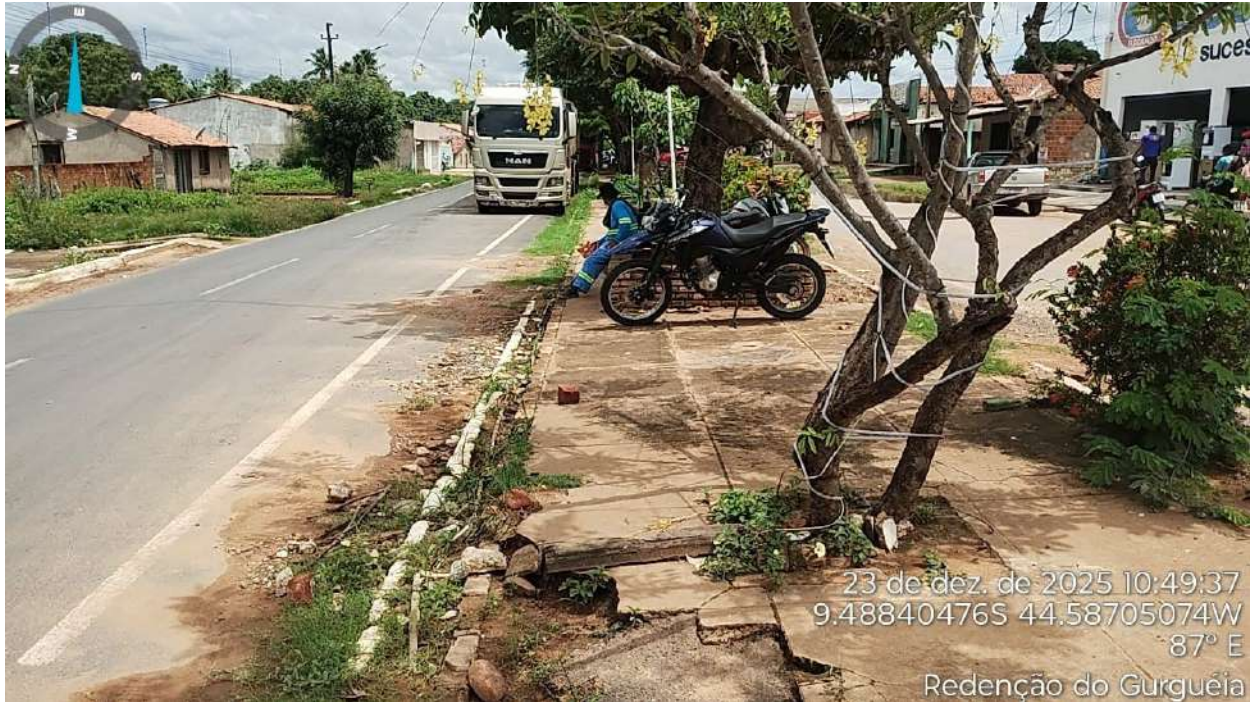
Figura 1: Local da Construção da Pista de Cooper
