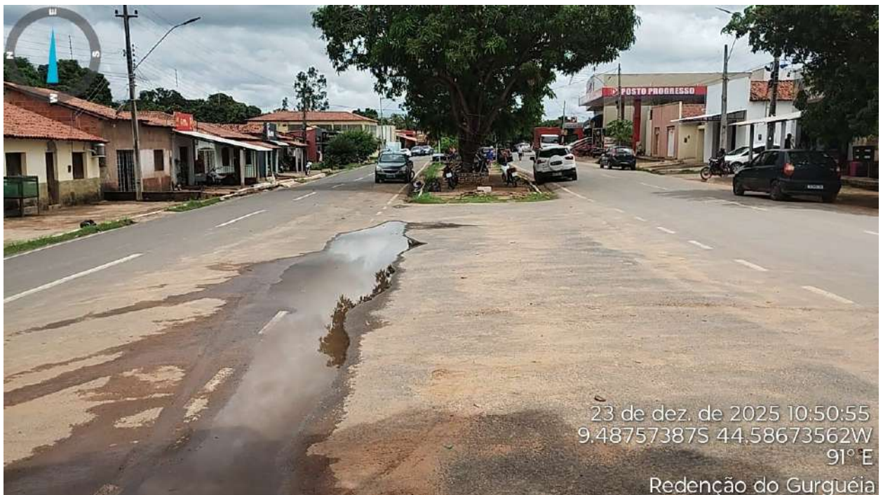
Figura 6: Local da Construção da Pista de Cooper
