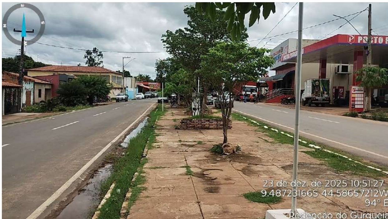
Figura 3: Local da Construção da Pista de Cooper
