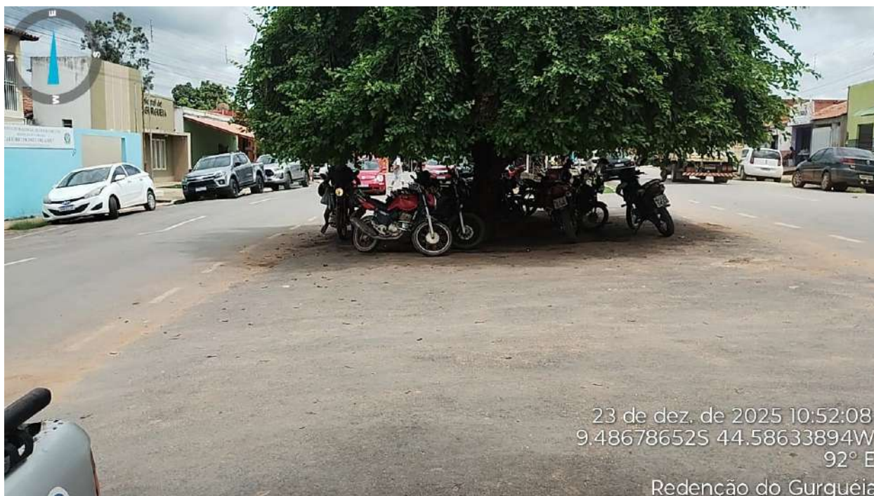
Figura 8: Local da Construção da Pista de Cooper
