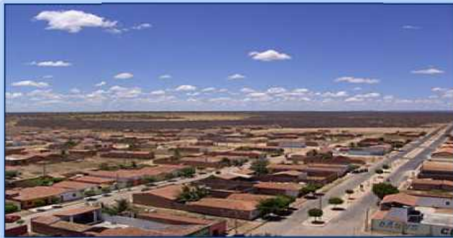
Figura 1: Imagem aérea do município de Belém do Piauí.
