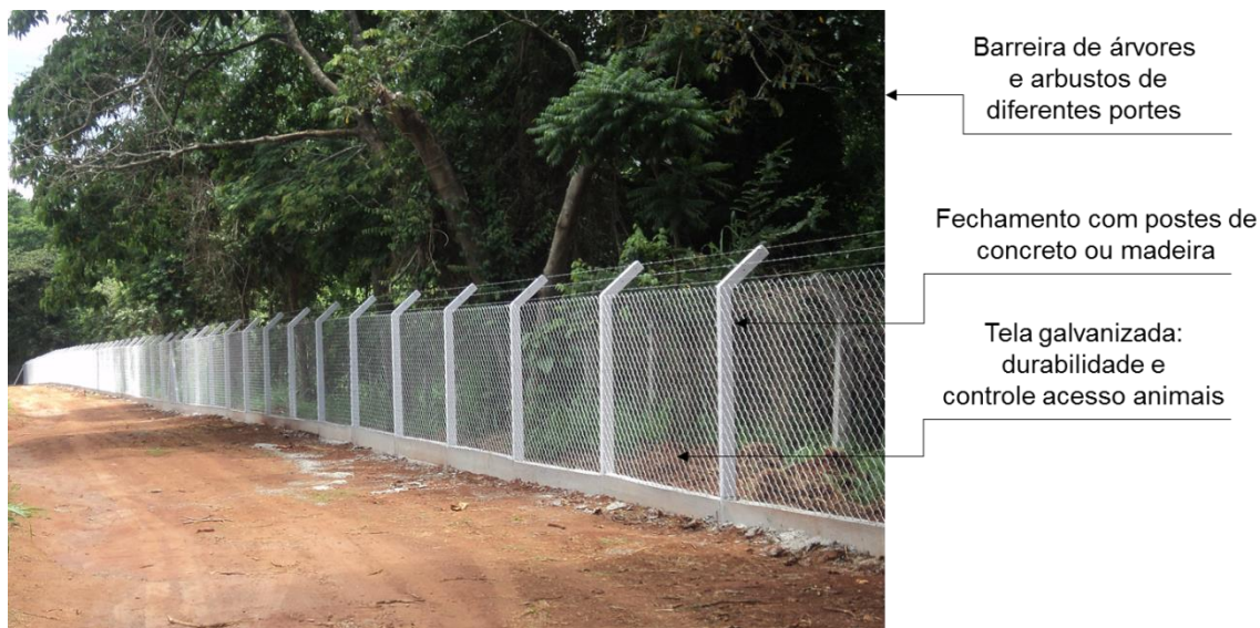
Figura 86 – Isolamentos da área: físico (cercamento) e visual (barreira vegetal)
