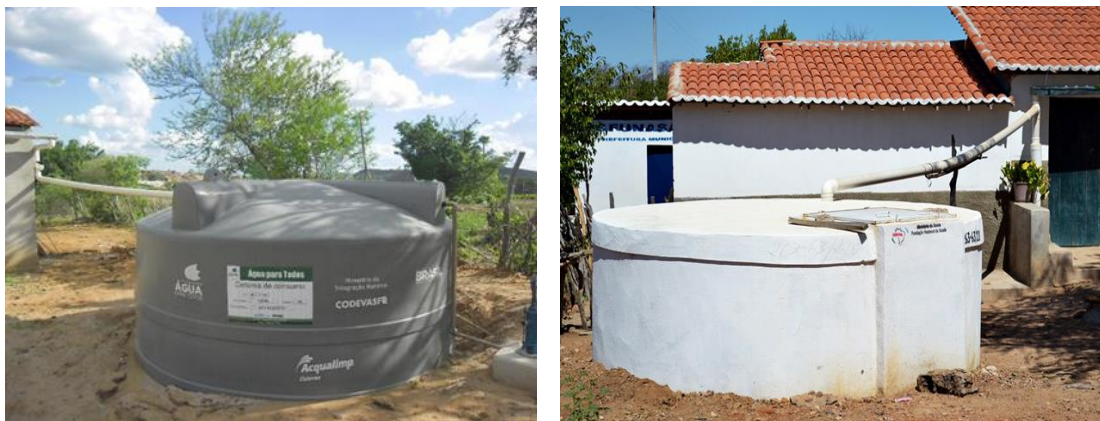
Figura 71 – Exemplos de cisterna em polietileno e em concreto
