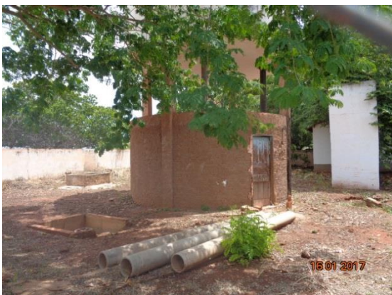
Figura 36 – Reservatório 1 – área do reservatório e reservatório (capacidade de 50 m³)
