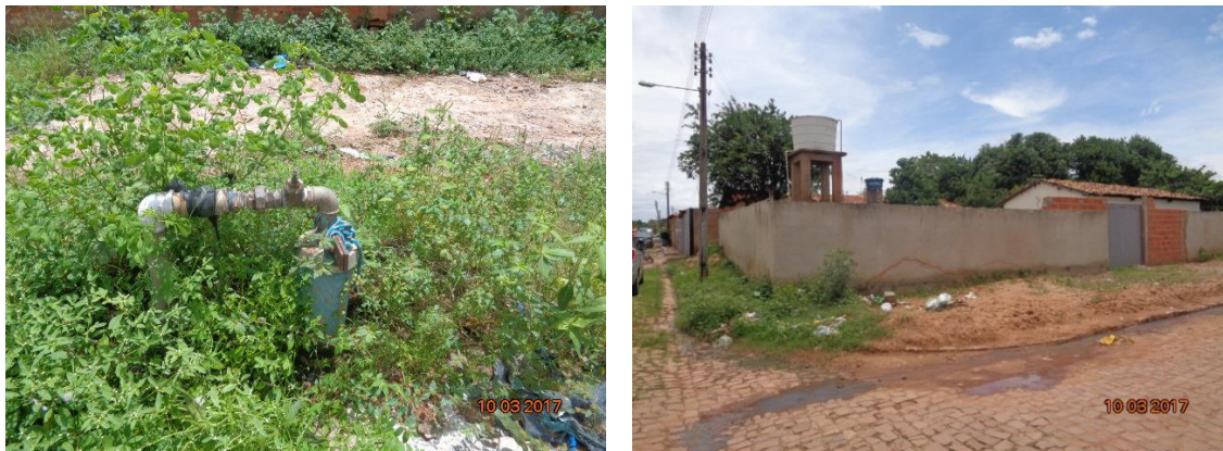
Figura 40 – Poço, área do poço e reservatório
