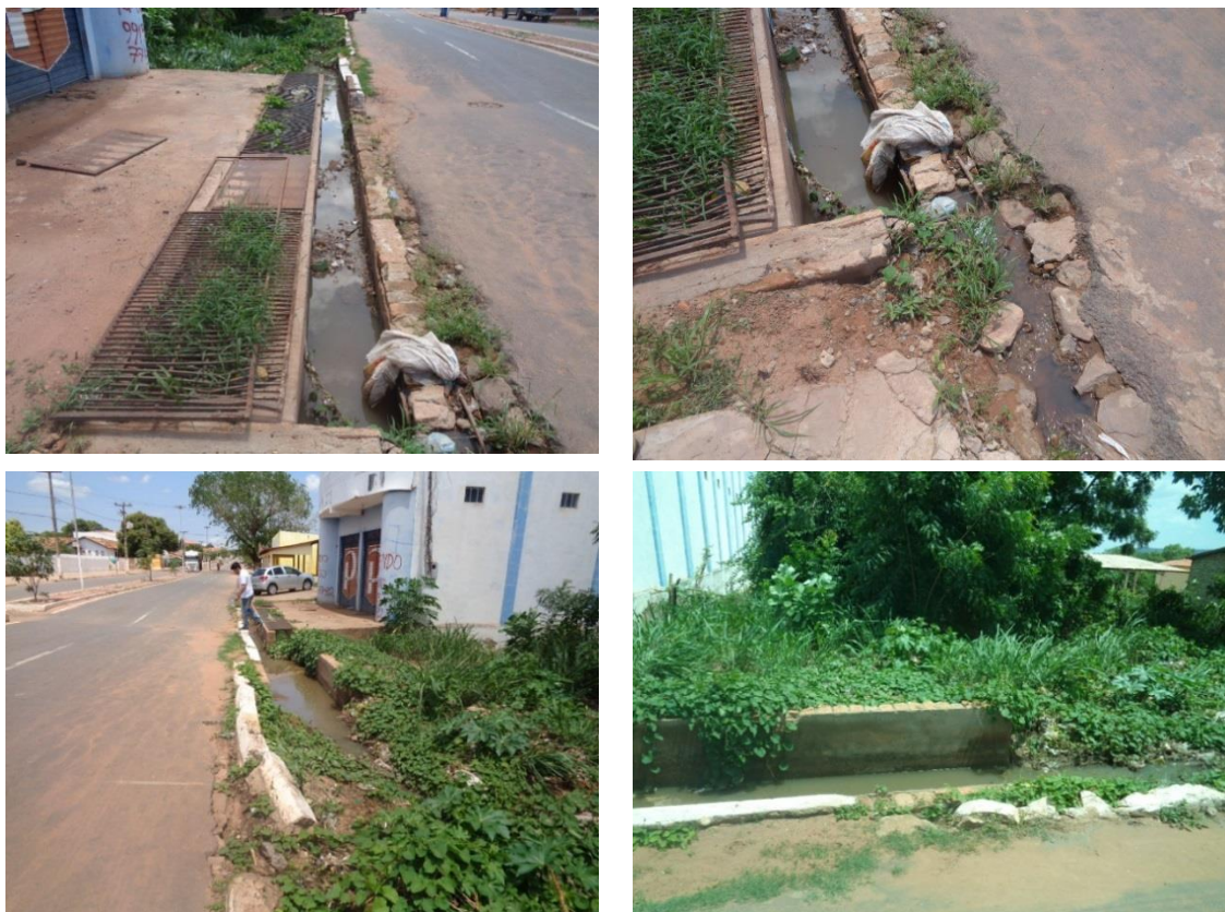
Figura 46 – Esgoto in natura sendo lançado na Av. Primeiro de Maio
