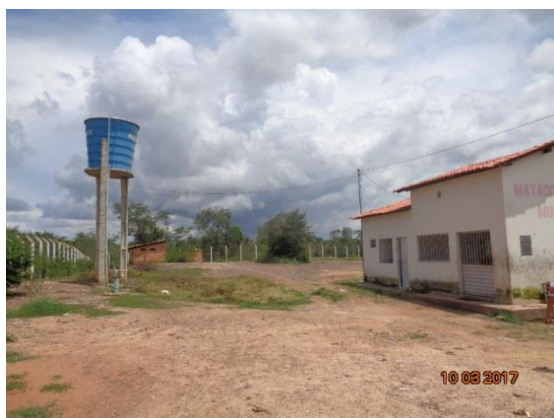
Figura 39 – Área do poço e reservatório
