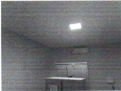
EXECUÇÃO DE PINTURA EM FORRO, PAREDES INTERNAS E INSTALAÇÕES DE LUMINÁRIAS
