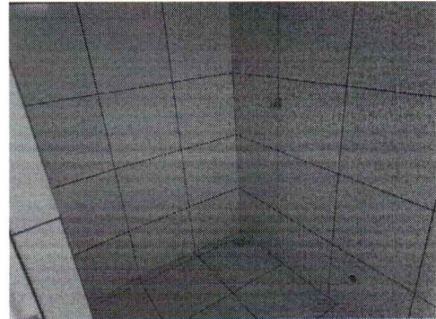
EXECUÇÃO DE INSTALAÇÃO DE METAIS EM BANHEIRO
