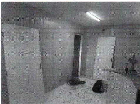
EXECUÇÃO DE INSTALAÇÃO DE PORTA DE MADEIRA
