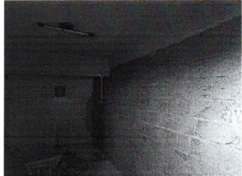
EXECUÇÃO DE CHAPISCO EM PAREDES INTERNAS
