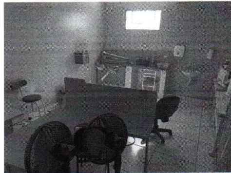
EXECUÇÃO DE PINTURA EM PAREDES INTERNAS
