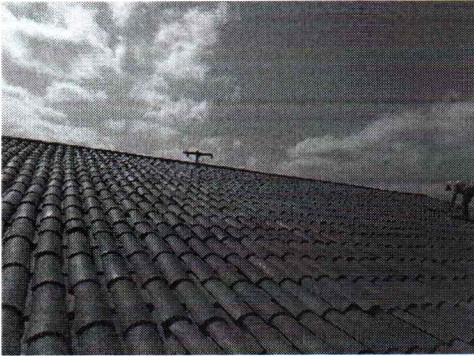
EXECUÇÃO DE RETELHAMENTO COM TELHAS CERÂMICAS
