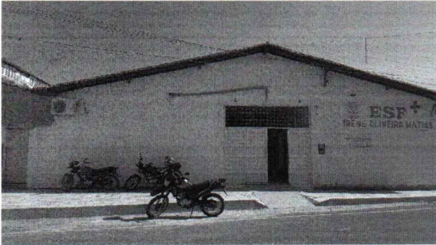
EXECUÇÃO DE RAMPA EM CALÇADA
