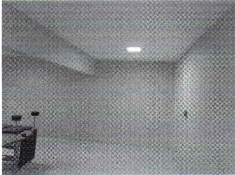
EXECUÇÃO DE PINTURA EM PAREDES INTERNAS
