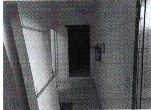
EXECUÇÃO DE REMOÇÃO DE PORTAS DE MADEIRA
