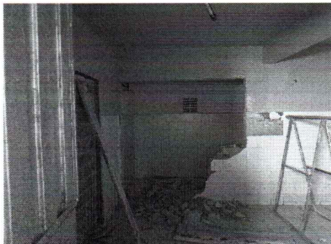
EXECUÇÃO DE DEMOLIÇÃO DE PAREDES DE ALVENARIA
