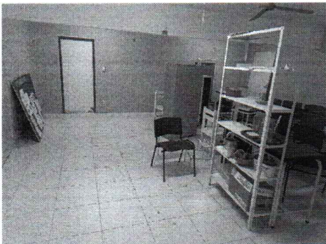
EXECUÇÃO DE PINTURA EM PAREDES INTERNAS
