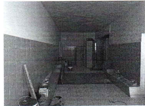
EXECUÇÃO DE PINTURA EM PAREDES INTERNAS
