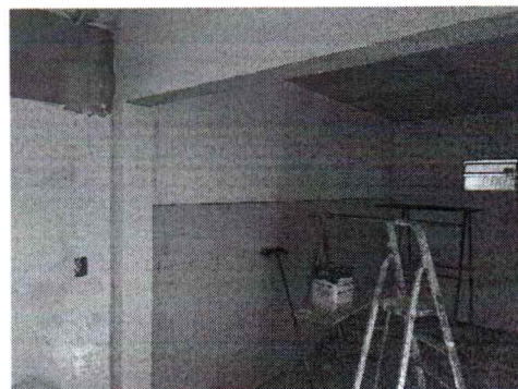
EXECUÇÃO DE EMASSAMENTO EM PAREDES INTERNAS
