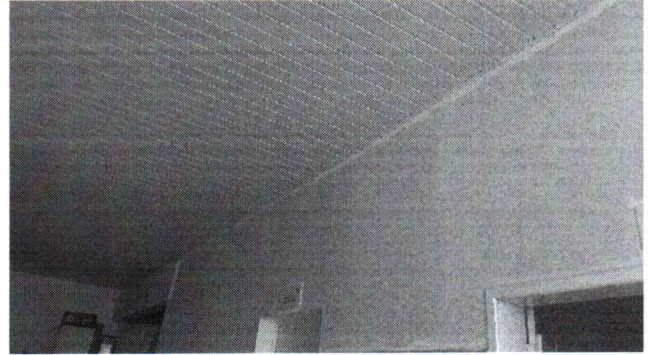
EXECUÇÃO DE PINTURA EM PAREDES INTERNAS
