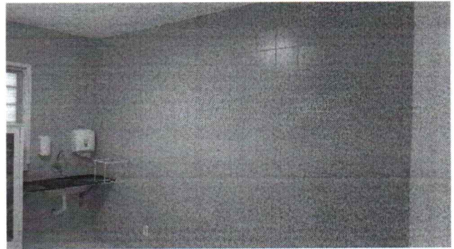
EXECUÇÃO DE INSTALAÇÃO DE LOUÇAS E METAIS
