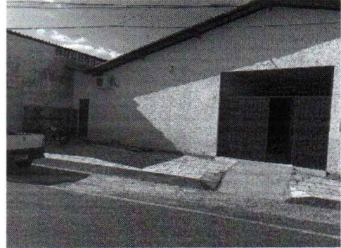
EXECUÇÃO DE PINTURA EM FACHADA PRINCIPAL
