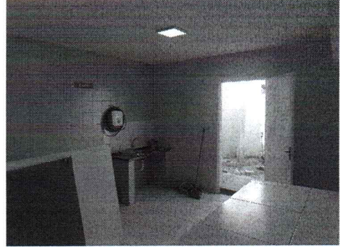
EXECUÇÃO DE PINTURA EM PAREDES INTERNAS
