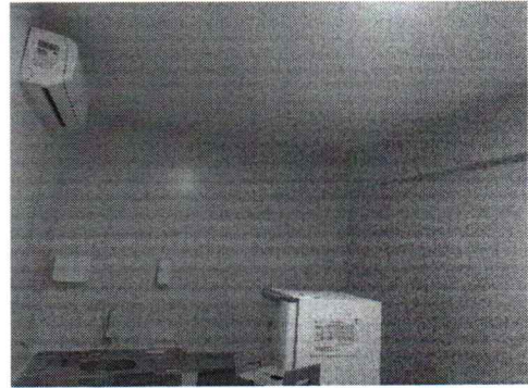
EXECUÇÃO DE PINTURA EM PAREDES INTERNAS
