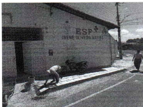
EXECUÇÃO DE RAMPA EM CALÇADA
