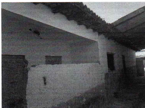
EXECUÇÃO DE DEMOLIÇÃO DE PAREDES DE ALVENARIA
