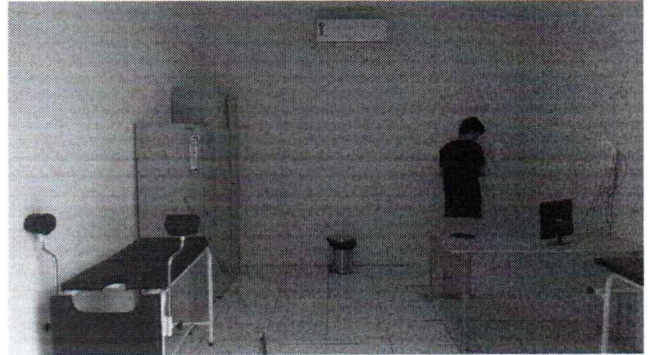
EXECUÇÃO DE INSTALAÇÃO DE LOUÇAS E METAIS
