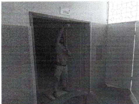
EXECUÇÃO DE ISOLAMENTO E PINTURA DE ESQUADRIAS
