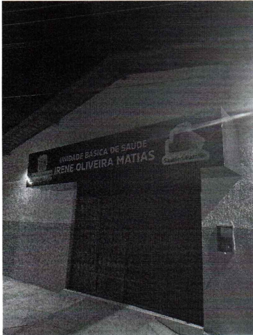
INSTALAÇÃO DE MARQUISE EM FACHADA PRINCIPAL
