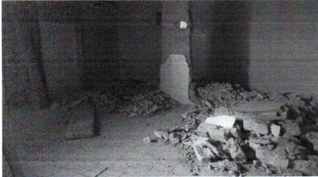
EXECUÇÃO DE DEMOLIÇÃO DE PAREDES DE ALVENARIA
