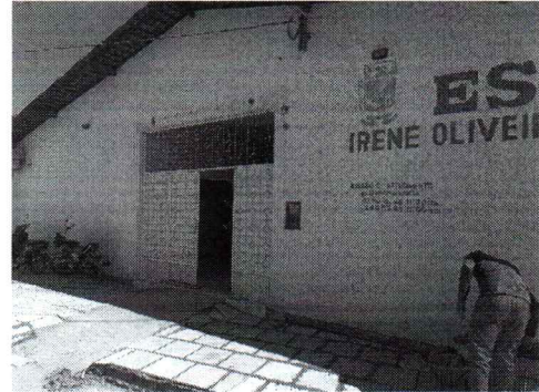
EXECUÇÃO DE ASSENTAMENTO DE PEDRA CARIRI EM CALÇADA
