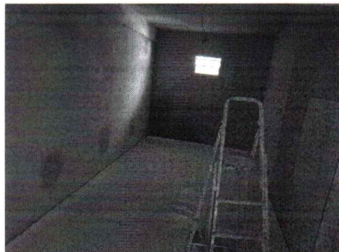
EXECUÇÃO DE REBOCO ARGAMASSADO EM PAREDES INTERNAS
