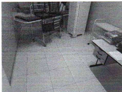
EXECUÇÃO DE REJUNTAMENTO DE PISO CERÂMICO
