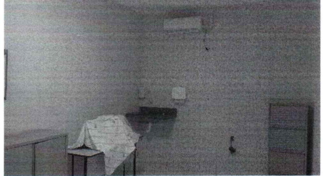
EXECUÇÃO DE INSTALAÇÃO DE LOUÇAS E METAIS
