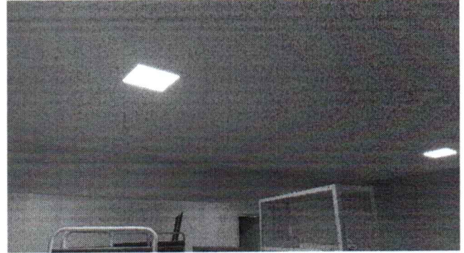
EXECUÇÃO DE INSTALAÇÃO DE LUMINÁRIAS
