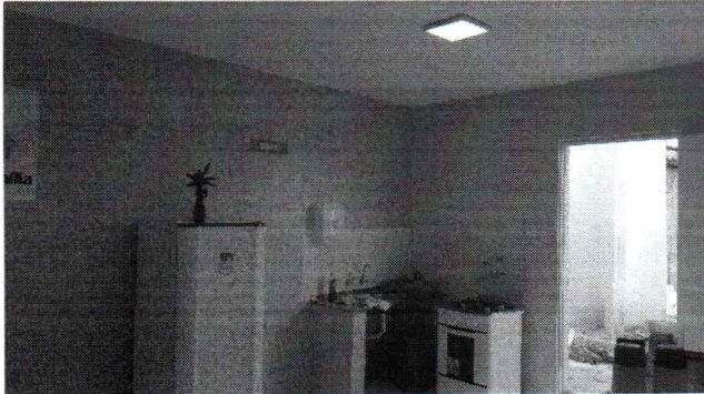
EXECUÇÃO DE INSTALAÇÃO DE LOUÇAS E METAIS
