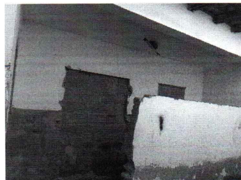
EXECUÇÃO DE DEMOLIÇÃO DE PAREDES DE ALVENARIA
