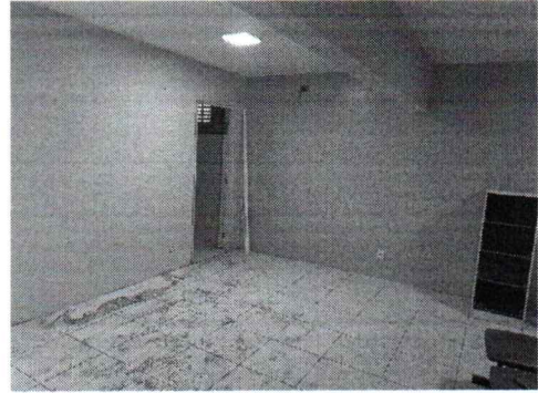
EXECUÇÃO DE PINTURA EM PAREDES INTERNAS
