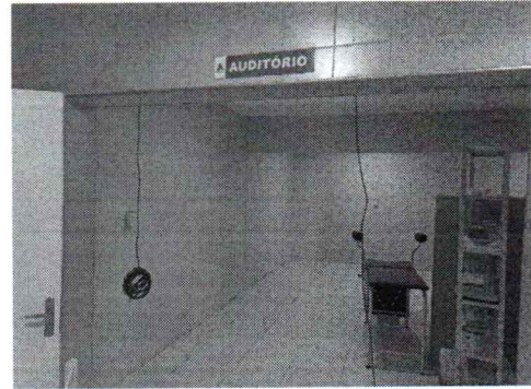
EXECUÇÃO DE PINTURA EM PAREDES INTERNAS
