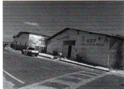
EXECUÇÃO DE RAMPA EM CALÇADA
