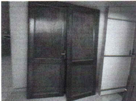
EXECUÇÃO DE REMOÇÃO DE PORTAS DE MADEIRA
