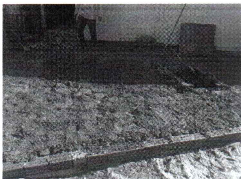
EXECUÇÃO DE ATERRO E NIVELAMENTO DE SOLO EM CALÇADA
