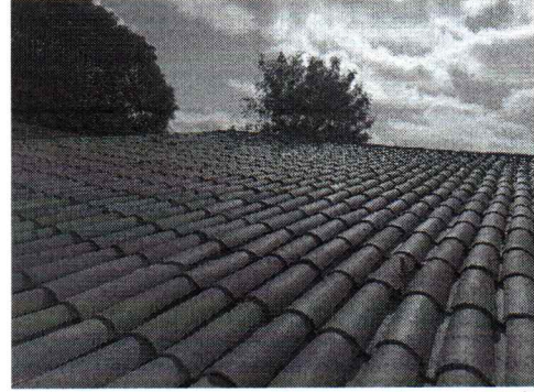
EXECUÇÃO DE RETELHAMENTO COM TELHAS CERÂMICAS
