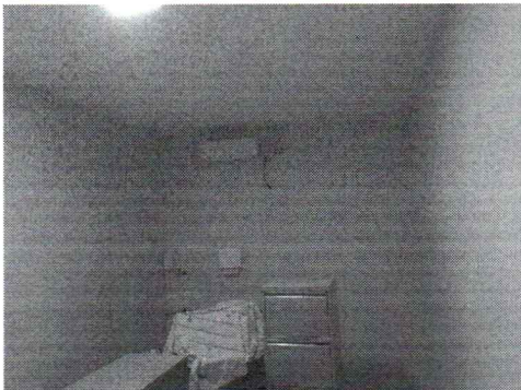
EXECUÇÃO DE PINTURA EM PAREDES INTERNAS
