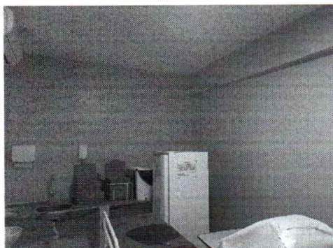
EXECUÇÃO DE PINTURA EM PAREDES INTERNAS
