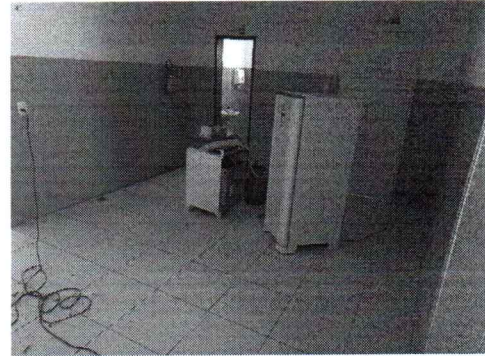
EXECUÇÃO DE PINTURA EM PAREDES INTERNAS
