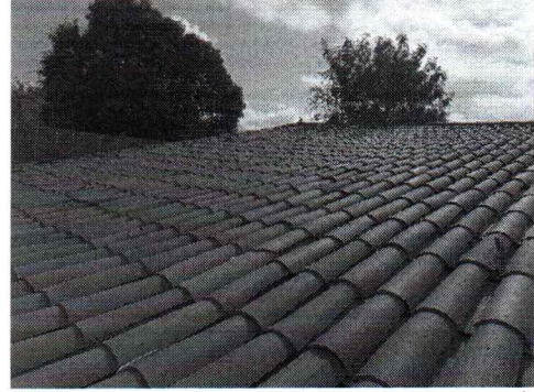
EXECUÇÃO DE RETELHAMENTO COM TELHAS CERÂMICAS
