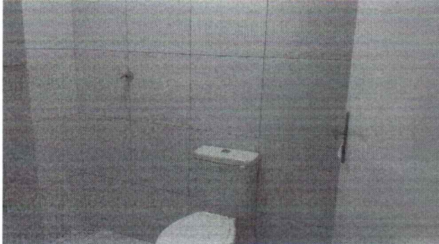
EXECUÇÃO DE INSTALAÇÃO DE LOUÇAS E METAIS
