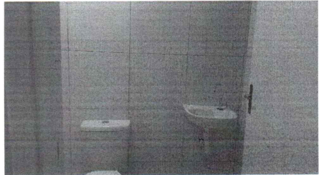
EXECUÇÃO DE INSTALAÇÃO DE LOUÇAS E METAIS
