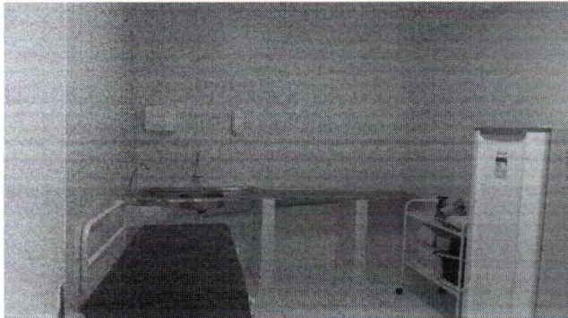
EXECUÇÃO DE INSTALAÇÃO DE LOUÇAS E METAIS
