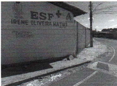
EXECUÇÃO DE ATERRO, NIVELAMENTO E COMPACTAÇÃO DO SOLO (BASE) DA CALÇADA
