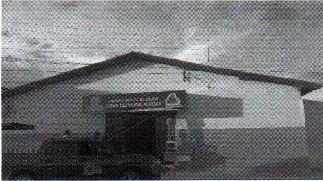
INSTALAÇÃO DE MARQUISE EM FACHADA PRINCIPAL
