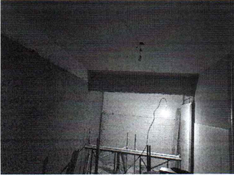
EXECUÇÃO DE REBOCO ARGAMASSADO EM PAREDES INTERNAS
