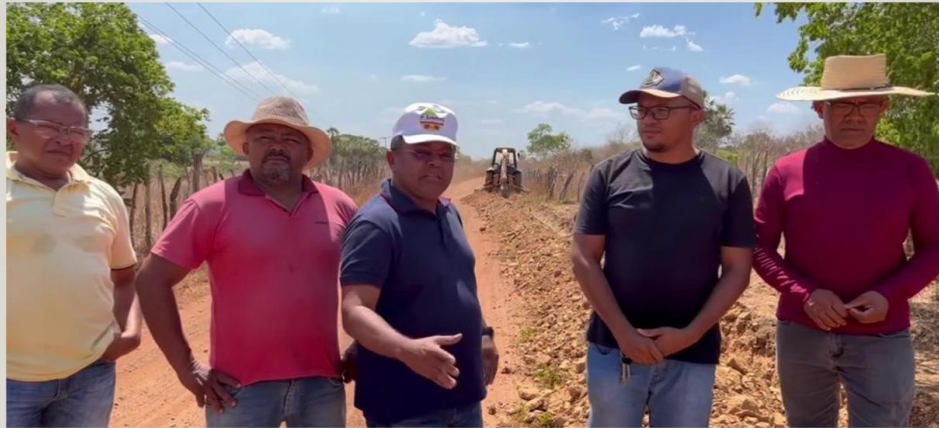
AMPLIAÇÃO DA REDE DE ABASTECIMENTO D'ÁGUA NA COMUNIDADE BARRA DO RIO
