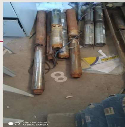
TROCA DE BOMBA DE POÇO
