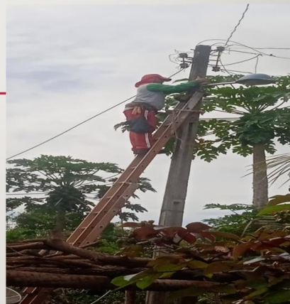
TROCA DE LÂMPADAS DA ILUMINAÇÃO PÚBLICA MUNICIPAL
