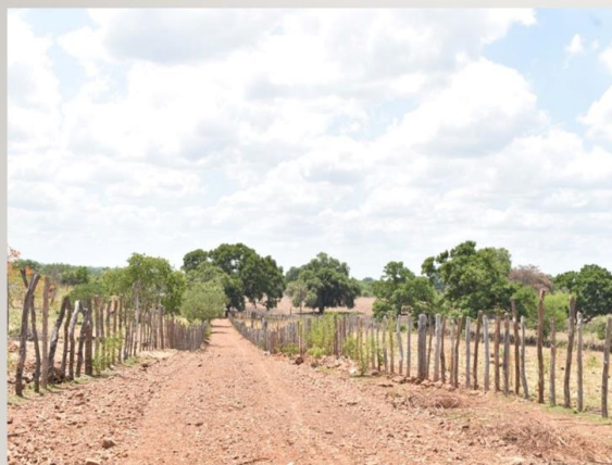
SERVIÇO DE 1 KM DE PIÇARRA NA ESTRADA DA LOCALIDADE ALDEIA DOS BELIM
