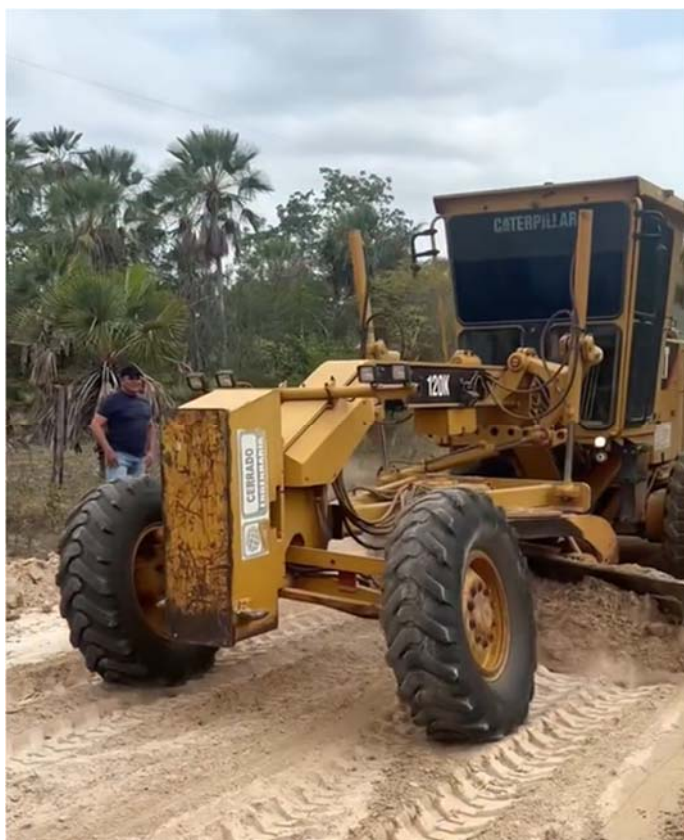
Figura 10 – Revitalização de estradas vicinais com motoniveladora.
