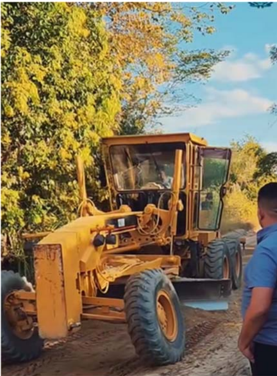
Figura 8 – Intervenção com maquinário pesado para recuperação do leito estradal e garantia de trafegabilidade na localidade Buriti Grande.
