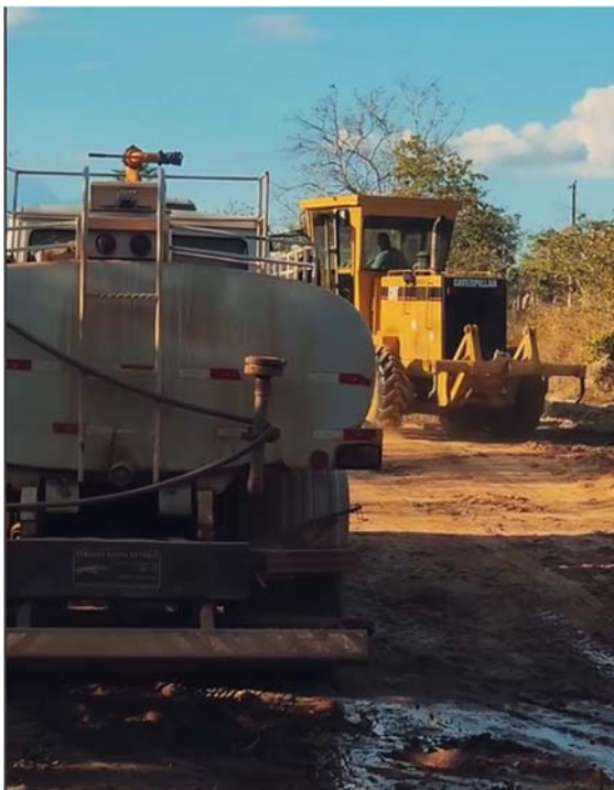
Figura 9 – Operação conjunta com caminhão-pipa para umidificação e compactação do solo durante a execução das obras viárias.
