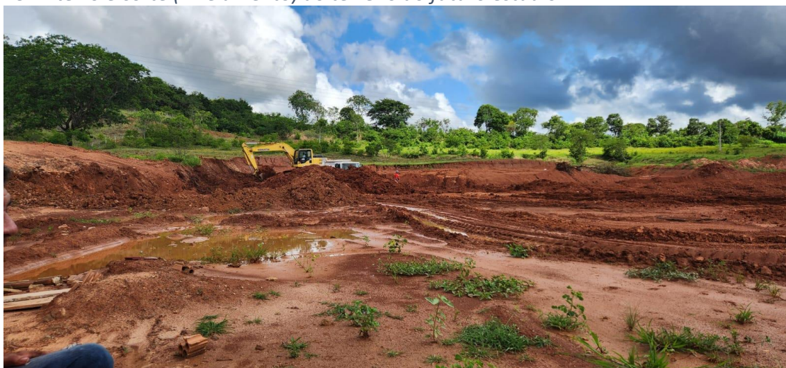
13 - Aterro e corte (nivelamento) do terreno do futuro estádio
