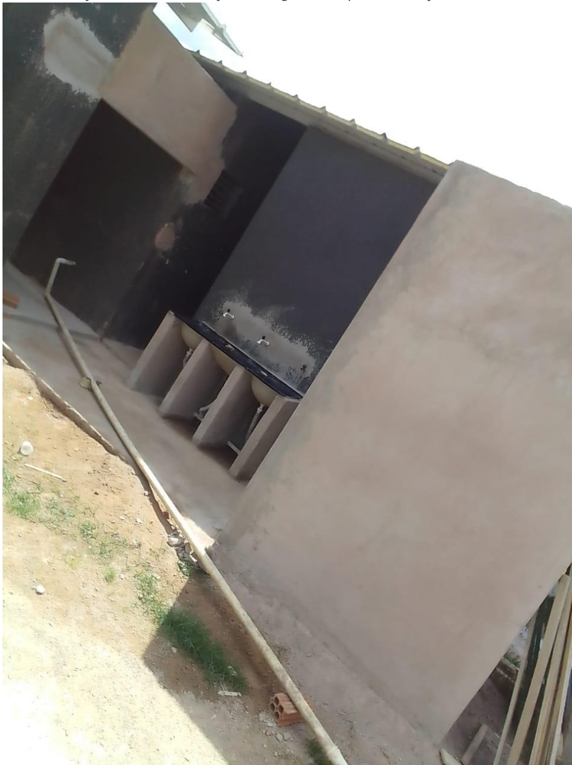
Figura 2 área de serviço colégio são Gonçalo
