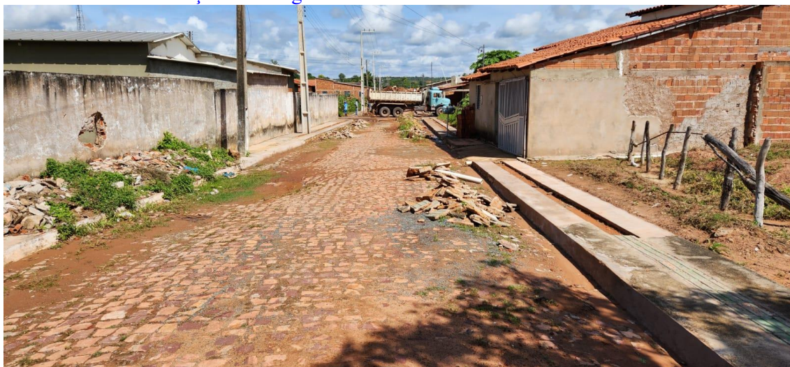
12 - Serviço de corte e aterro em um morro na localidade araras
