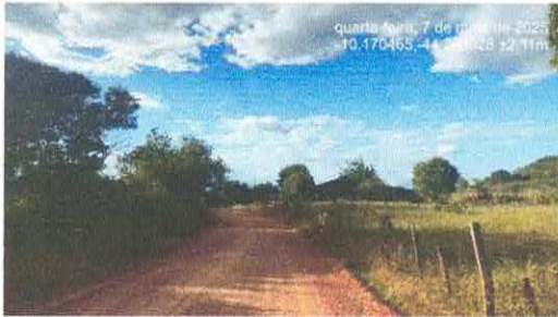
Trecho 03 - Acesso Barragem Dos Algodões II ( PI-255) á Lagoa Grande
