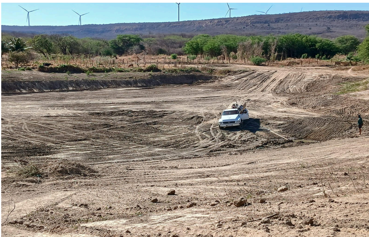
Limpeza do Açude na comunidade Caboclos, Zona Rural do Município
