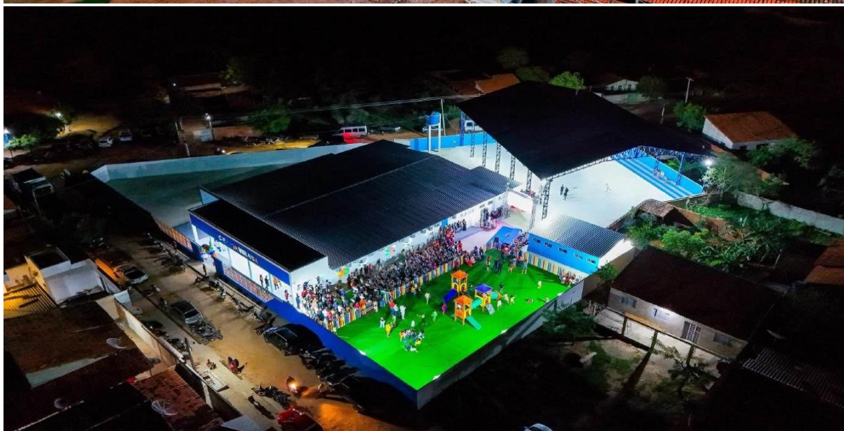
CONSTRUÇÃO E INAUGURAÇÃO DO CENTRO DE EDUCAÇÃO INFANTIL TIA MIRAISSA, NO BAIRRO BANDARRA, ZONA URBANA DO MUNICÍPIO.
