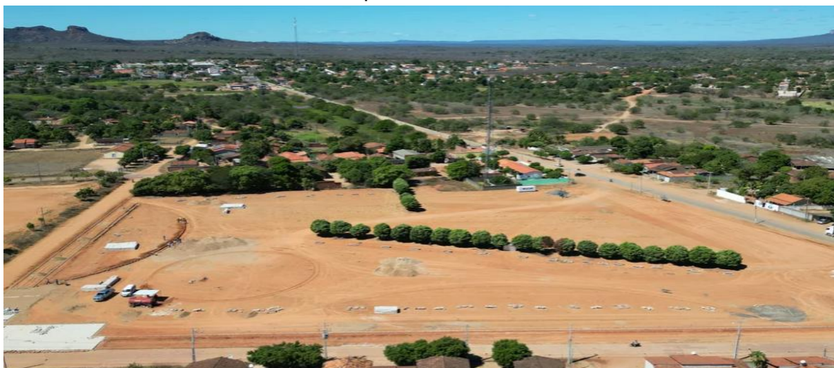
A CONSTRUÇÃO DA PRAÇA DE EVENTOS OSMAR CARVALHO GUERRA FILHO, NO BAIRRO NOVA CURIMATÁ
