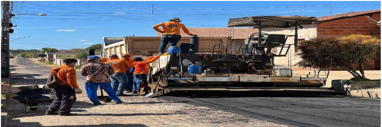
EXECUÇÃO DA PAVIMENTAÇÃO ASFÁLTICA DA AVENIDA BARÃO DO PARAÍM, QUE LIGA O CENTRO DA CIDADE AO BAIRRO VILA BRANCA, ZONA URBANA DO MUNICÍPIO
