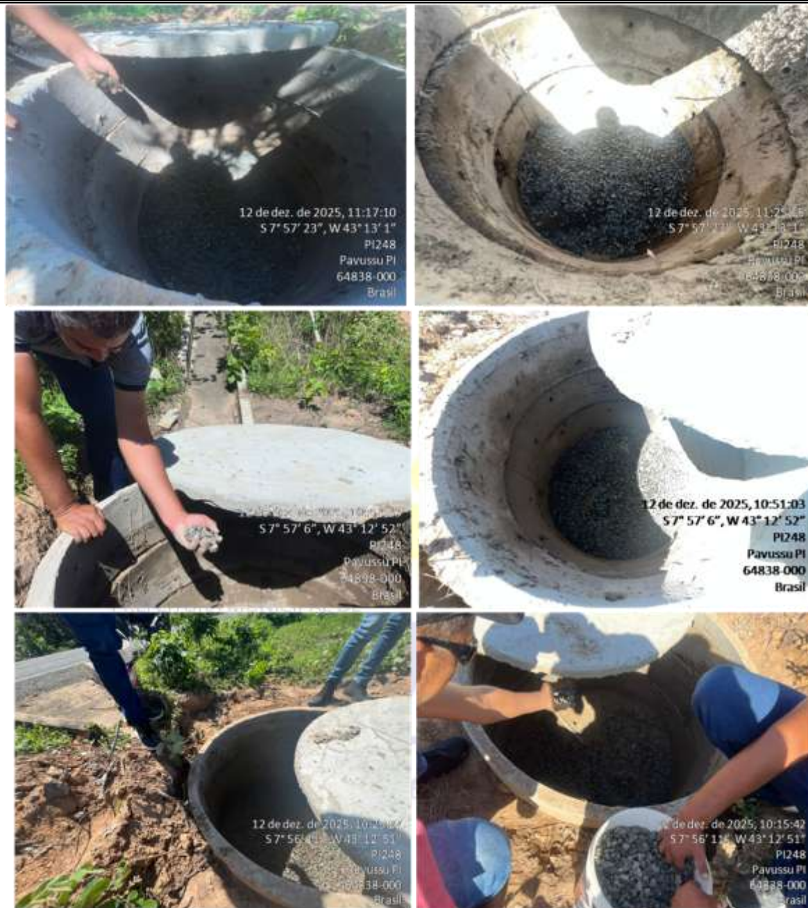
Figura 4. Inserção das britas no interior das manilhas nos pontos, em Pavussu-PI. Fonte: Figura do autor. (2025)
