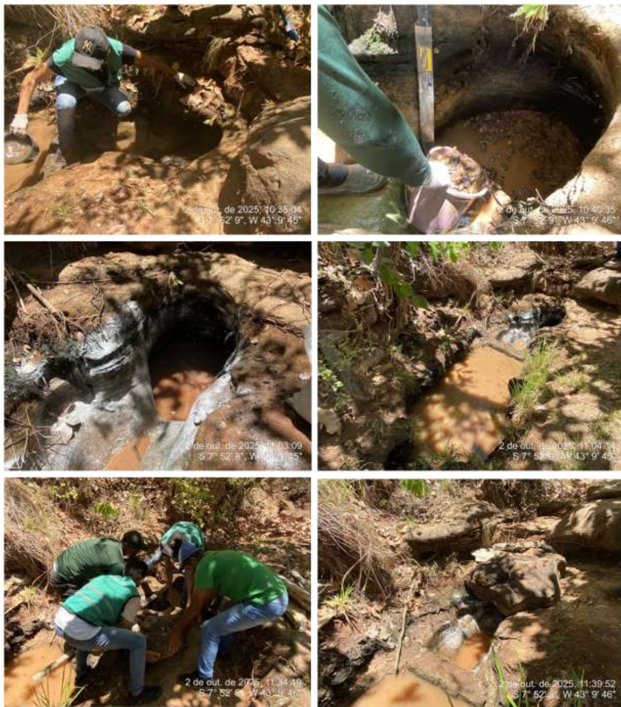
Figura 4. Remoção dos sedimentos arenosos e aplicação do pó de cal na nascente, localidade Várzea Grande, zona rural do município de Pavussu-PI. Fonte: Figura do autor. (2025)
