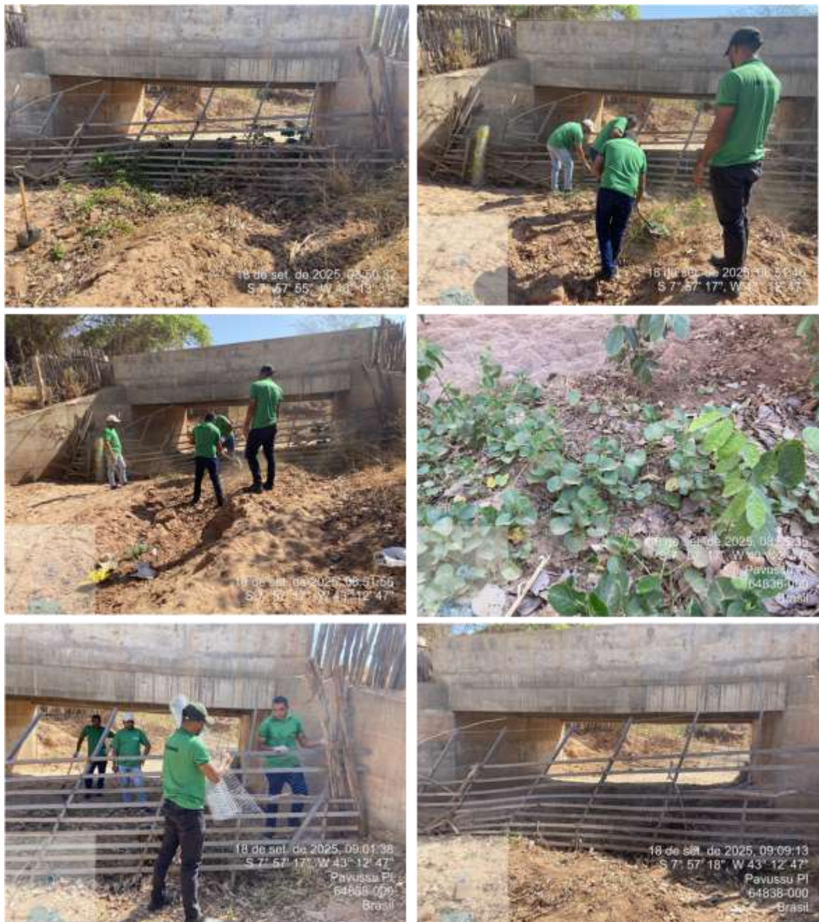
Figura 3. Retirada da vegetação e instalação da tela de proteção sob a ponte situada no riacho Macaubeira, município de Pavussu, Piauí. Fonte: Figura do autor. (2025)
