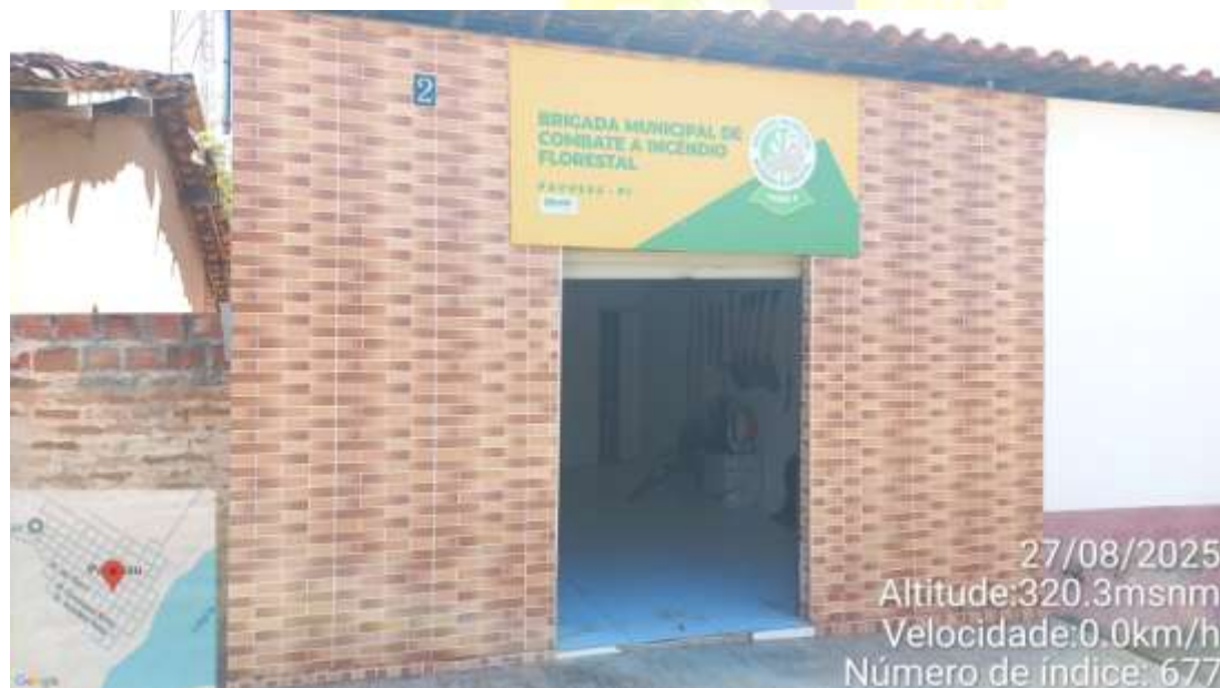
Figura 2. Sede da Brigada Municipal de Combate a Incêndio Florestal de Pavussu-PI. Fonte: Figura do autor. (2025)
