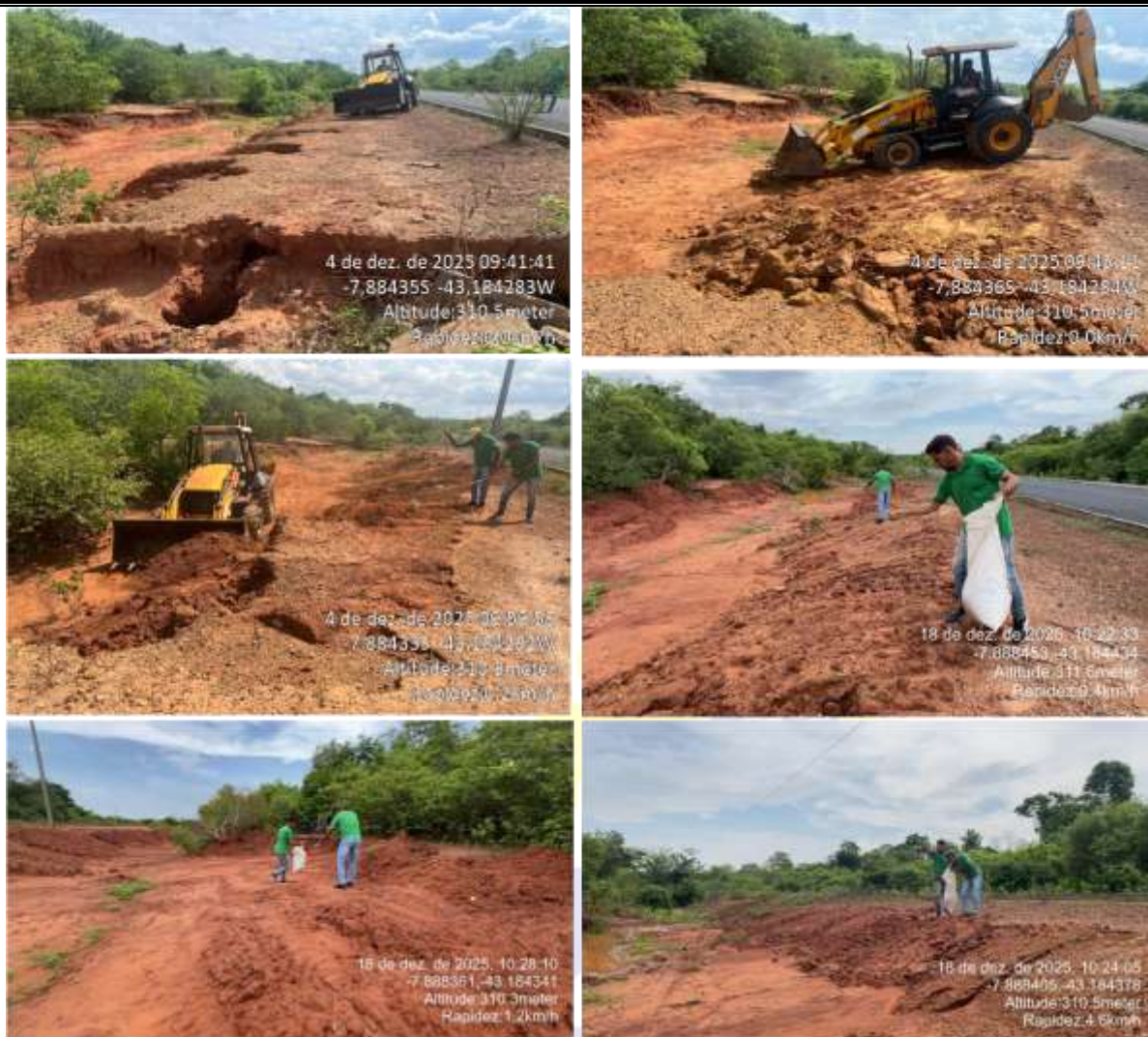
Figura 1. Nivelamento da área degradada e plantio de capim, na localidade Xixa, Pavussu-PI.
