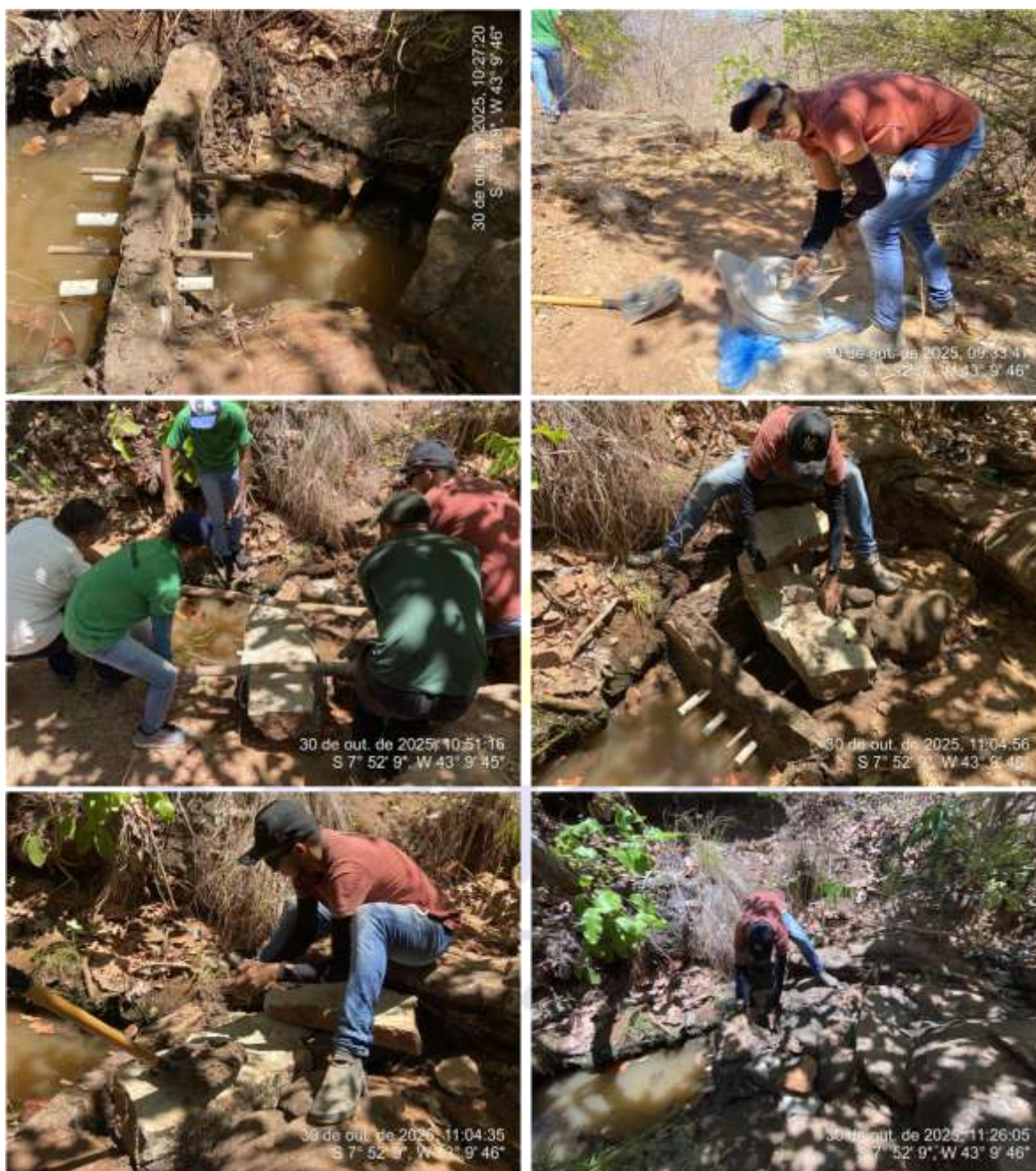
Figura 6. Aplicação da técnica de proteção através do modelo caxambu na nascente na localidade Várzea Grande, zona rural do município de Pavussu-PI. Fonte: Figura do autor. (2025)
