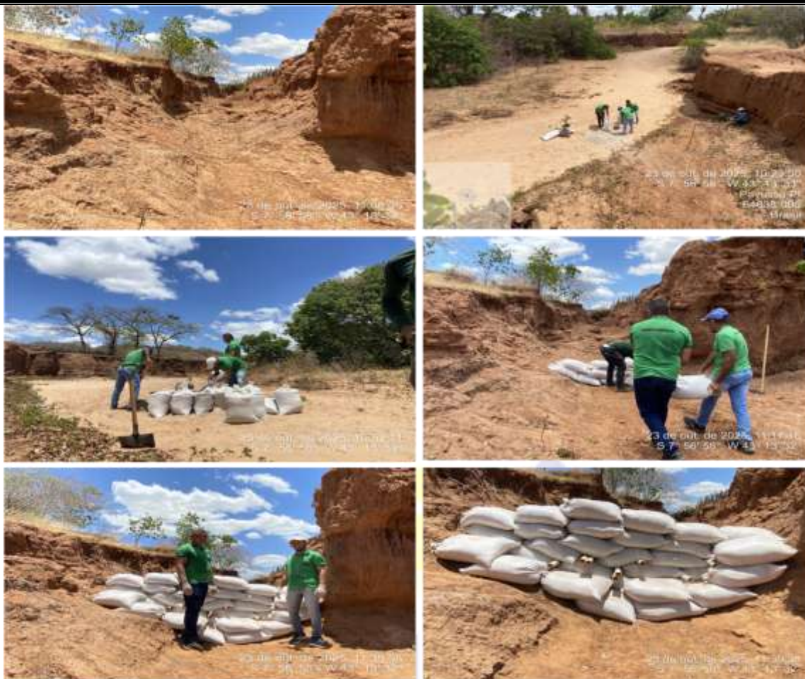
Figura 2. Construção da barreira física na área degradada para proteger o solo.
