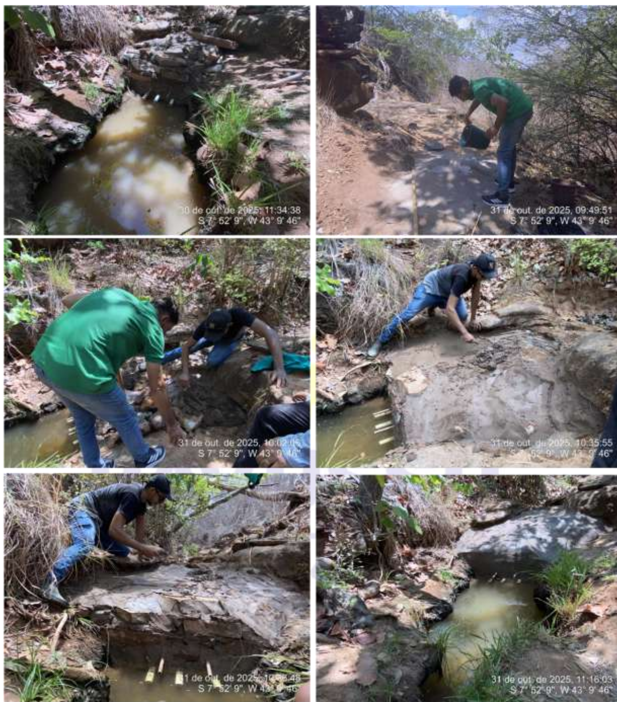
Figura 7. Aplicação da técnica de proteção através do modelo caxambu na nascente na localidade Várzea Grande, zona rural do município de Pavussu-PI. Fonte: Figura do autor. (2025)
