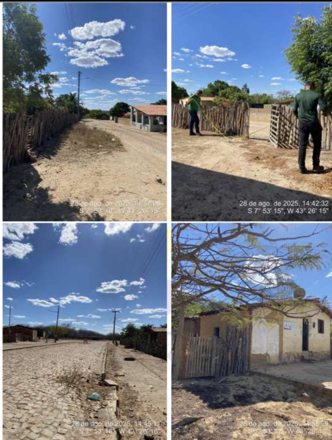
Figura 3. Rua pavimentada e não pavimentada do Assentamento Jatoba e Fiscais ambientais realizando as medições dos lotes. Fonte: Figura do autor. (2025)
