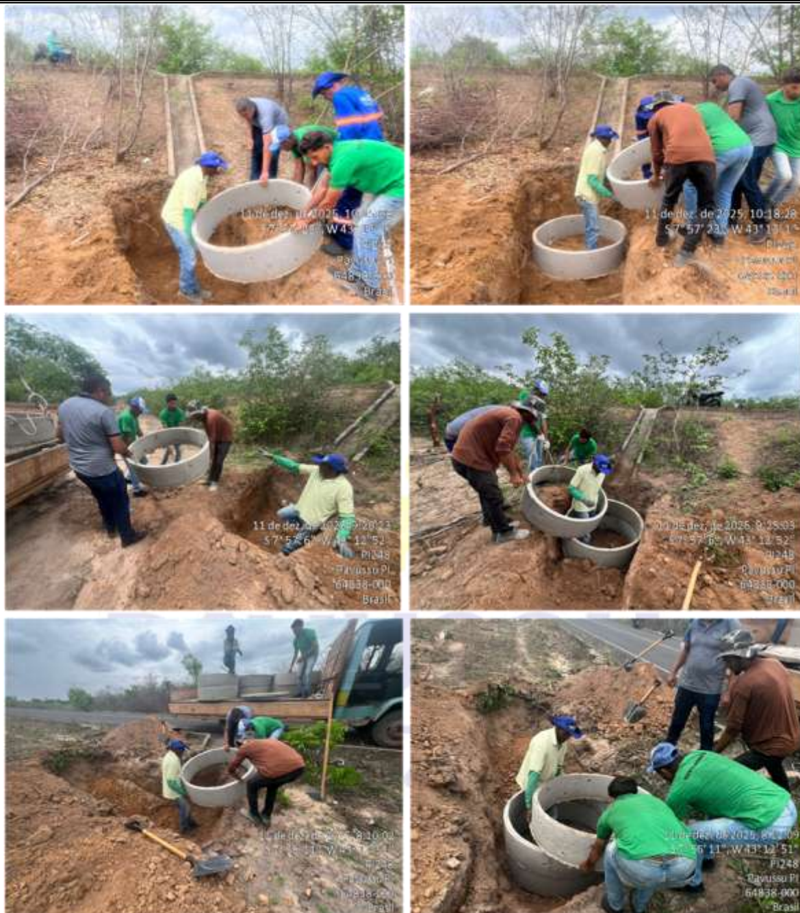
Figura 3. Inserção das manilhas nos pontos, em Pavussu-PI. Fonte: Figura do autor. (2025)
