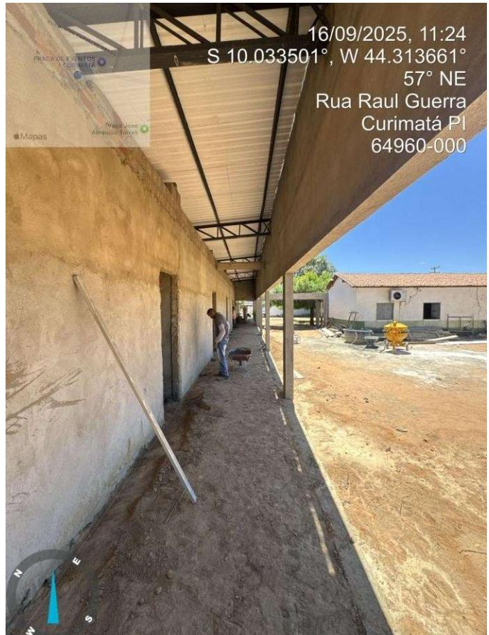
**SERVIÇOS: FINALIZAÇÃO DE REBOCO, EXECUÇÃO DE TELHADO - 100%, EXECUÇÃO DE SISTEMA HIDRAULICO E HIDROSSANITÁRIO, EXECUÇÃO DE INSTALAÇÃO ELETRICQ, EXECUÇÃO DE TALISCAGEM PARA CONTRAPISO**
