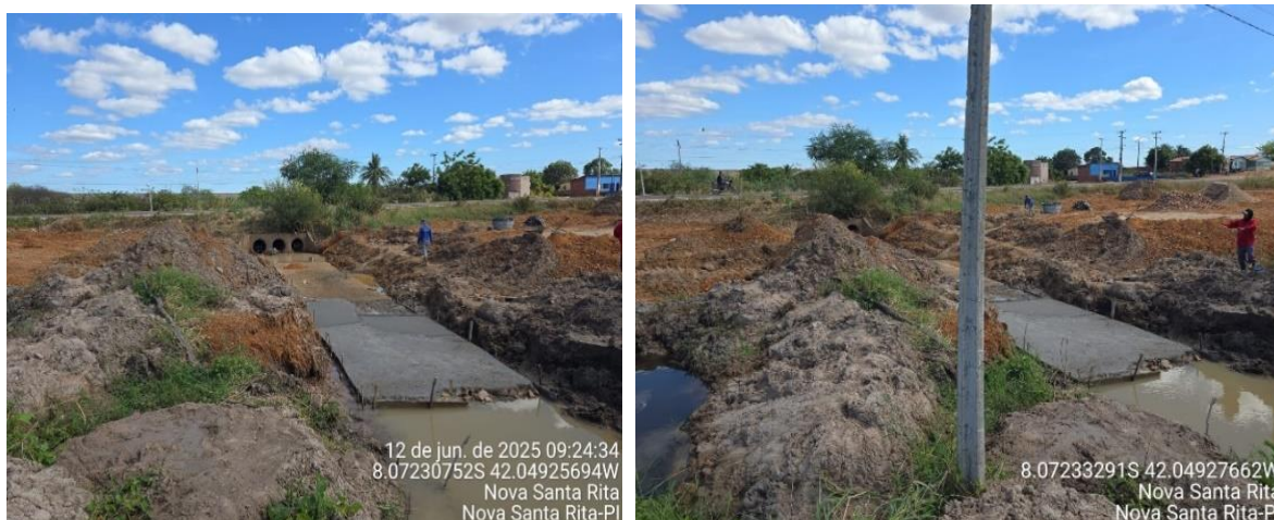
Figura 12 - Ampliação do bueiro da praça
