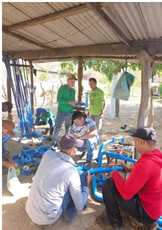
Figura 8. Instalação de sistemas de irrigação para a produção de hortaliças. Tanque do Piauí, 2025.
