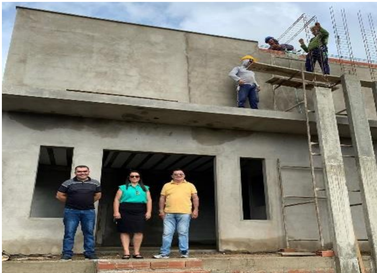
Figura 69 – Visita à Obra da Sede da Prefeitura Municipal (Jan/23)
