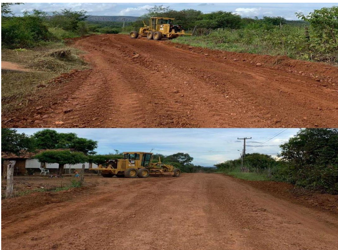
Figura 161 - Recuperação de estradas vicinais, trecho que liga as localidades Lagoa seca e Engano. Santana do Piauí, 2023.
