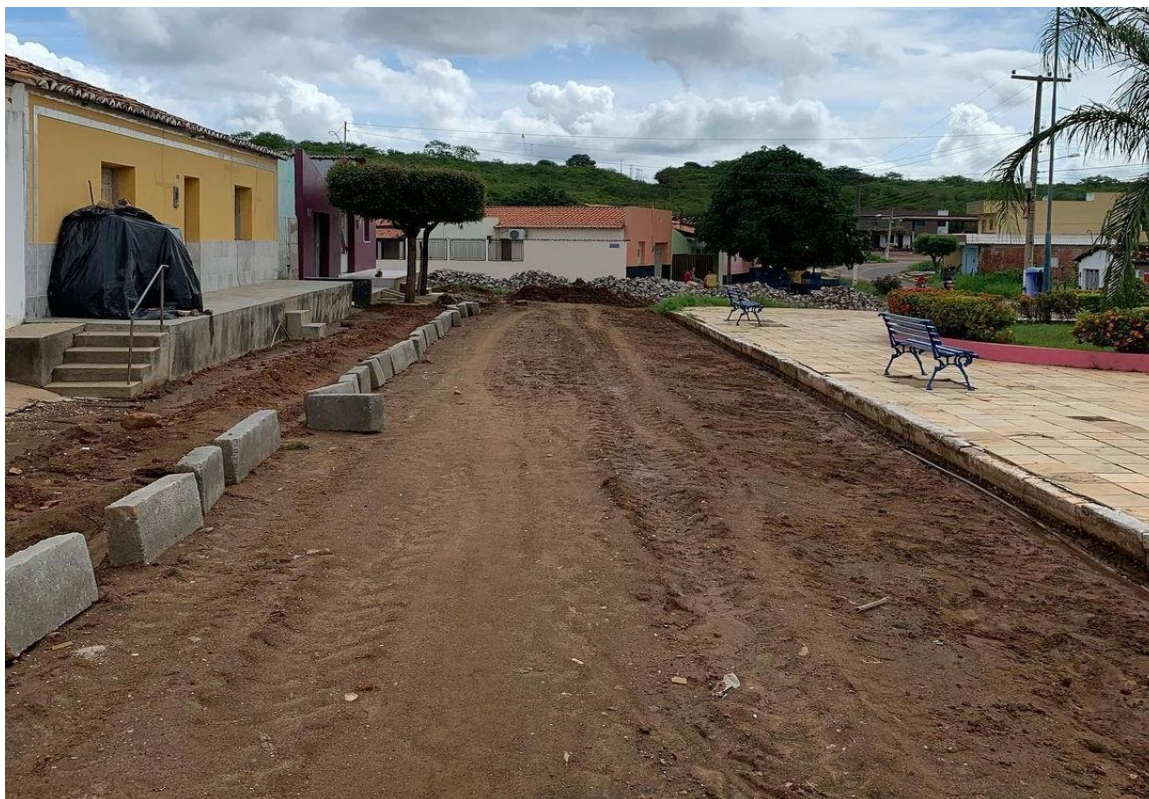
Figura 158 – Obras de pavimentação poliédrica na Rua praça São Sebastião. Santana do Piauí, 2023
