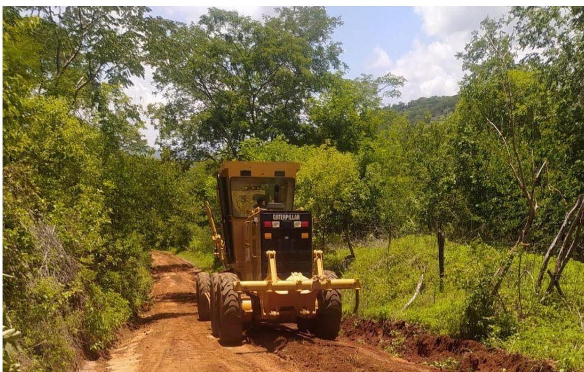
Figura 159 - Recuperação de estradas vicinais que liga Santana do Piauí a comunidade Juai. Santana do Piauí, 2023.
