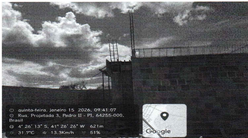
EXECUÇÃO DE PILARES E VIGAS
