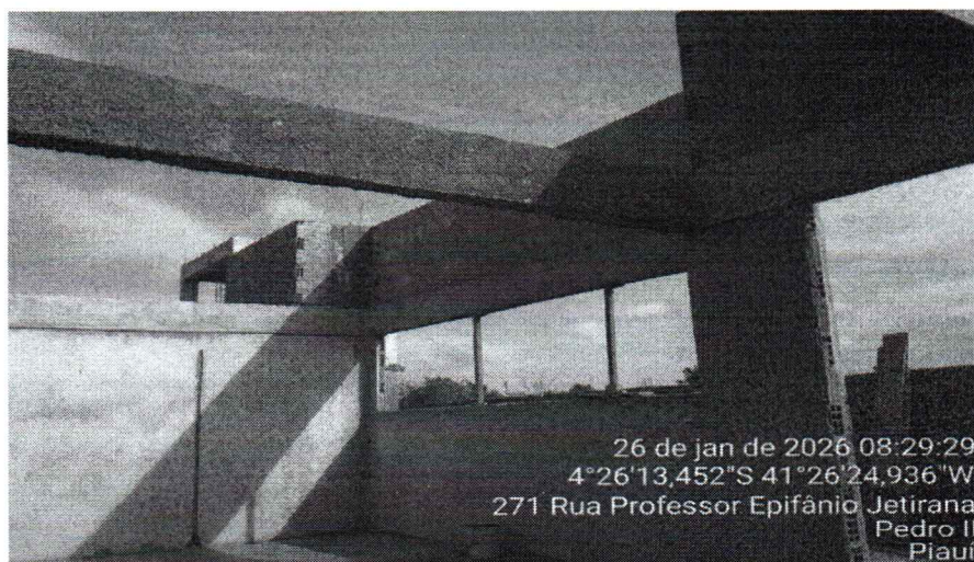
EXECUÇÃO DE REBOCO E PISO INTERNO
