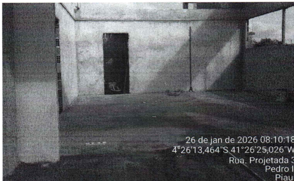
EXECUÇÃO DE REBOCO E PISO INTERNO
