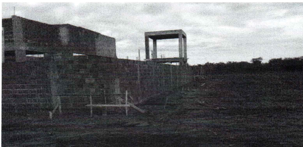
EXECUÇÃO DE MURO
