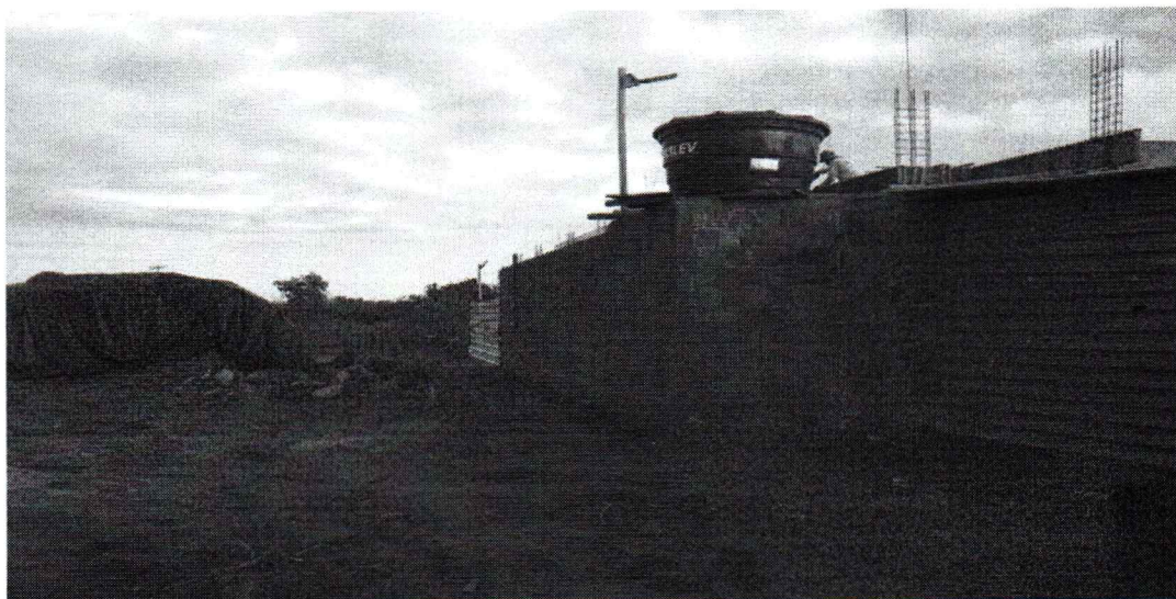
EXECUÇÃO DE MURO
