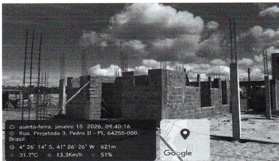
EXECUÇÃO DE ALVENARIA DE VEDAÇÃO, EXECUÇÃO DE PILARES E VIGAS
