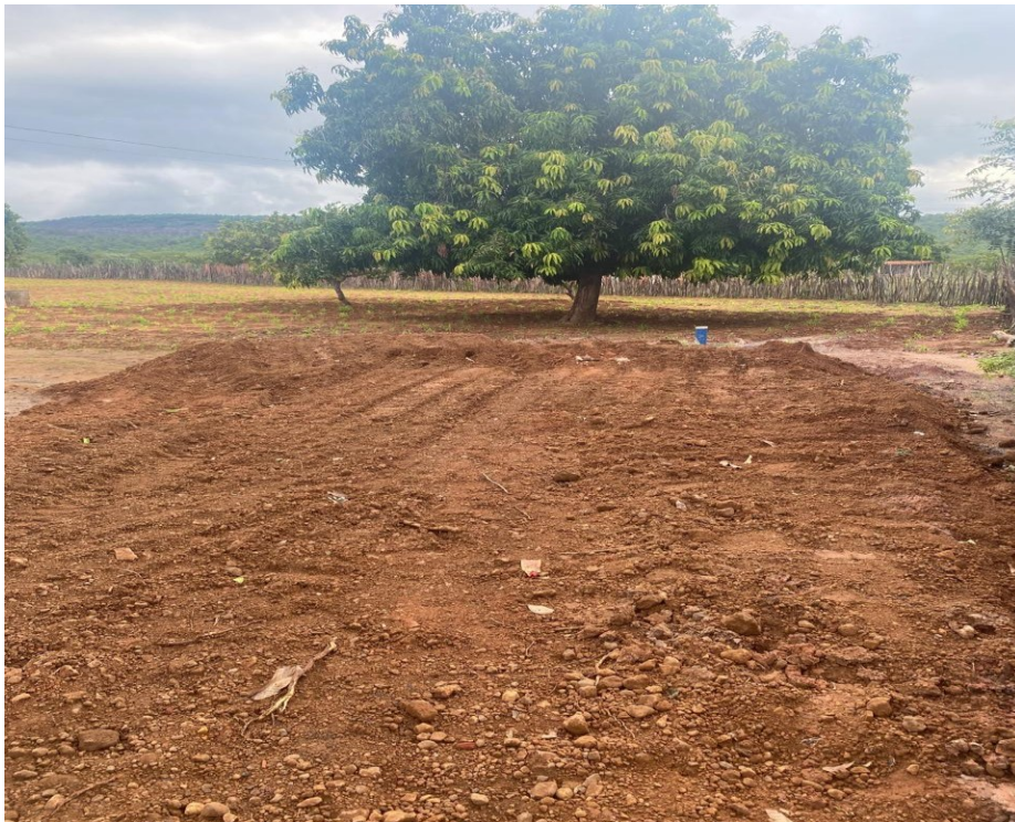
Figura 61: Perfuração de Poço – Comunidade Alegre
