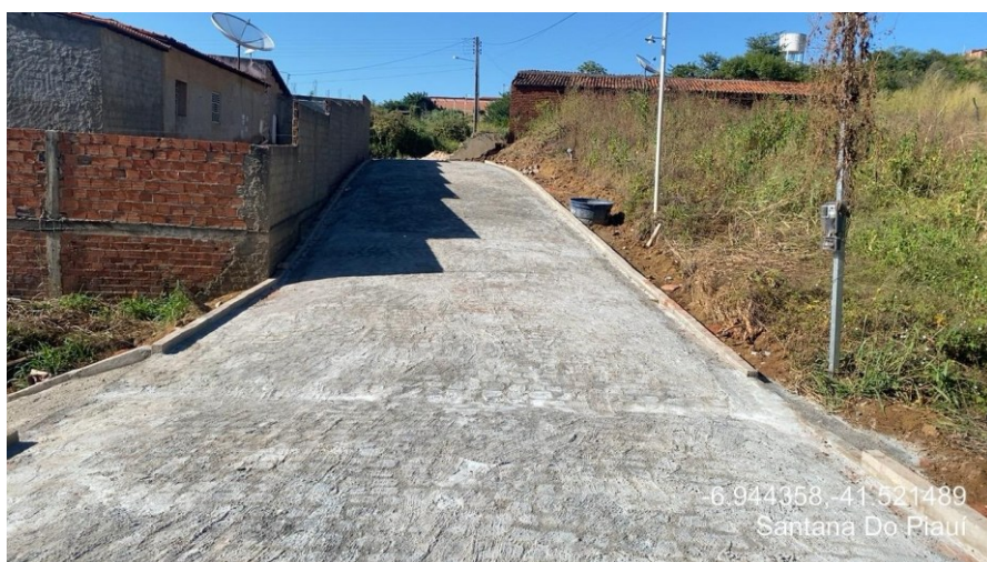
Figura 56: Pavimentação poliédrica Recanto do Sossego
