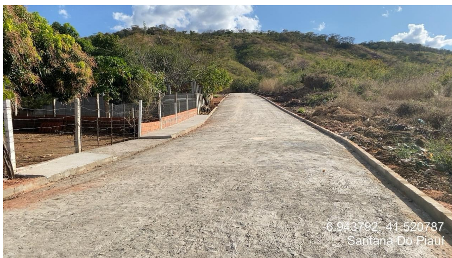
Figura 57: Pavimentação poliédrica Rua Projetada 02
