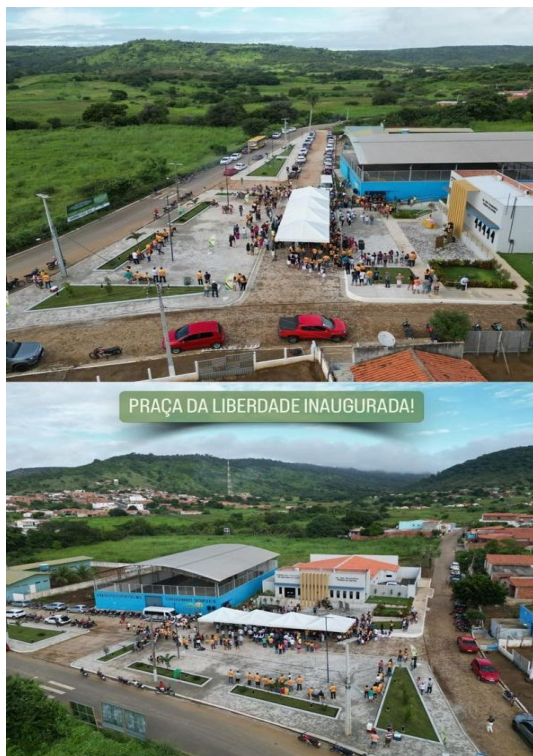
Figura 62: Reforma e Construção de Praça da Liberdade e São Sebastião
