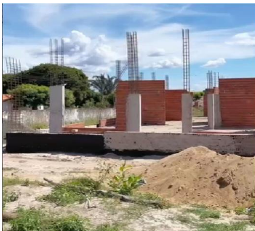
Construção de UBS Tipo I
