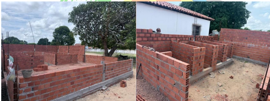
Construção de refeitórios e banheiros na escola Nossa Senhora da Conceição
