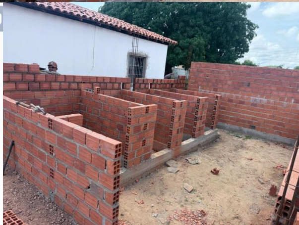
Construção de refeitórios e banheiros na Escola Nossa Senhora da Conceição
