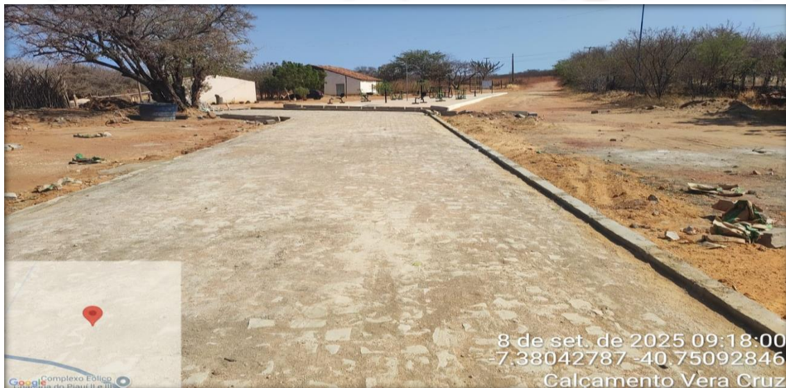
Foto da obra concluída da Pavimentação Em Paralelepípedo Zona Urbana (Foto Autoral)
