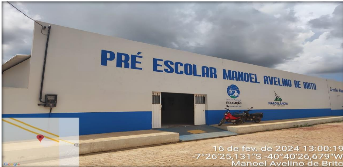
Foto do serviço de manutenção de patrimônios públicos sendo executado (Foto Autoral)
