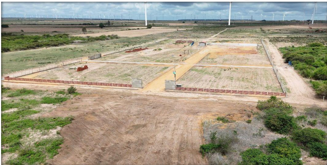
Foto da construção do Parque de Eventos (Foto Autoral)
