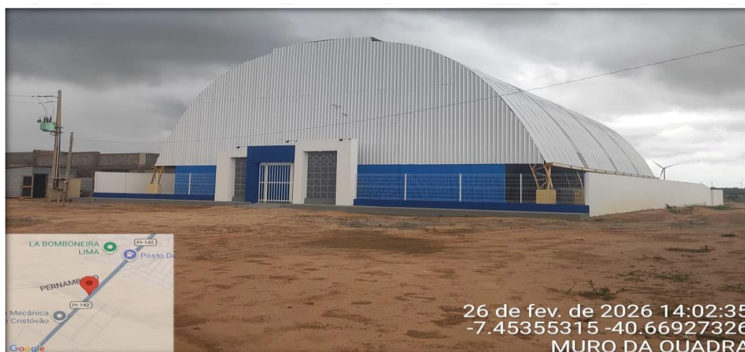
Foto da obra Concluída da Muro da Quadra Jardim Brasil (Foto Autoral)
