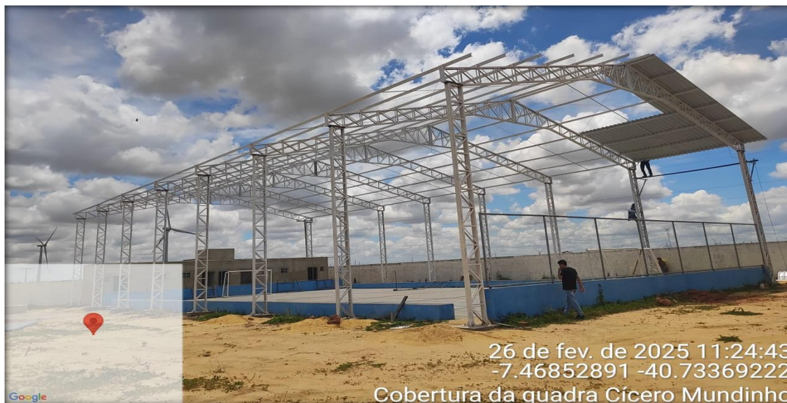
Foto da obra Concluída da Cobertura da Quadra (Foto Autoral)
