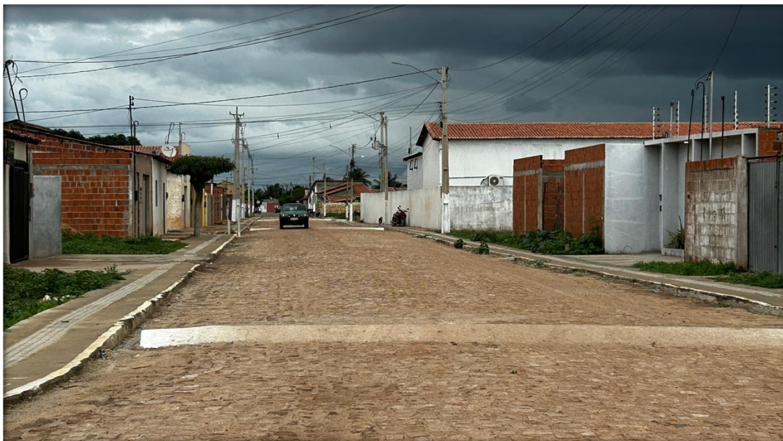
Foto da obra concluída da Pavimentação Em Paralelepípedo Zona Urbana (Foto Autoral)
