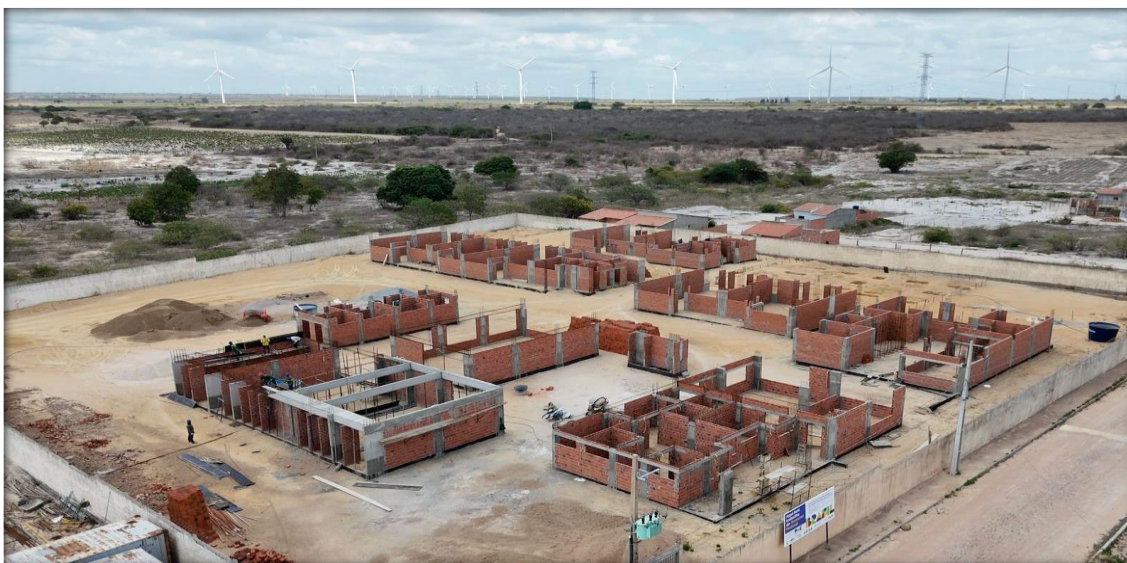
Foto da construção da escola 9 salas (Foto Autoral)
