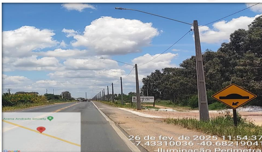
Foto da obra concluída da subestação (Foto Autoral)
