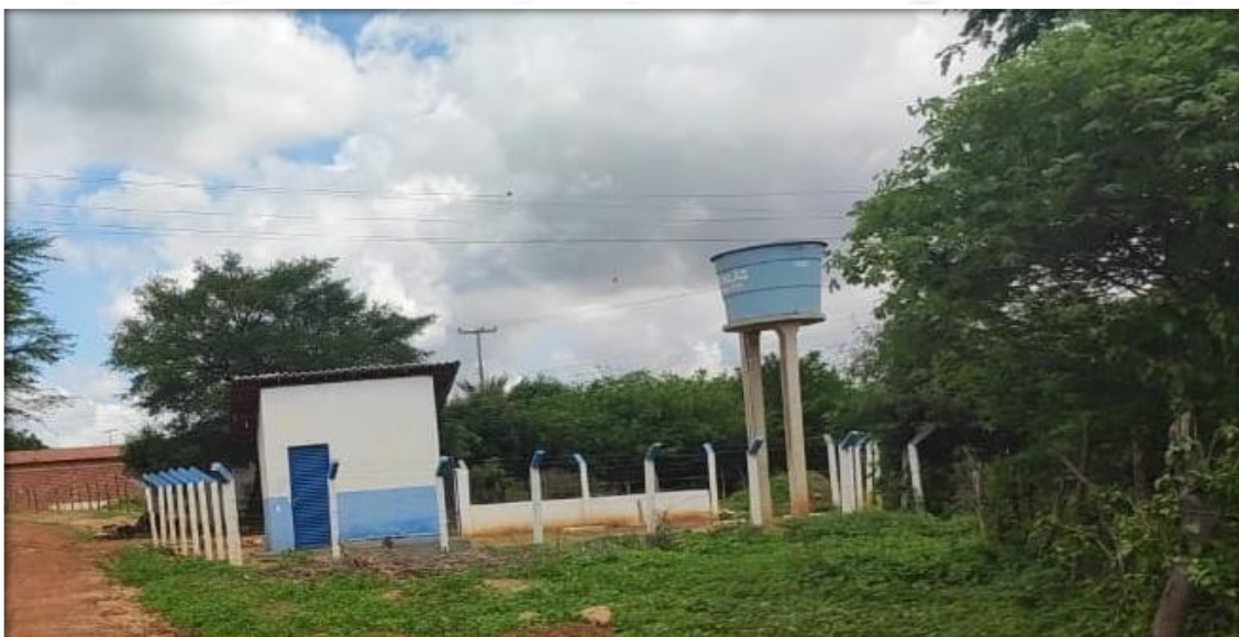
Foto do poço reformado (Foto Autoral)
