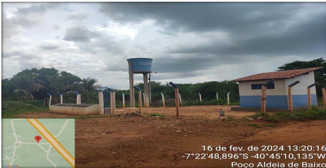
Foto da obra concluída da Reforma dos Poços Tubulares (Foto Autoral)
