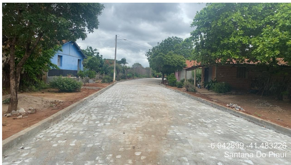
Figura 44 - Rua Projetada - Localidade Cancão
