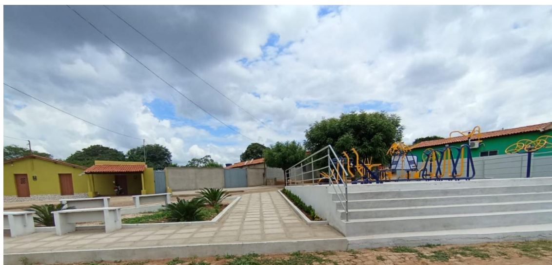
Figura 47 – Construção de Academia de saúde - Lagoa dos Marcelinos
