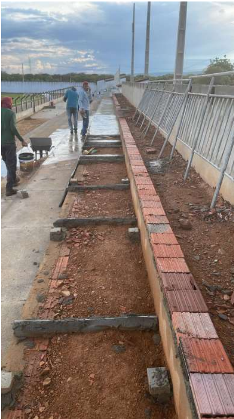
Foto 3: Execução das juntas
