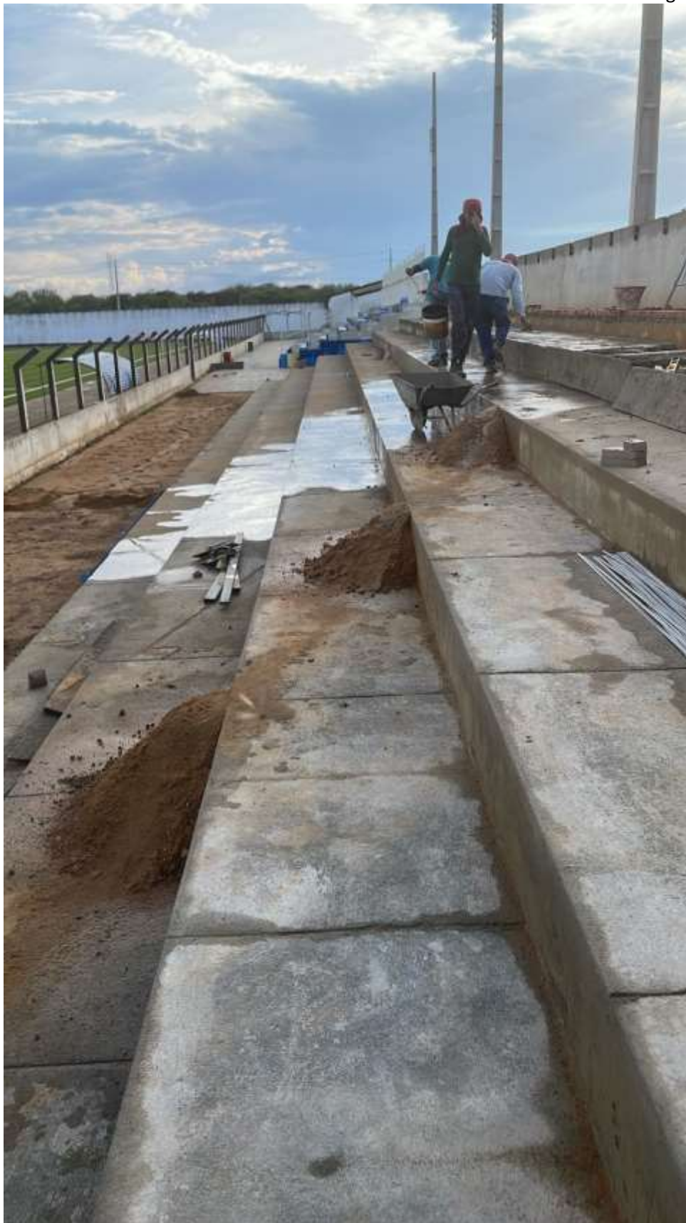
Foto 2: Piso com juntas de dilatação
