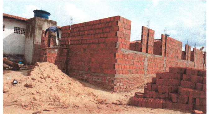
EXECUÇÃO DE ALVENARIA
