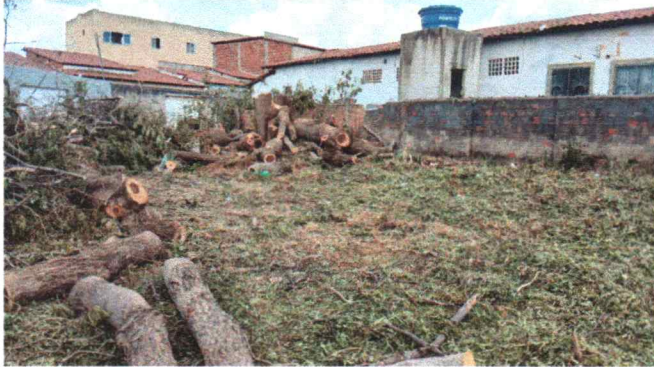
LIMPEZA DO TERRENO
