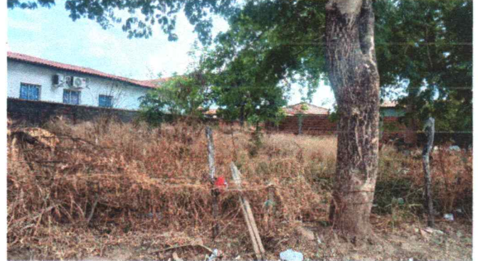
LIMPEZA DO TERRENO
