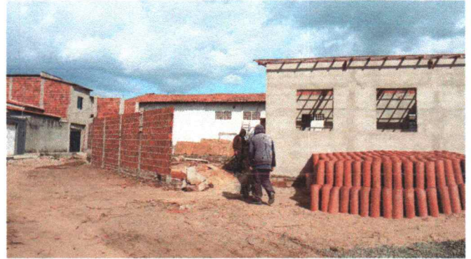
EXECUÇÃO DE ALVENARIA
