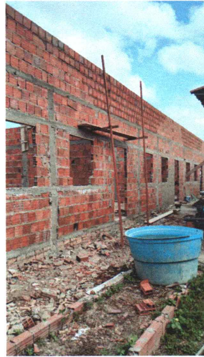
EXECUÇÃO DE ALVENARIA
