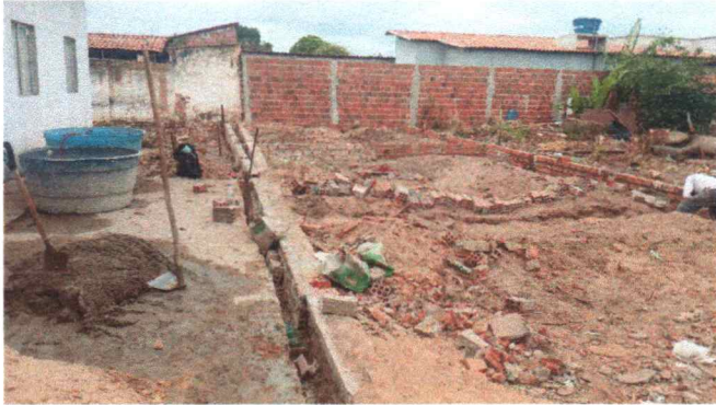
EXECUÇÃO DE ALVENARIA
