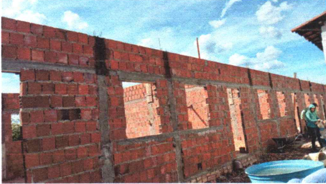
EXECUÇÃO DE ALVENARIA
