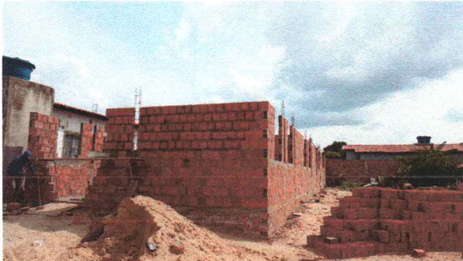
EXECUÇÃO DE ALVENARIA
