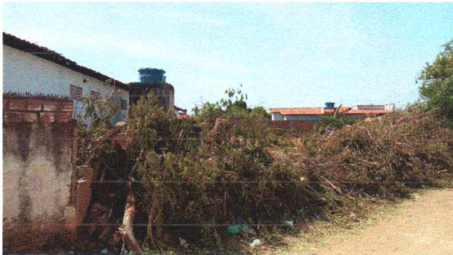
LIMPEZA DO TERRENO
