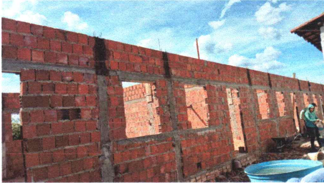
EXECUÇÃO DE ALVENARIA
