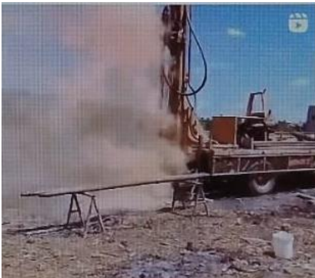
Política de abastecimento de água potável no campo: Perfuração de poço artesiano
