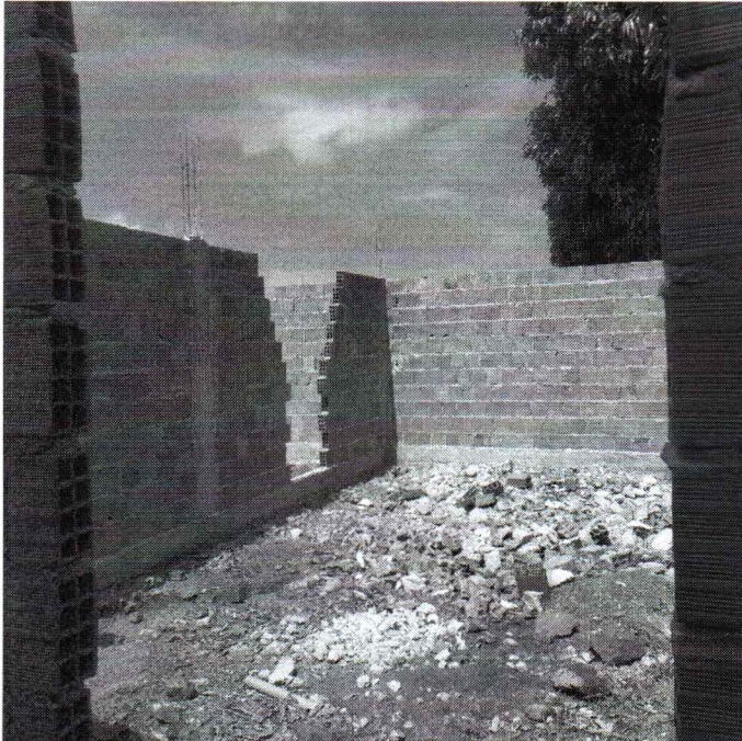
EXECUÇÃO DE ALVENARIA
