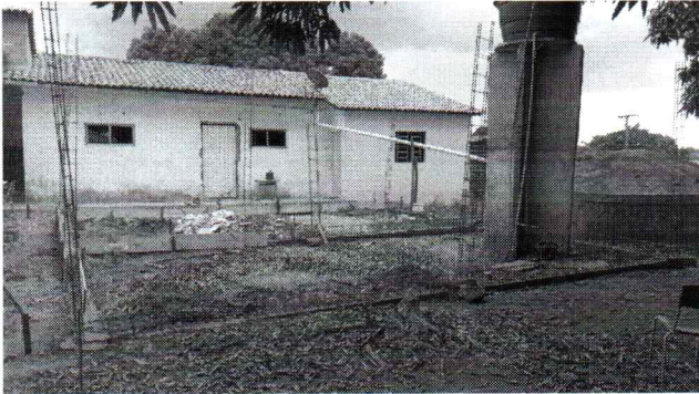
EXECUÇÃO DE VIGA BALDRAME
