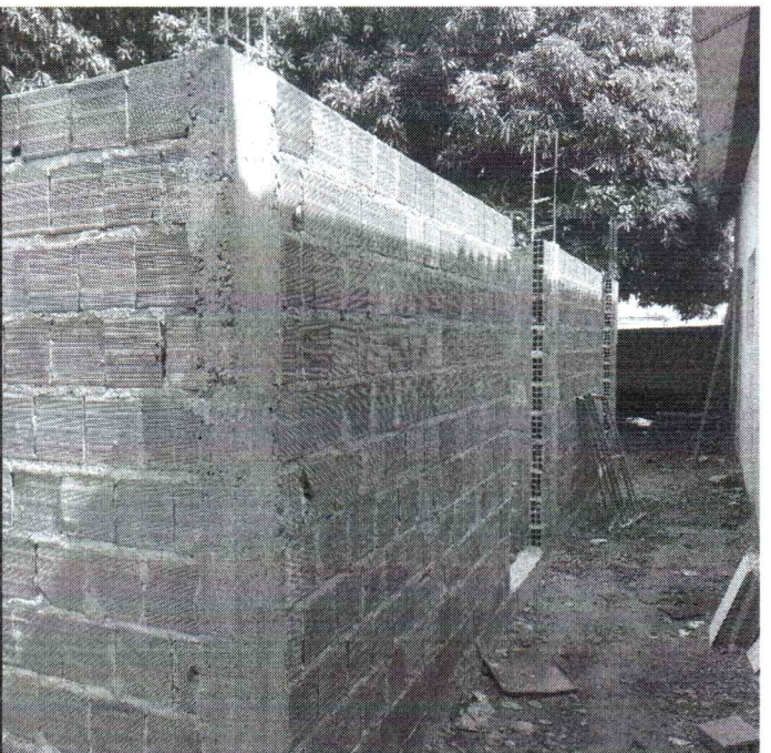
EXECUÇÃO DE ALVENARIA
