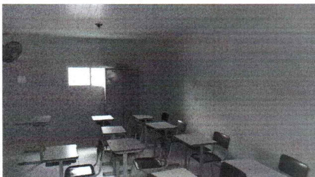
EXECUÇÃO DE PINTURA INTERNA
