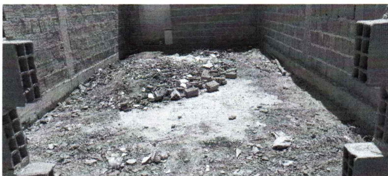
EXECUÇÃO DE ALVENARIA
