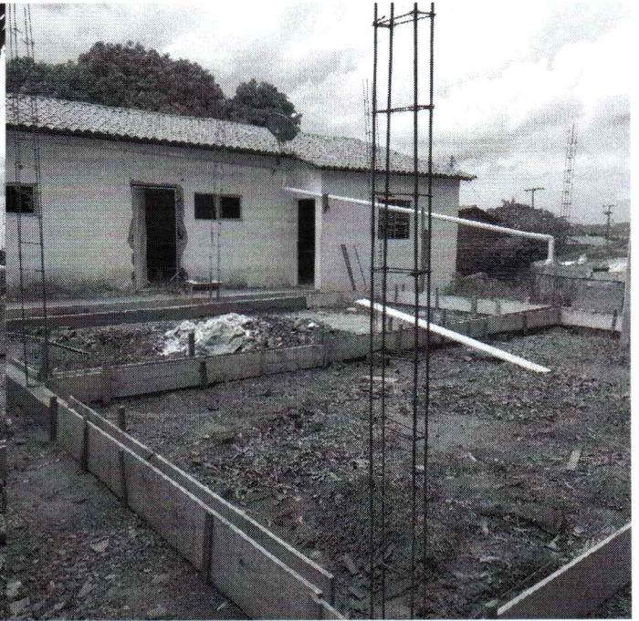
EXECUÇÃO DE VIGA BALDRAME
