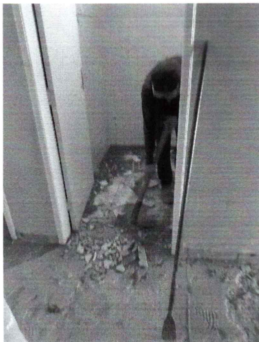
DEMOLIÇÃO DE REVESTIMENTO CERÂMICO EM PISO
