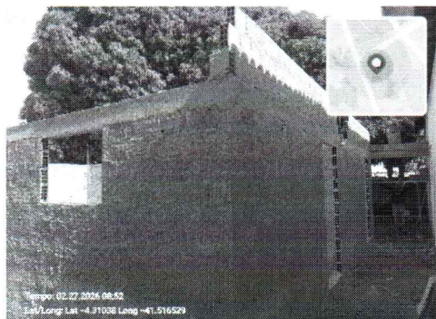
EXECUÇÃO DE ALVENARIA COM BLOCOS CERÂMICOS
