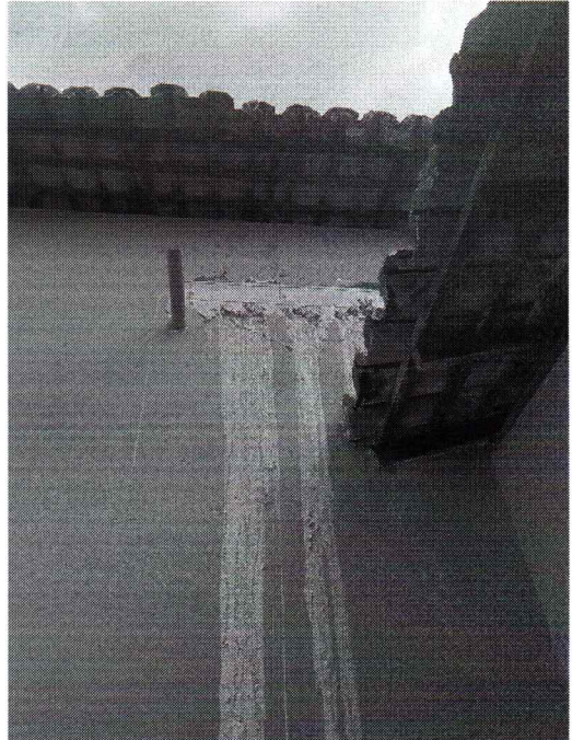
EXECUÇÃO DE REFORÇO EM PAREDES DE ALVENARIA
