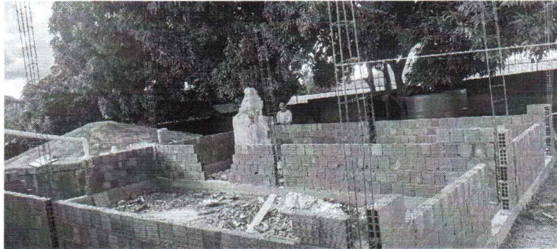
EXECUÇÃO DE PAREDES EM ALVENARIA
