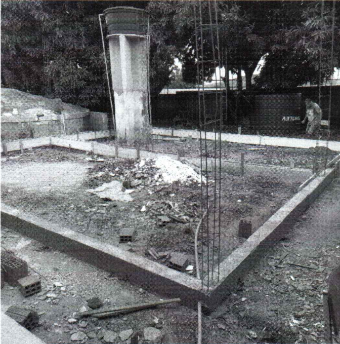
EXECUÇÃO DE VIGA BALDRAME
