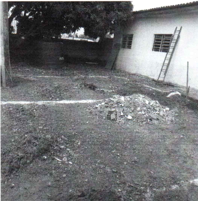
EXECUÇÃO DE ESCAVAÇÃO MANUAL E LIMPEZA DO TERRENO
