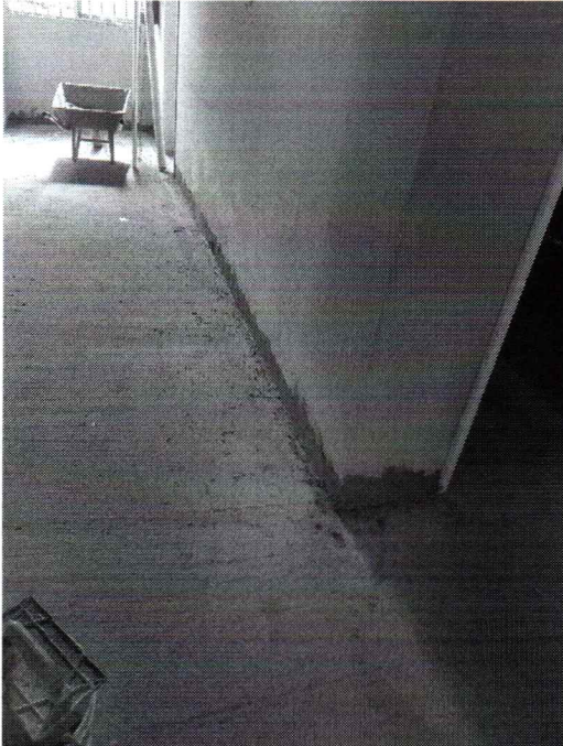
EXECUÇÃO DE CONTRAPISO
