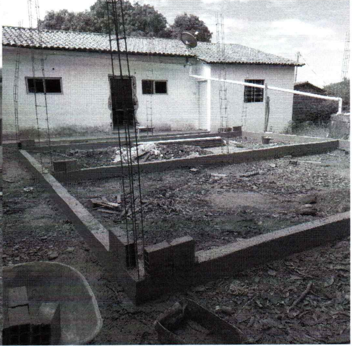
EXECUÇÃO DE ALVENARIA
