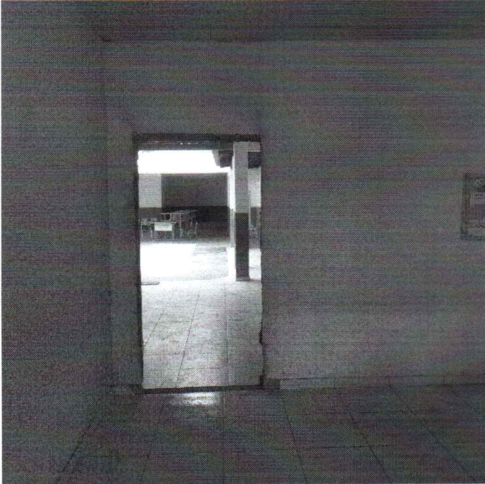
DEMOLIÇÃO EM PAREDE DE ALVENARIA
