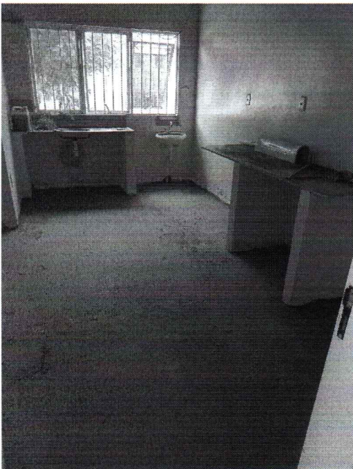
EXECUÇÃO DE CONTRAPISO
