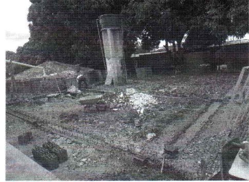
EXECUÇÃO DE VIGA BALDRAME
