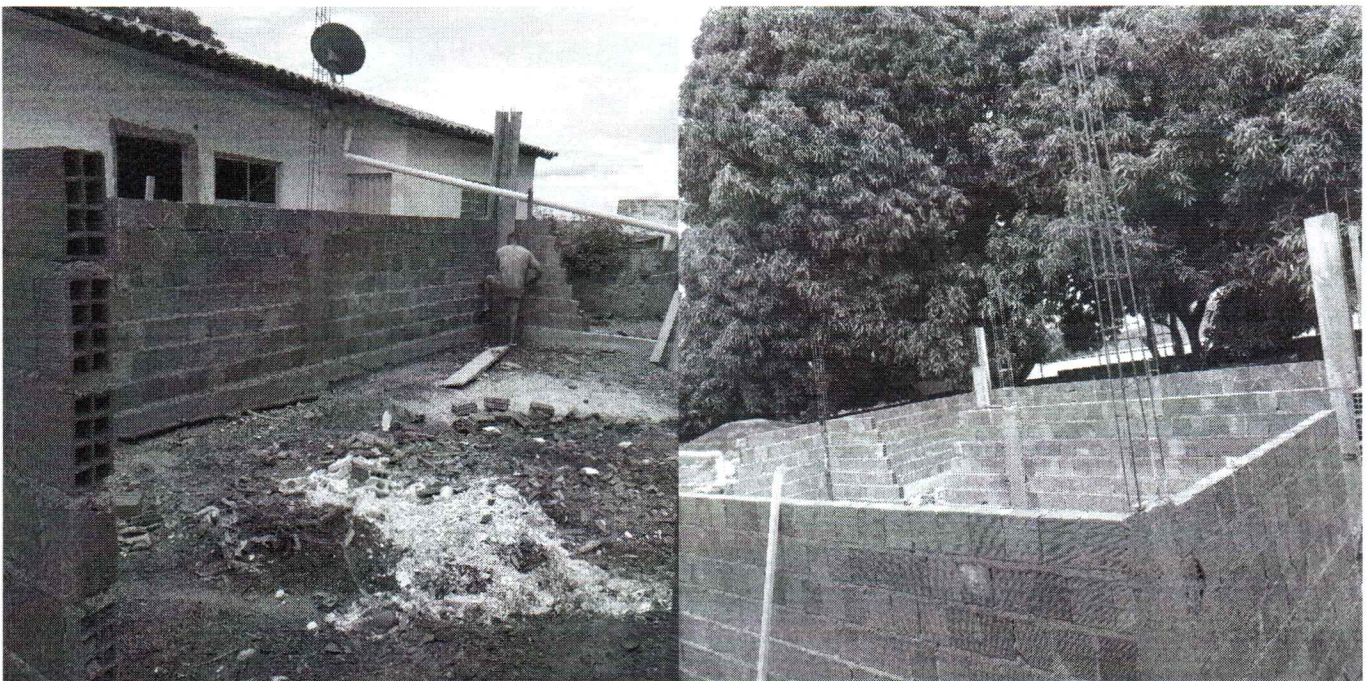
EXECUÇÃO DE ALVENARIA
