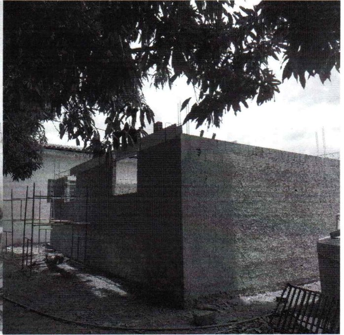
EXECUÇÃO DE CHAPISCO EM PAREDES DE ALVENARIA
