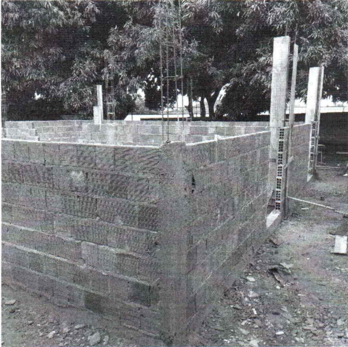
EXECUÇÃO DE ALVENARIA
