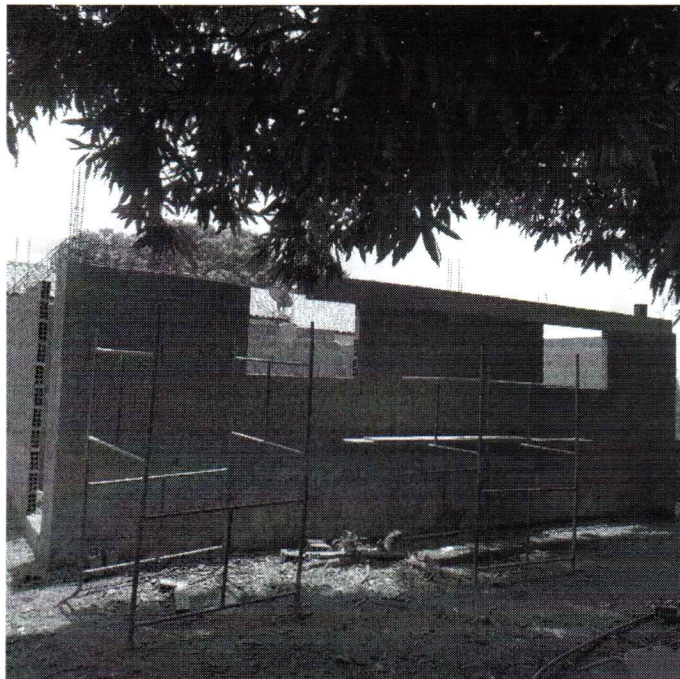
EXECUÇÃO DE FÔRMAS E CHAPISCO
