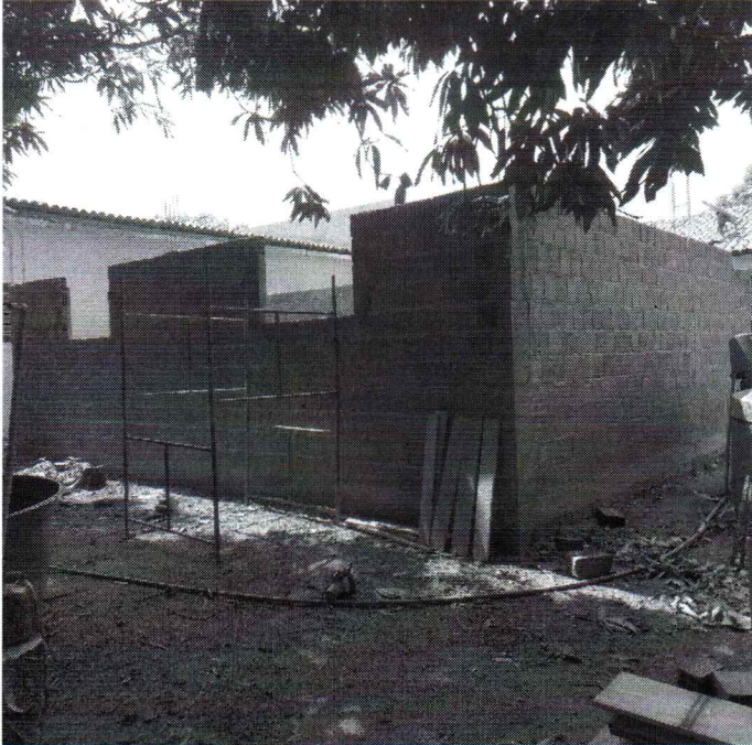
EXECUÇÃO DE ALVENARIA
