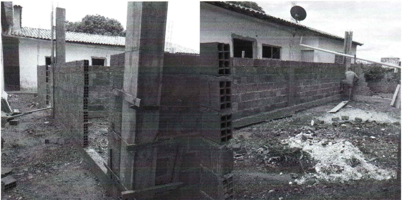
EXECUÇÃO DE PAREDES EM ALVENARIA
