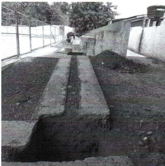
ESCAVAÇÃO DE SOLO PARA EXECUÇÃO DE SAPATAS ISOLADAS ESCAVAÇÃO DE SOLO PARA EXECUÇÃO DE SAPATAS ISOLADAS
