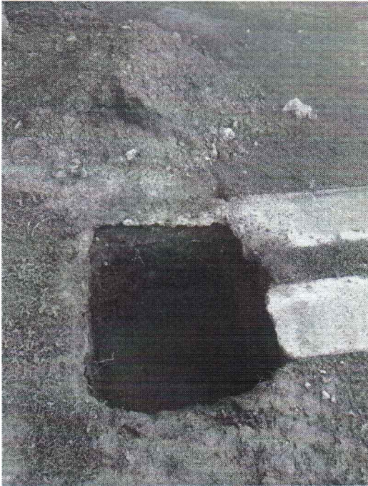
ESCAVAÇÃO DE SOLO PARA EXECUÇÃO DE SAPATAS ISOLADAS
