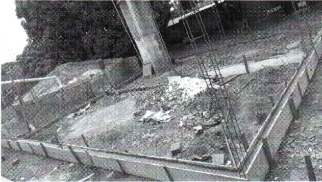
EXECUÇÃO DE VIGA BALDRAME
