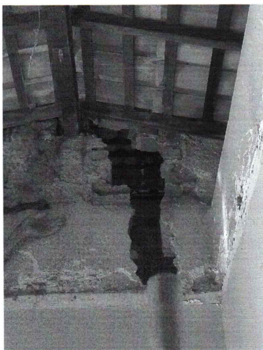
EXECUÇÃO DE REFORÇO EM RACHADURAS
