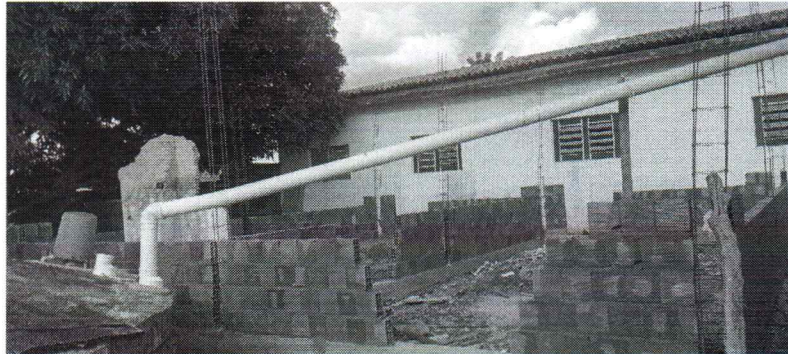
EXECUÇÃO DE PAREDES EM ALVENARIA
