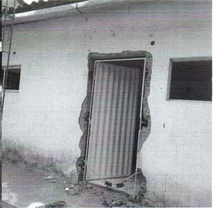
INSTALAÇÃO DE PORTA METÁLICA
