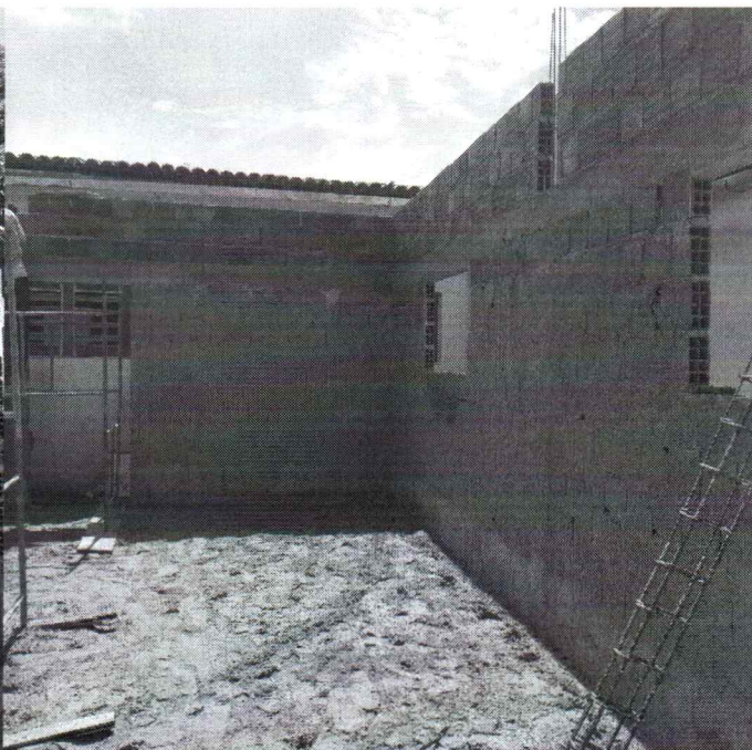
EXECUÇÃO DE CHAPISCO EM PAREDES
