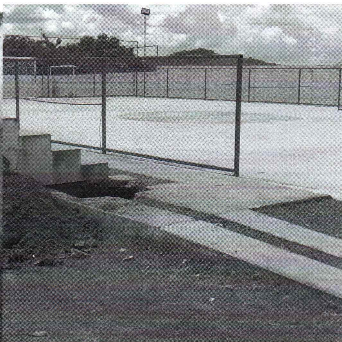
ESCAVAÇÃO DE SOLO PARA EXECUÇÃO DE SAPATAS ISOLADAS ESCAVAÇÃO DE SOLO PARA EXECUÇÃO DE SAPATAS ISOLADAS
