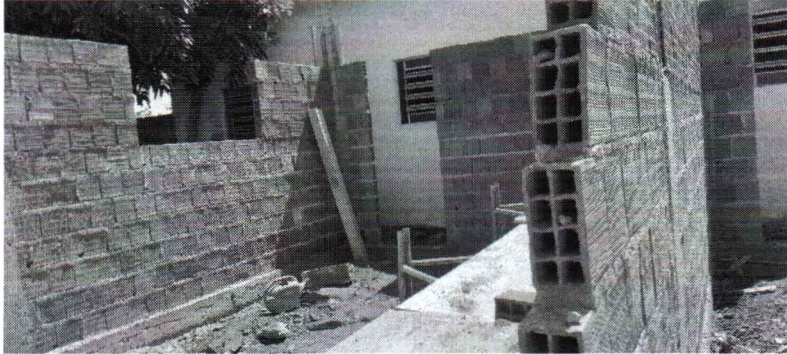
EXECUÇÃO DE ALVENARIA
