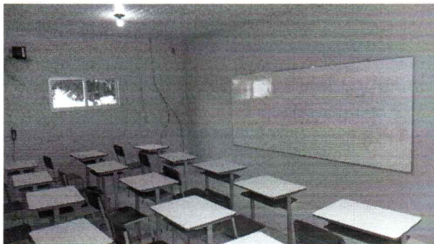
EXECUÇÃO DE PINTURA INTERNA
