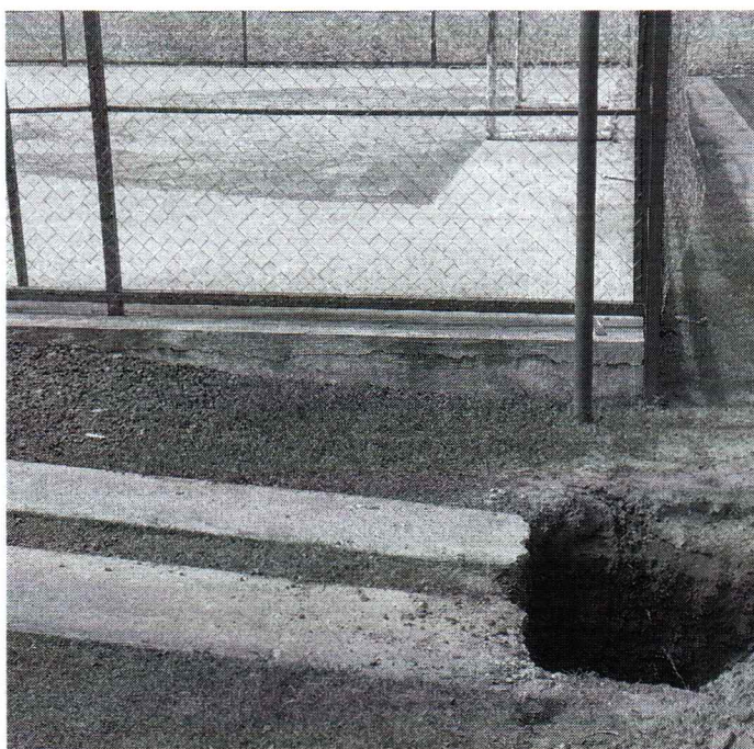
ESCAVAÇÃO DE SOLO PARA EXECUÇÃO DE SAPATAS ISOLADAS
