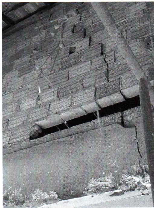
EXECUÇÃO DE REFORÇO EM RACHADURAS
