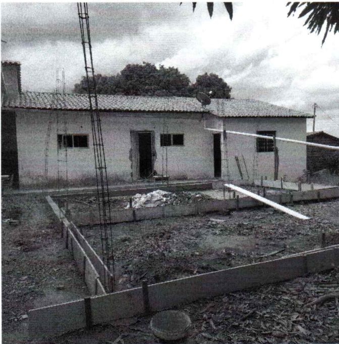
EXECUÇÃO DE VIGA BALDRAME
