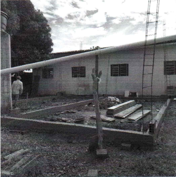
EXECUÇÃO DE ALVENARIA
