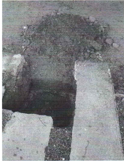
ESCAVAÇÃO DE SOLO PARA EXECUÇÃO DE SAPATAS ISOLADAS
