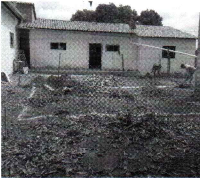
EXECUÇÃO DE ESCAVAÇÃO MANUAL E LIMPEZA DO TERRENO
