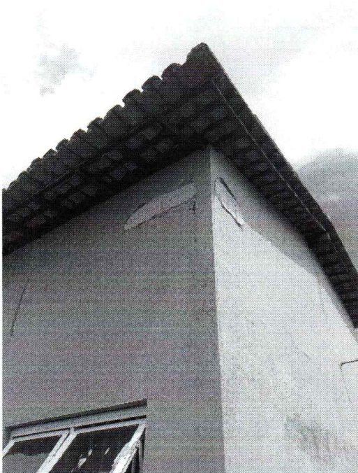
EXECUÇÃO DE REFORÇO EM PAREDES DE ALVENARIA
