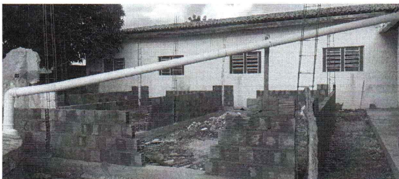
EXECUÇÃO DE PAREDES EM ALVENARIA
