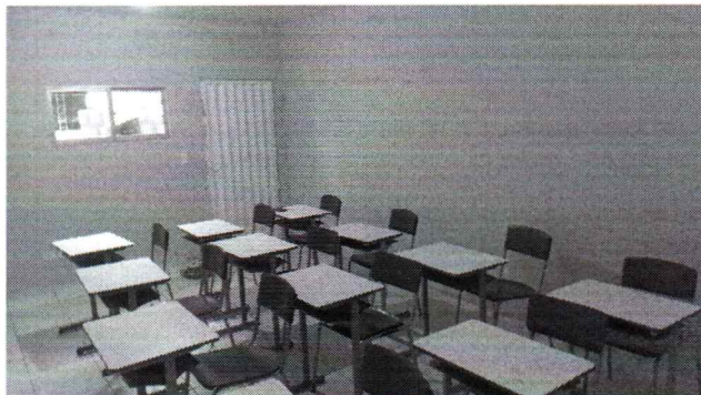
EXECUÇÃO DE PINTURA INTERNA
