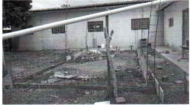
EXECUÇÃO DE VIGA BALDRAME
