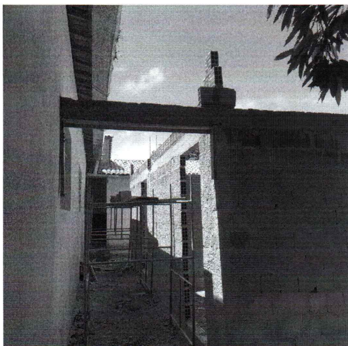
EXECUÇÃO DE ALVENARIA COM BLOCOS CERÂMICOS
