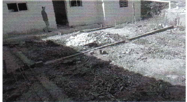
EXECUÇÃO DE VIGA BALDRAME
