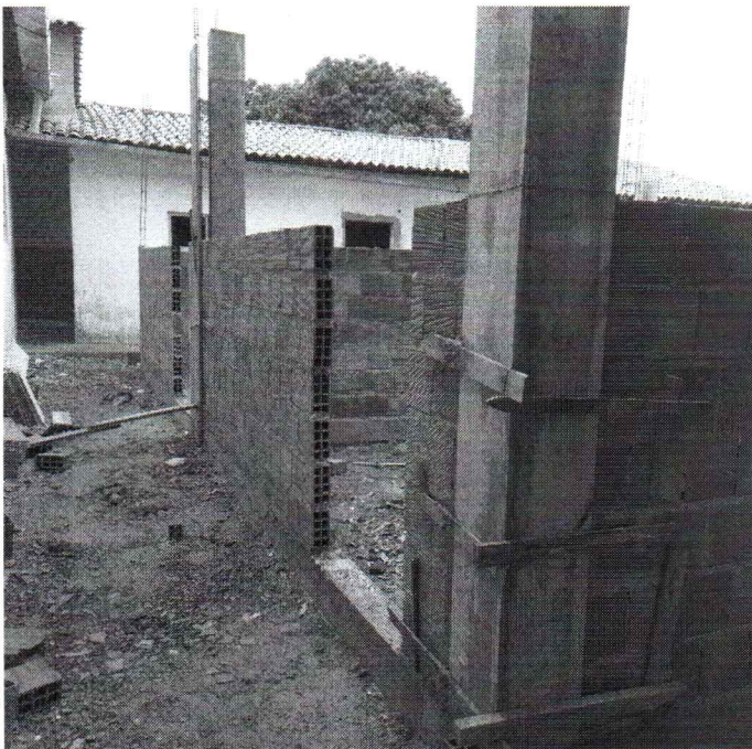
EXECUÇÃO DE ALVENARIA
