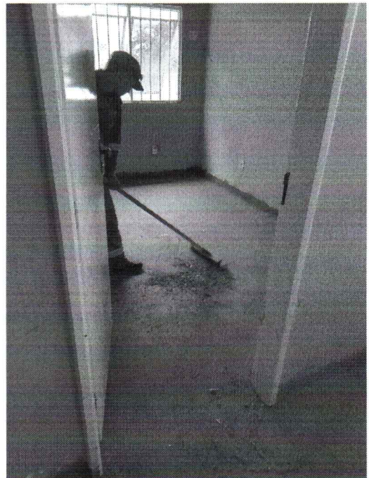
EXECUÇÃO DE CONTRAPISO
