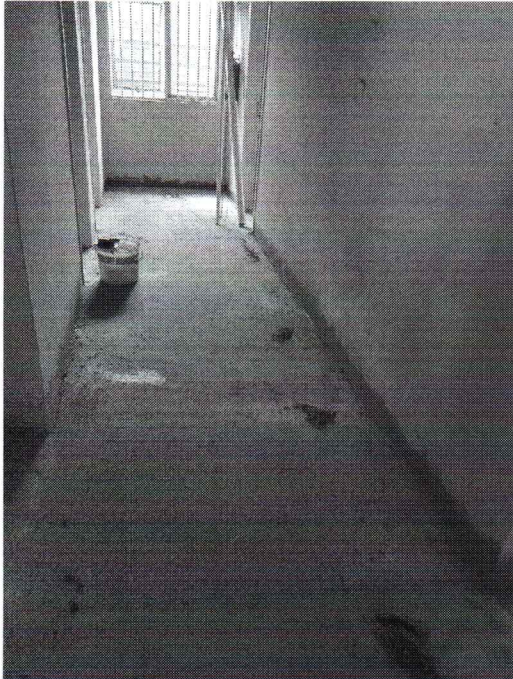
EXECUÇÃO DE CONTRAPISO
