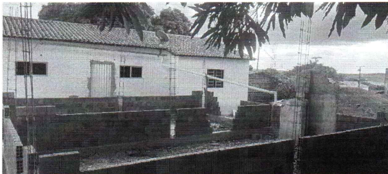
EXECUÇÃO DE PAREDES EM ALVENARIA
