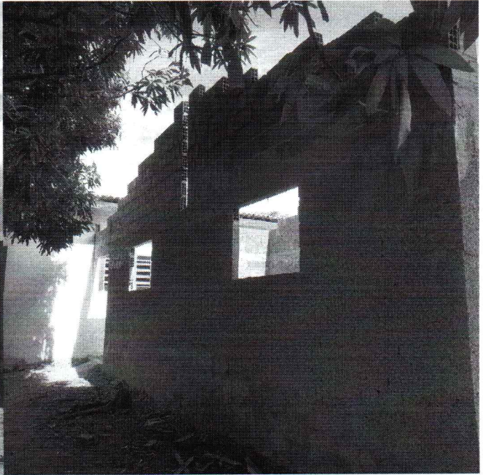
EXECUÇÃO DE PAREDES EM ALVENARIA
