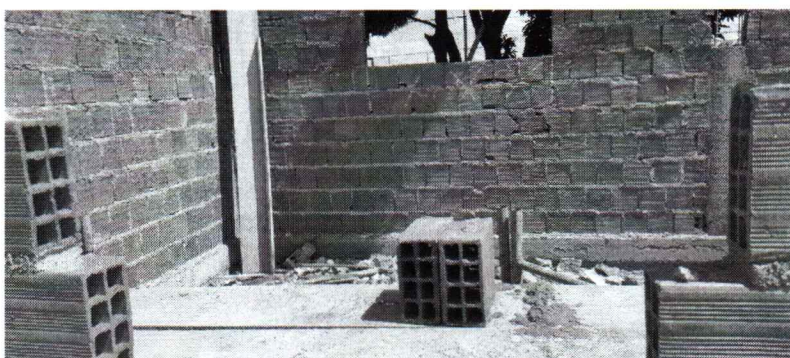
EXECUÇÃO DE ALVENARIA
