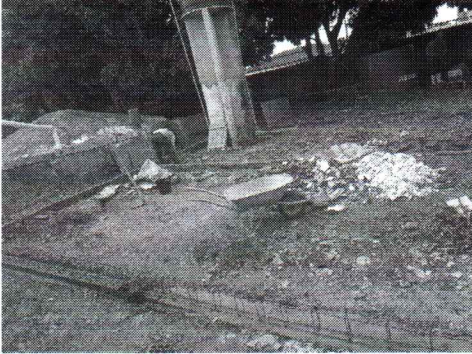
EXECUÇÃO DE VIGA BALDRAME
