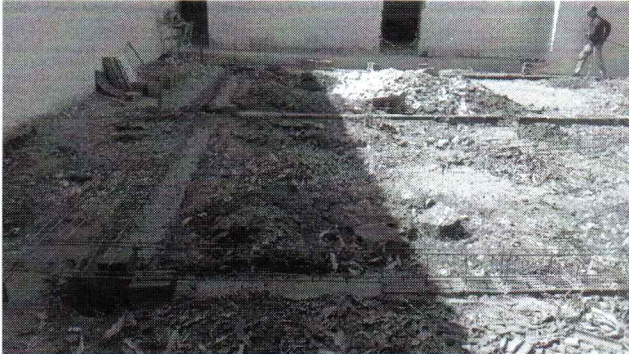
EXECUÇÃO DE VIGA BALDRAME
