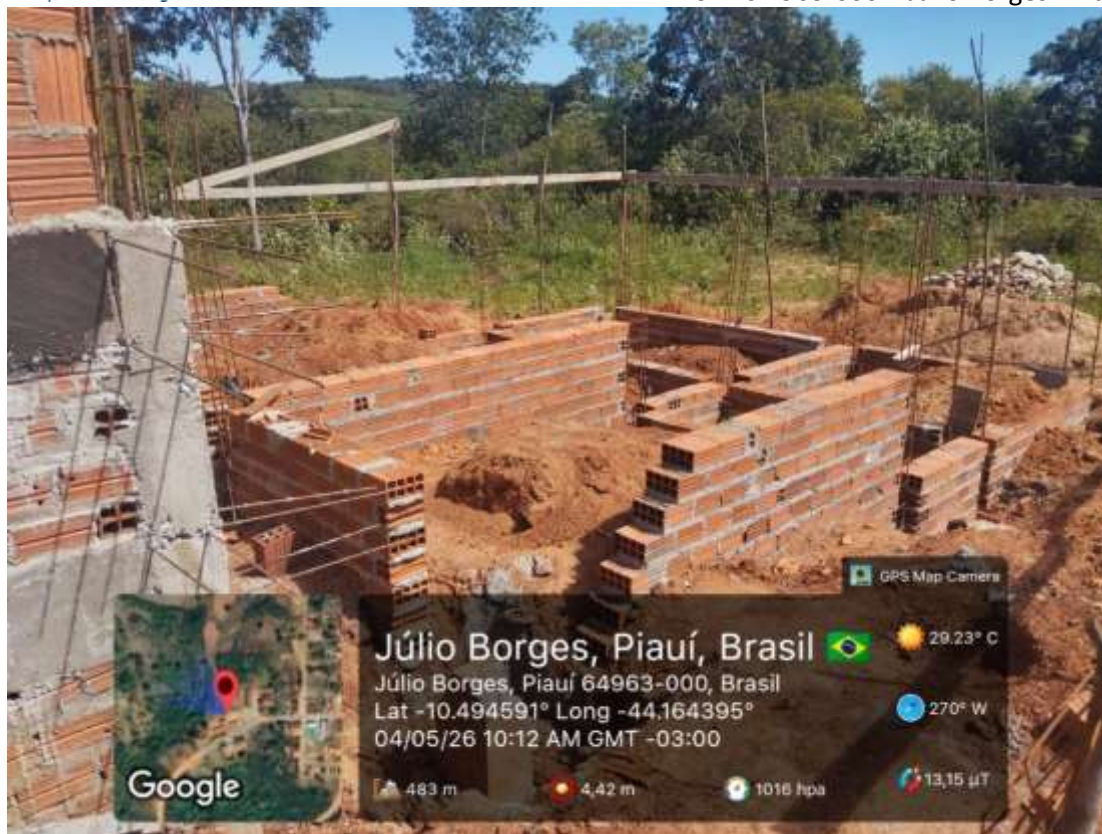
Foto 4: Execução de baldrame
