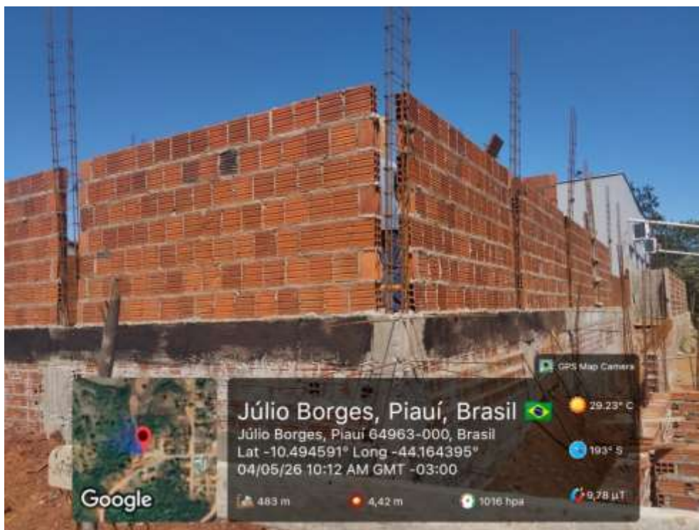
Foto 1: Levantamento de alvenaria de vedação
