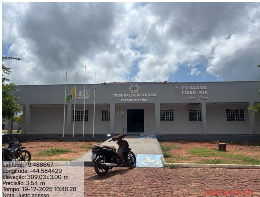
Figura 16 – Prédio do Justo Acesso
