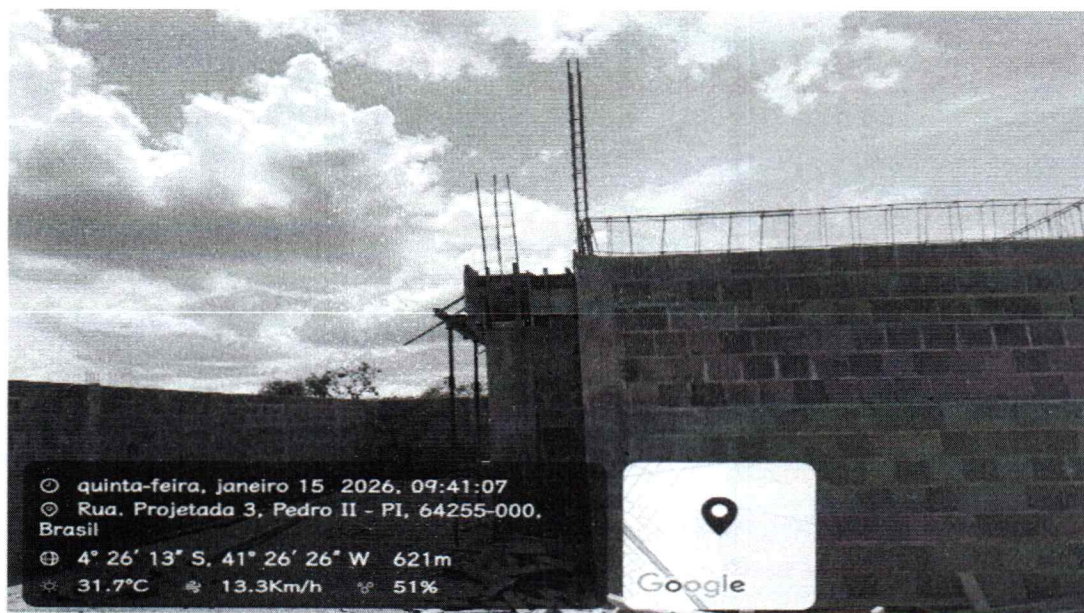
EXECUÇÃO DE PILARES E VIGAS
