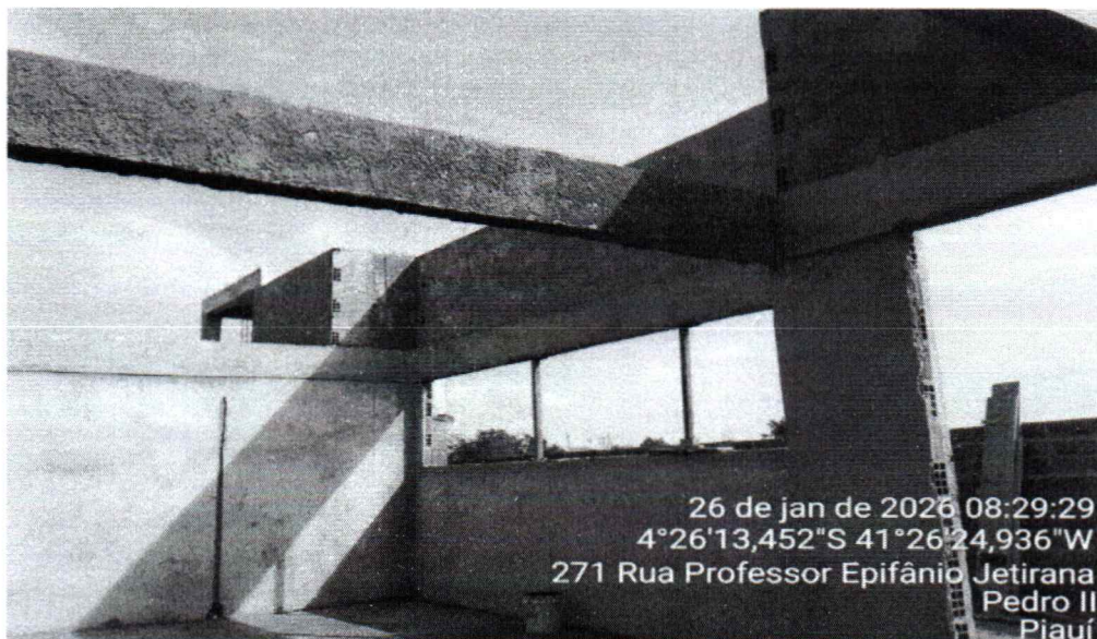
EXECUÇÃO DE REBOCO E PISO INTERNO
