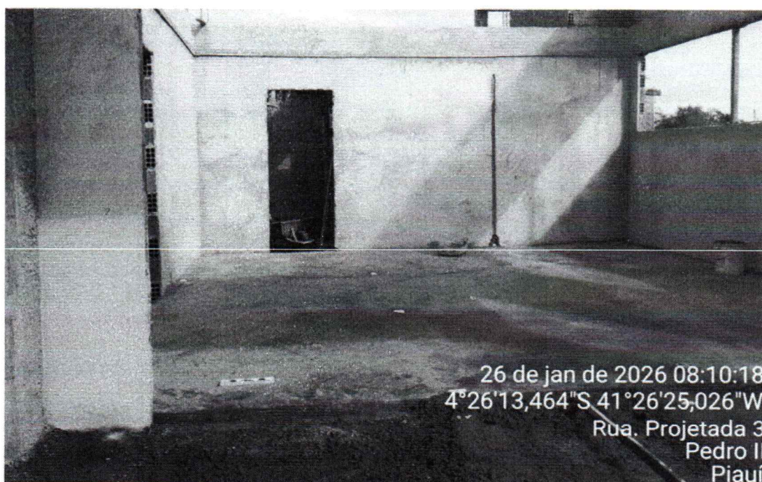
EXECUÇÃO DE REBOCO E PISO INTERNO
