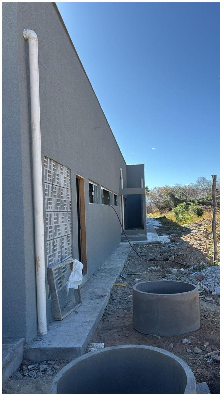
*Foto 4: Condutores verticais instalados*
