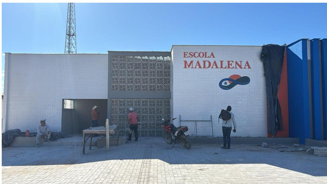
*Foto 1: Cobogós instalados, pintura, revestimento e comunicação visual finalizados*
