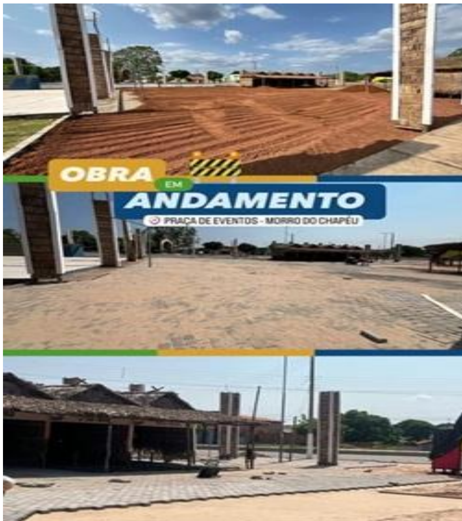
Figura 13 - Reforma praça central
