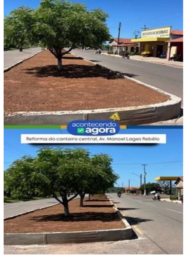
Figura 9 – Reforma do canteiro central
