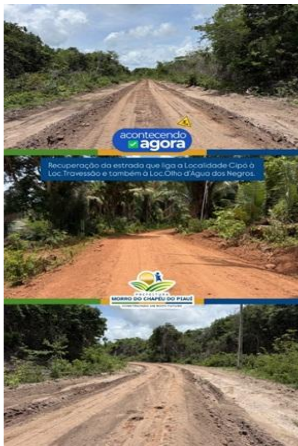
Figura 4 - Recuperação de estradas vicinais loc. Cipó e localidade Travessão
