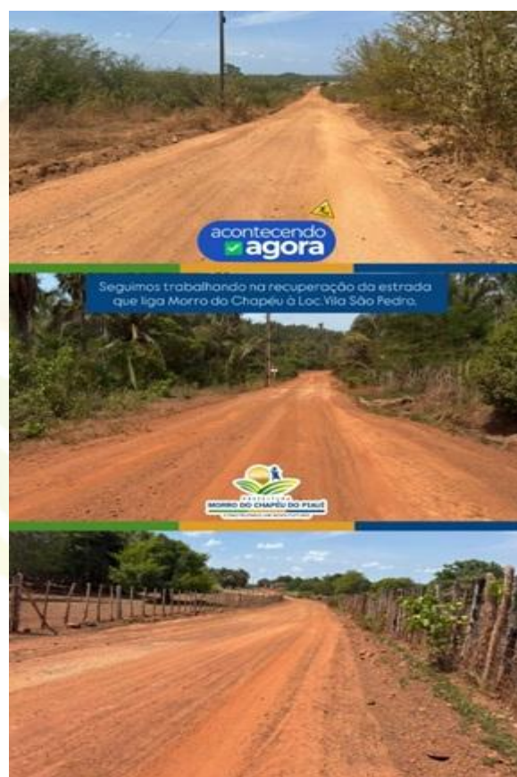
Figura 5 – Recuperação de estradas vicinais loc. São Pedro
