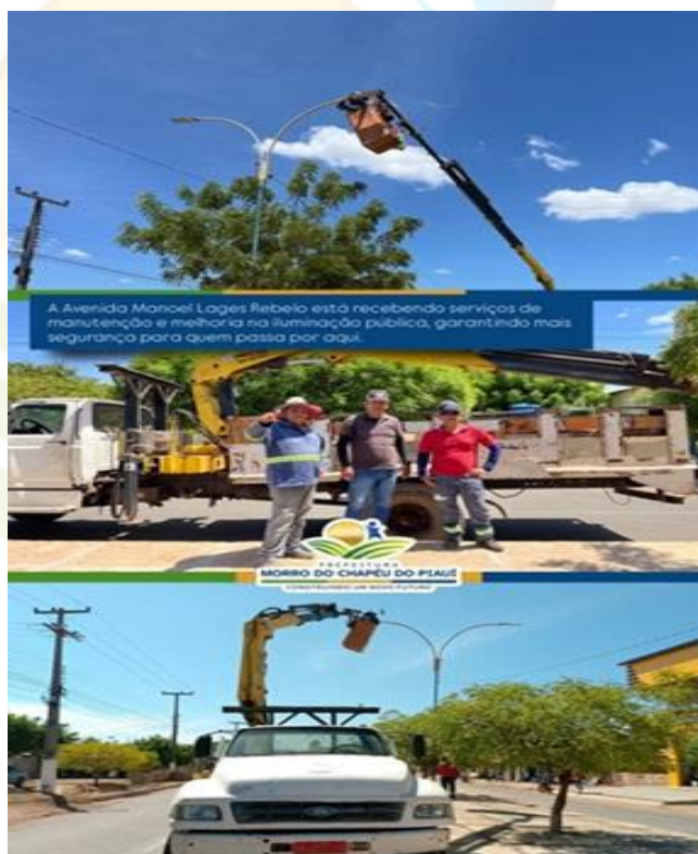
Figura 21 – Manutenção de Iluminação Pública
