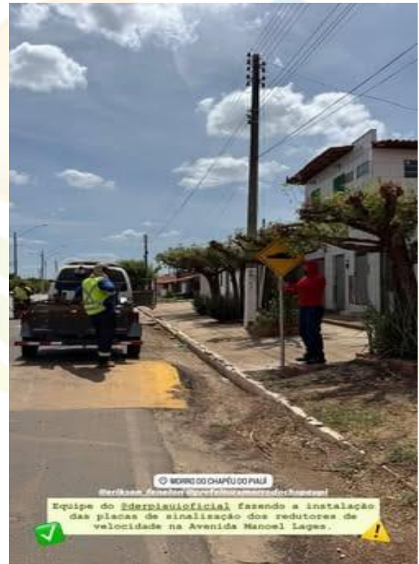
Figura 12 – Implantação de placas de sinalização
