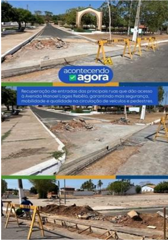
Figura 10 - Recuperação de ruas e avenida
