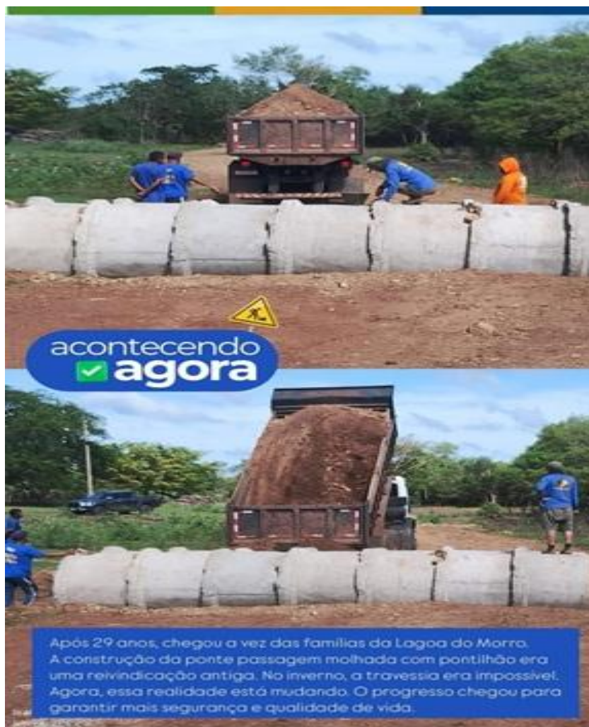
Figura 8 - Construção de ponte passagem molhada
