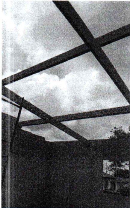
EXECUÇÃO DA COBERTURA
