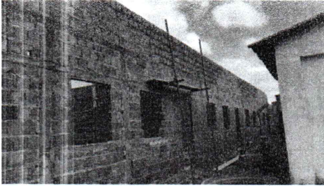
EXECUÇÃO DE ALVENARIA
