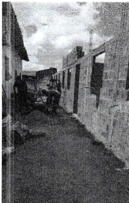
EXECUÇÃO DE ALVENARIA
