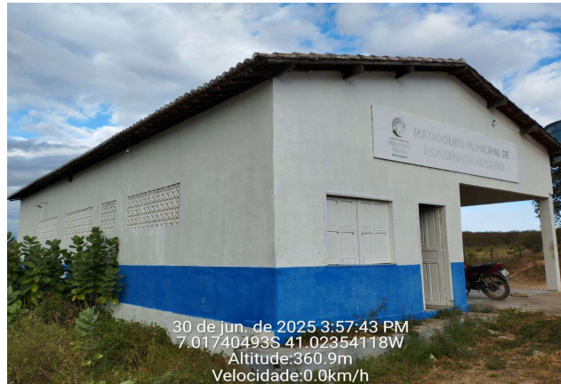
FOTO 02 - REFORMA DO MATADOURO MUNICIPAL DE MONSENHOR HIPÓLITO-PI
