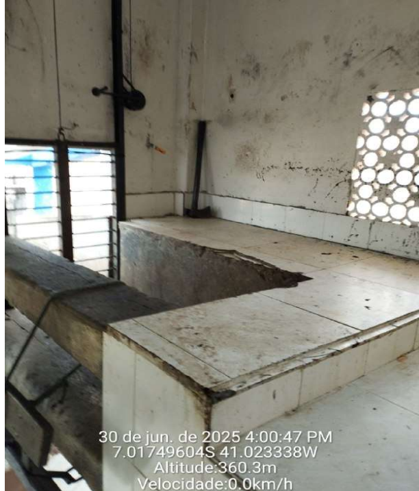
FOTO 20 - REFORMA DO MATADOURO MUNICIPAL DE MONSENHOR HIPÓLITO-PI
