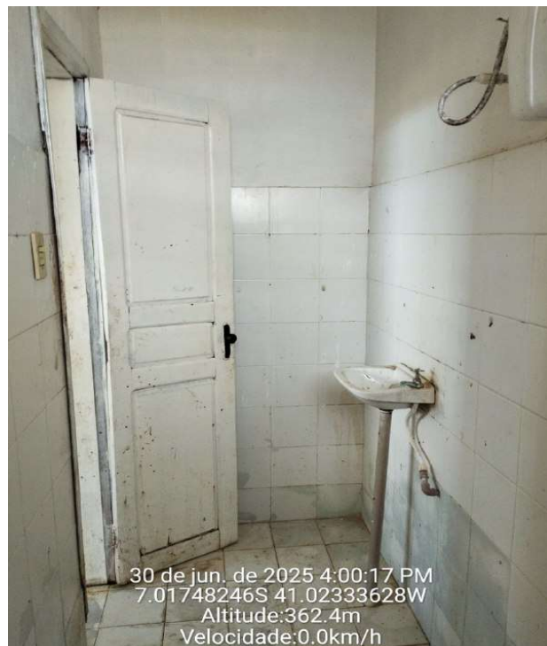
FOTO 17 - REFORMA DO MATADOURO MUNICIPAL DE MONSENHOR HIPÓLITO-PI
