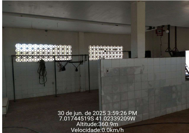
FOTO 16 - REFORMA DO MATADOURO MUNICIPAL DE MONSENHOR HIPÓLITO-PI
