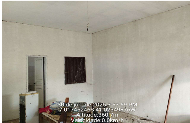
FOTO 13 - REFORMA DO MATADOURO MUNICIPAL DE MONSENHOR HIPÓLITO-PI
