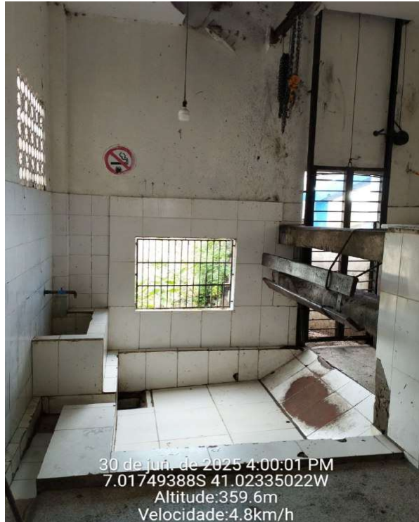
FOTO 22 - REFORMA DO MATADOURO MUNICIPAL DE MONSENHOR HIPÓLITO-PI
