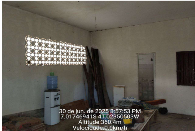
FOTO 10 - REFORMA DO MATADOURO MUNICIPAL DE MONSENHOR HIPÓLITO-PI
