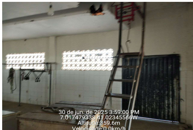
FOTO 12 - REFORMA DO MATADOURO MUNICIPAL DE MONSENHOR HIPÓLITO-PI
