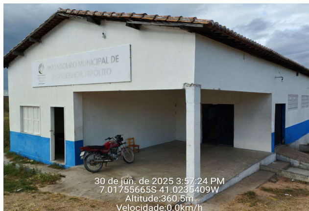
FOTO 03 - REFORMA DO MATADOURO MUNICIPAL DE MONSENHOR HIPÓLITO-PI
