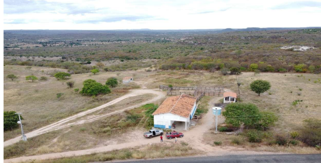
FOTO 01 - REFORMA DO MATADOURO MUNICIPAL DE MONSENHOR HIPÓLITO-PI
