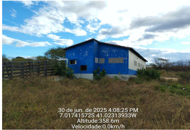
FOTO 04 - REFORMA DO MATADOURO MUNICIPAL DE MONSENHOR HIPÓLITO-PI
