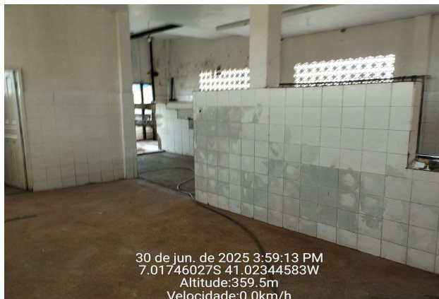
FOTO 09 - REFORMA DO MATADOURO MUNICIPAL DE MONSENHOR HIPÓLITO-PI
