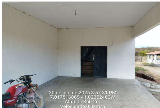
FOTO 05 - REFORMA DO MATADOURO MUNICIPAL DE MONSENHOR HIPÓLITO-PI
