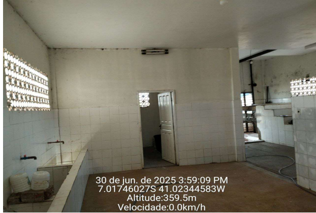
FOTO 07 - REFORMA DO MATADOURO MUNICIPAL DE MONSENHOR HIPÓLITO-PI
