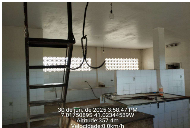
FOTO 11 - REFORMA DO MATADOURO MUNICIPAL DE MONSENHOR HIPÓLITO-PI
