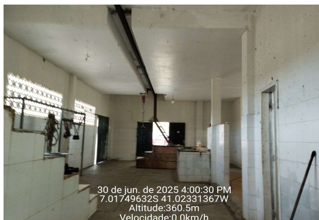
FOTO 06 - REFORMA DO MATADOURO MUNICIPAL DE MONSENHOR HIPÓLITO-PI
