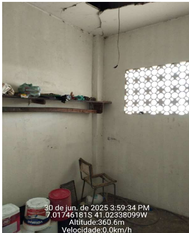
FOTO 21 - REFORMA DO MATADOURO MUNICIPAL DE MONSENHOR HIPÓLITO-PI
