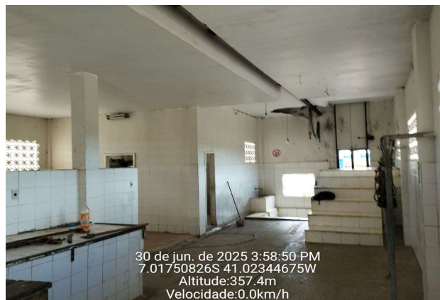
FOTO 14 - REFORMA DO MATADOURO MUNICIPAL DE MONSENHOR HIPÓLITO-PI
