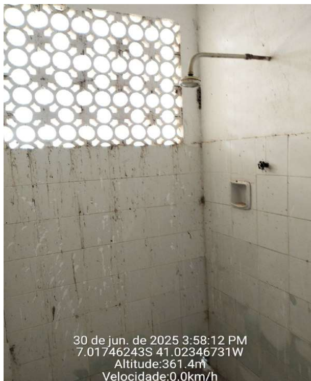
FOTO 19 - REFORMA DO MATADOURO MUNICIPAL DE MONSENHOR HIPÓLITO-PI
