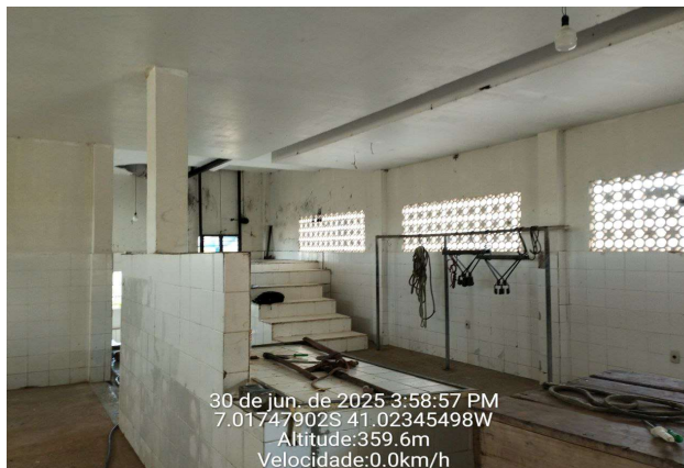
FOTO 08 - REFORMA DO MATADOURO MUNICIPAL DE MONSENHOR HIPÓLITO-PI
