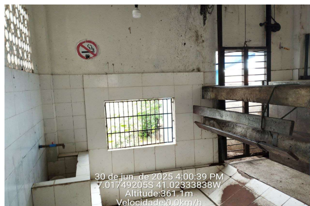
FOTO 15 - REFORMA DO MATADOURO MUNICIPAL DE MONSENHOR HIPÓLITO-PI
