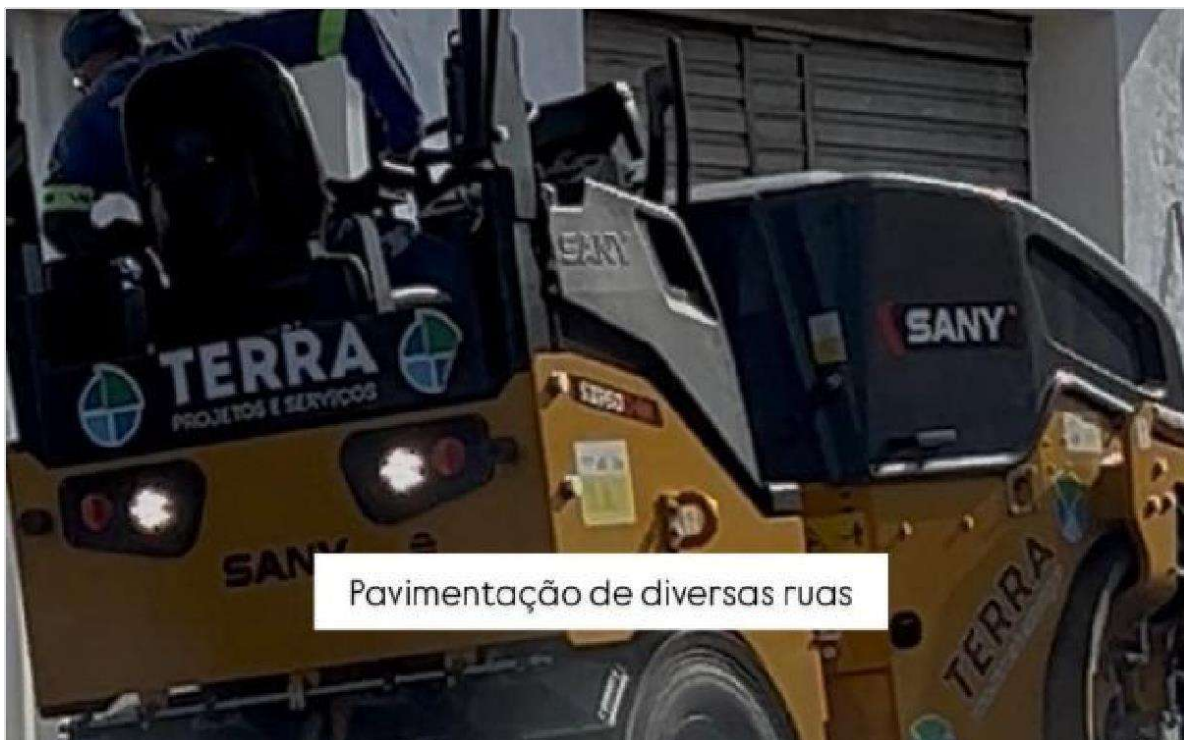
Figura 30 — Pavimentação de diversas ruas e Reforma de quadra poliesportiva
