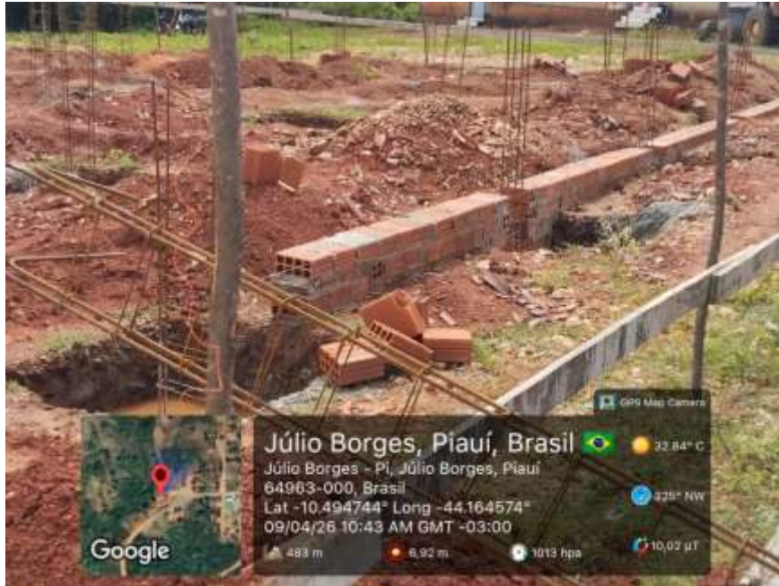
Foto 1: Início da execução do baldrame
