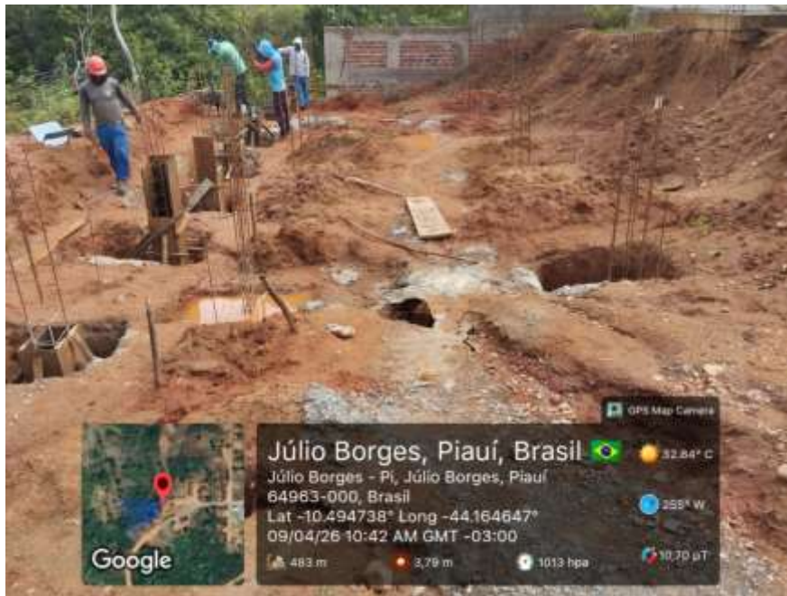
Foto 2: Escavações das sapatas
