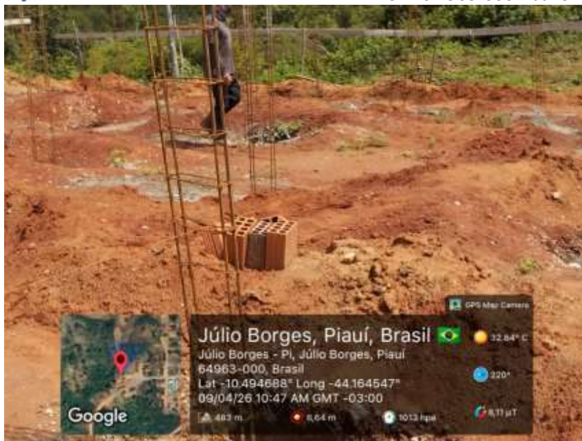
Foto 3: Colocação dos arranques
