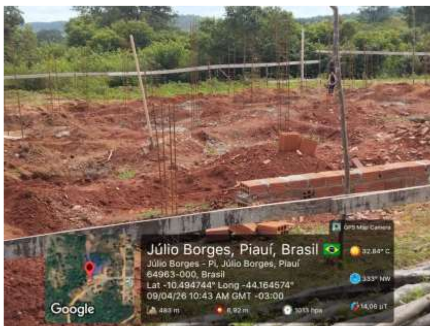
Foto 4: Escavações, arranques e baldrame iniciados
