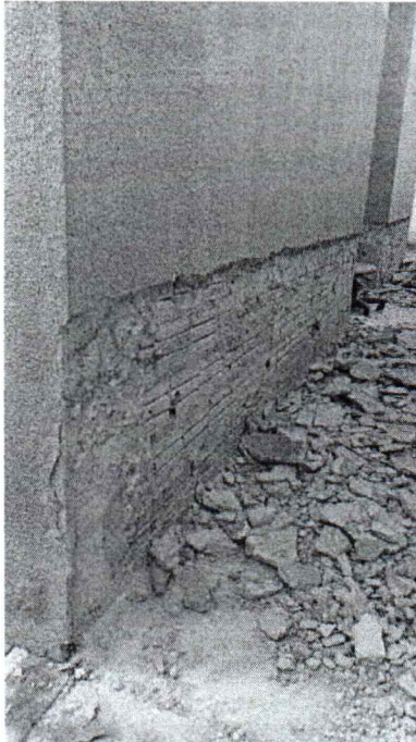
EXECUÇÃO DE DEMOLIÇÃO DE REBOCO
