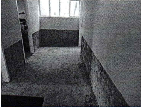
EXECUÇÃO DE DEMOLIÇÃO DE REBOCO
