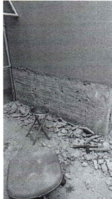
EXECUÇÃO DE DEMOLIÇÃO DE REBOCO
