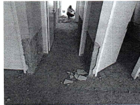
EXECUÇÃO DE DEMOLIÇÃO DE REBOCO
