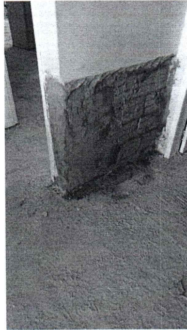
EXECUÇÃO DE IMPERMEABILIZAÇÃO EM PAREDES INTERNAS
