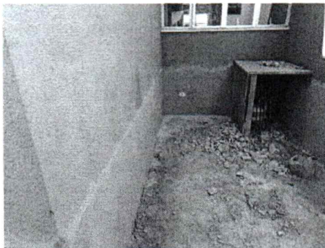
EXECUÇÃO DE DEMOLIÇÃO DE REBOCO EM PAREDES EXTERNAS
