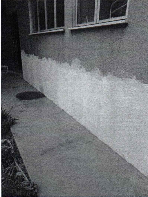
EXECUÇÃO DE PINTURA EM PAREDES EXTERNAS
