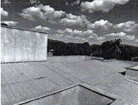
EXECUÇÃO DE REBOCO ARGAMASSADO EM PLATIBANDA
