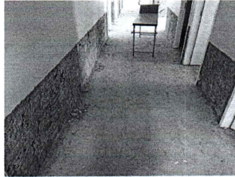
EXECUÇÃO DE DEMOLIÇÃO DE REBOCO
