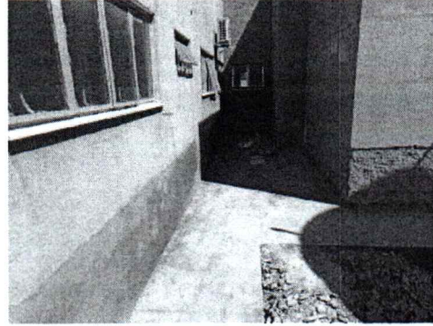
EXECUÇÃO DE DEMOLIÇÃO DE REBOCO EM PAREDES EXTERNAS
