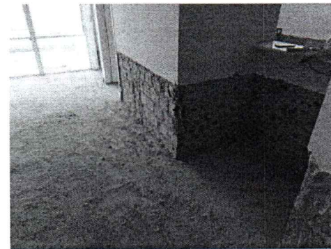
EXECUÇÃO DE DEMOLIÇÃO DE REBOCO
