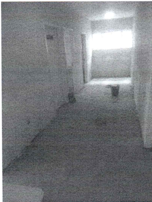
EXECUÇÃO DE EMASSAMENTO EM PAREDES INTERNAS
