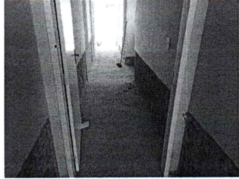
EXECUÇÃO DE DEMOLIÇÃO DE REBOCO
