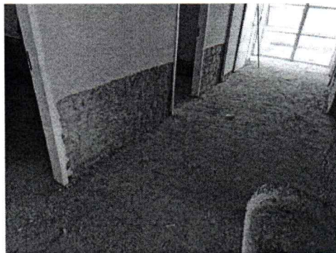
EXECUÇÃO DE DEMOLIÇÃO DE REBOCO
