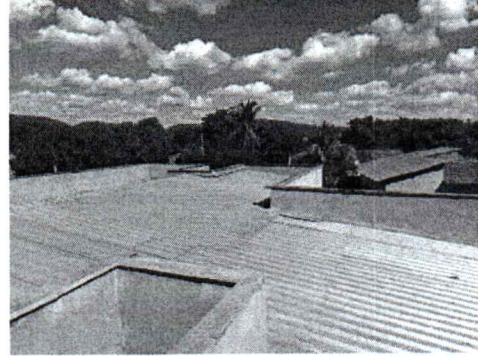
EXECUÇÃO DE REBOCO ARGAMASSADO EM PLATIBANDA
