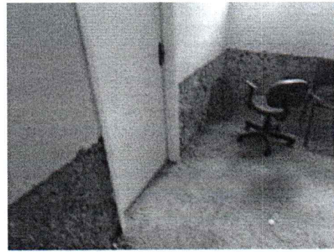
EXECUÇÃO DE DEMOLIÇÃO DE REBOCO
