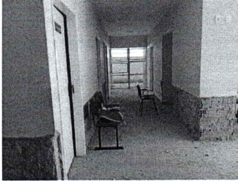
EXECUÇÃO DE DEMOLIÇÃO DE REBOCO
