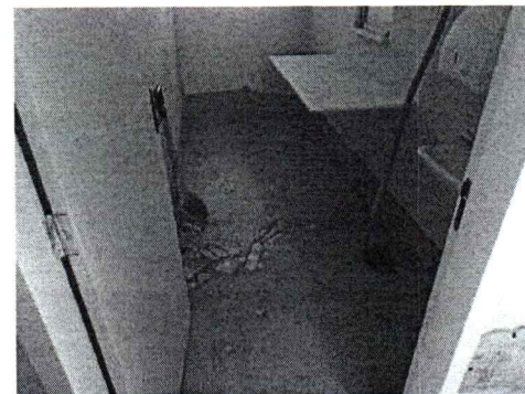
EXECUÇÃO DE DEMOLIÇÃO DE REBOCO
