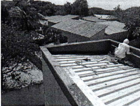
EXECUÇÃO DE REBOCO ARGAMASSADO EM PLATIBANDA
