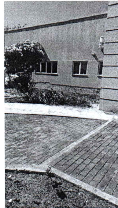
EXECUÇÃO DE DEMOLIÇÃO DE REBOCO EM PAREDES EXTERNAS
