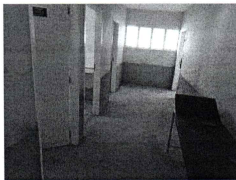
EXECUÇÃO DE REBOCO ARGAMASSADO EM PAREDES INTERNAS
