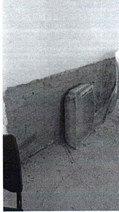
EXECUÇÃO DE IMPERMEABILIZAÇÃO EM PAREDES INTERNAS
