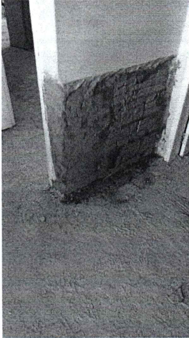
EXECUÇÃO DE IMPERMEABILIZAÇÃO DE PAREDES
