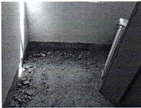
EXECUÇÃO DE DEMOLIÇÃO DE REBOCO
