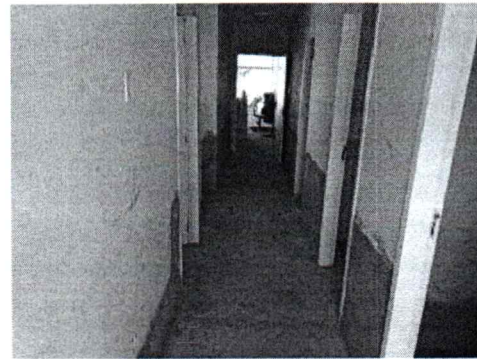
EXECUÇÃO DE REBOCO ARGAMASSADO EM PAREDES INTERNAS
