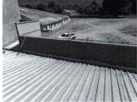
EXECUÇÃO DE REBOCO ARGAMASSADO EM PLATIBANDA
