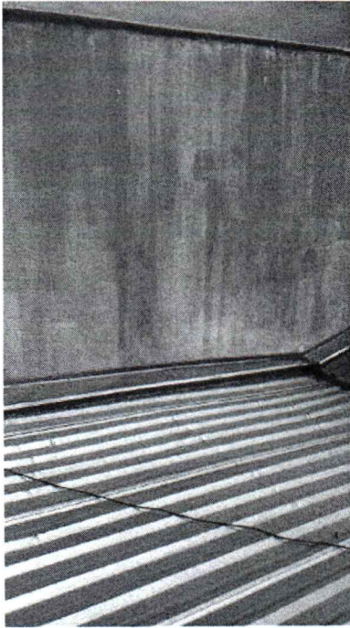
EXECUÇÃO DE INSTALAÇÃO DE RUFO METÁLICO
