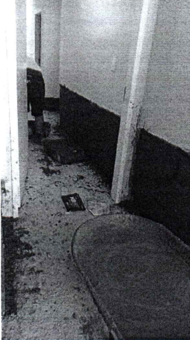
EXECUÇÃO DE CHAPISCO EM PAREDES INTERNAS
