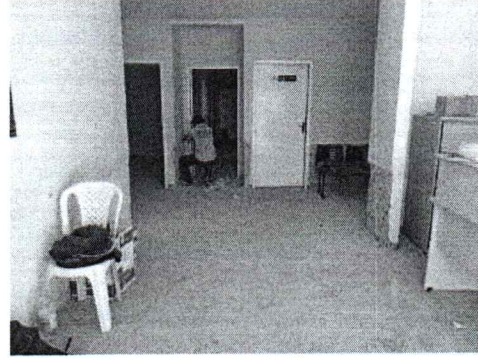
EXECUÇÃO DE DEMOLIÇÃO DE REBOCO
