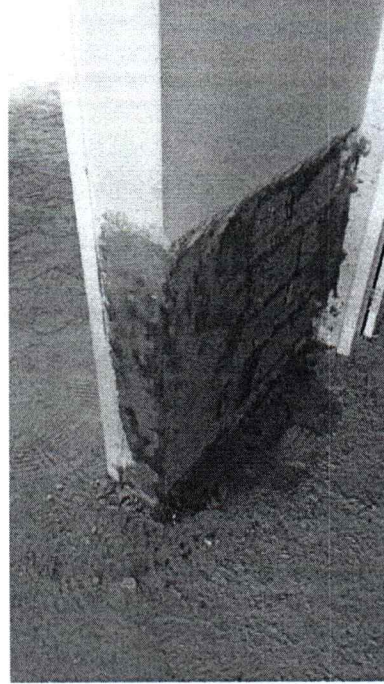
EXECUÇÃO DE IMPERMEABILIZAÇÃO DE PAREDES
