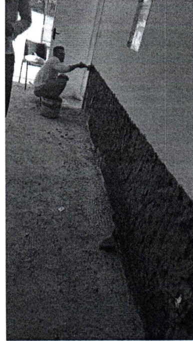
EXECUÇÃO DE REBOCO ARGAMASSADO EM PAREDES INTERNAS
