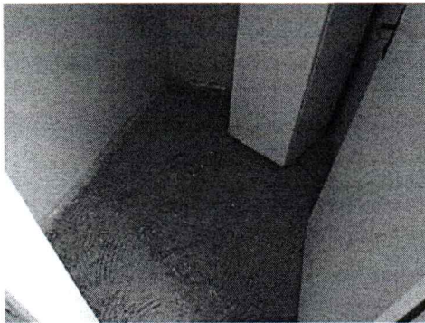
EXECUÇÃO DE DEMOLIÇÃO DE REVESTIMENTO CERÂMICO EM PISO
