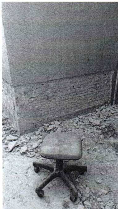
EXECUÇÃO DE DEMOLIÇÃO DE REBOCO
