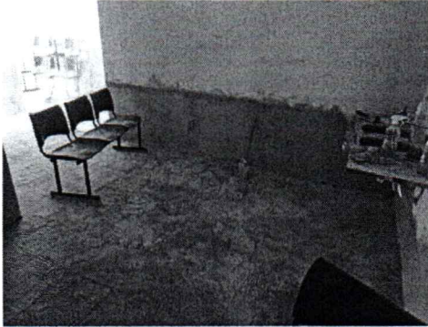
EXECUÇÃO DE REBOCO ARGAMASSADO EM PAREDES INTERNAS
