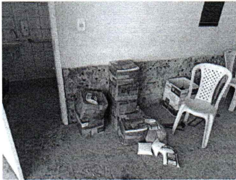
EXECUÇÃO DE DEMOLIÇÃO DE REBOCO
