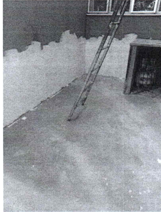
EXECUÇÃO DE PINTURA EM PAREDES EXTERNAS
