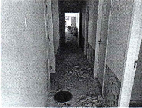
EXECUÇÃO DE DEMOLIÇÃO DE REBOCO
