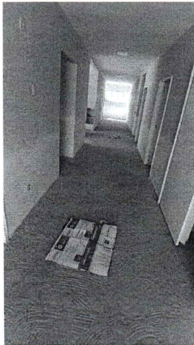
EXECUÇÃO DE EMASSAMENTO E LIXAMENTO EM PAREDES INTERNAS
