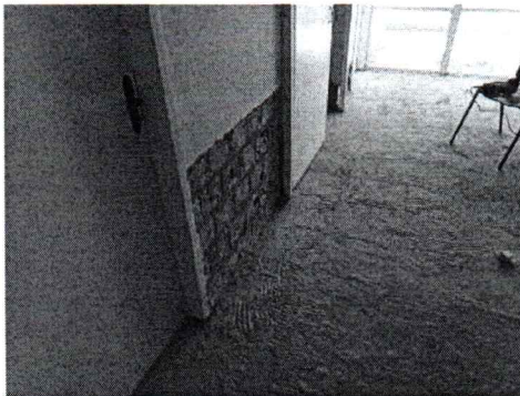
EXECUÇÃO DE DEMOLIÇÃO DE REBOCO
