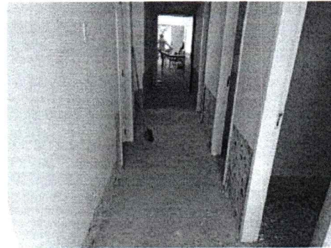
EXECUÇÃO DE DEMOLIÇÃO DE REBOCO
