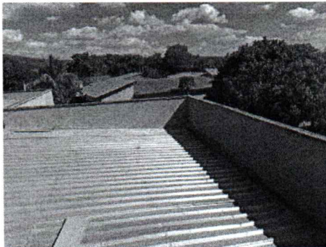
EXECUÇÃO DE REBOCO ARGAMASSADO EM PLATIBANDA
