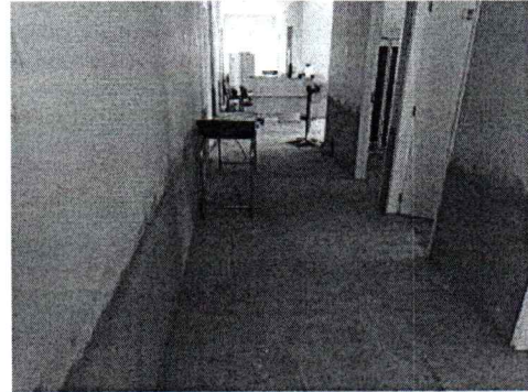
EXECUÇÃO DE REBOCO ARGAMASSADO EM PAREDES INTERNAS
