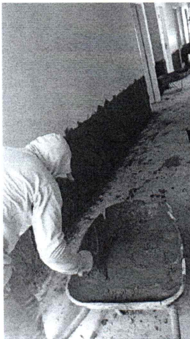
EXECUÇÃO DE REBOCO ARGAMASSADO EM PAREDES INTERNAS
