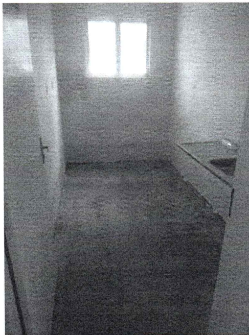
EXECUÇÃO DE EMASSAMENTO EM PAREDES INTERNAS
