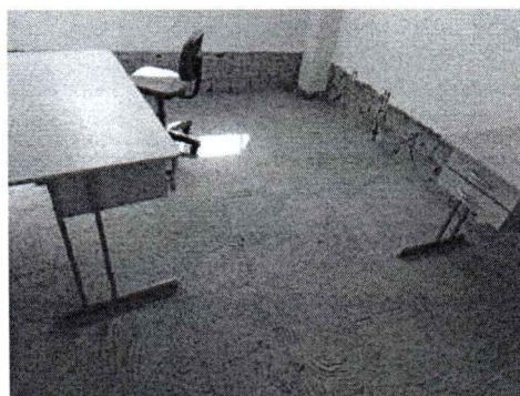
EXECUÇÃO DE DEMOLIÇÃO DE REBOCO
