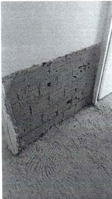
EXECUÇÃO DE IMPERMEABILIZAÇÃO EM PAREDES INTERNAS
