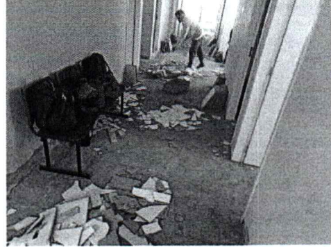
EXECUÇÃO DE DEMOLIÇÃO DE REVESTIMENTO CERÂMICO EM PISO
