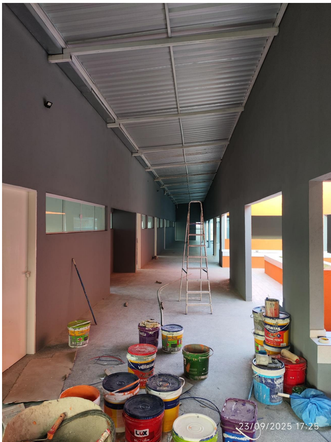
Foto 3: Acabamentos, cobertura e esquadrias finalizadas
