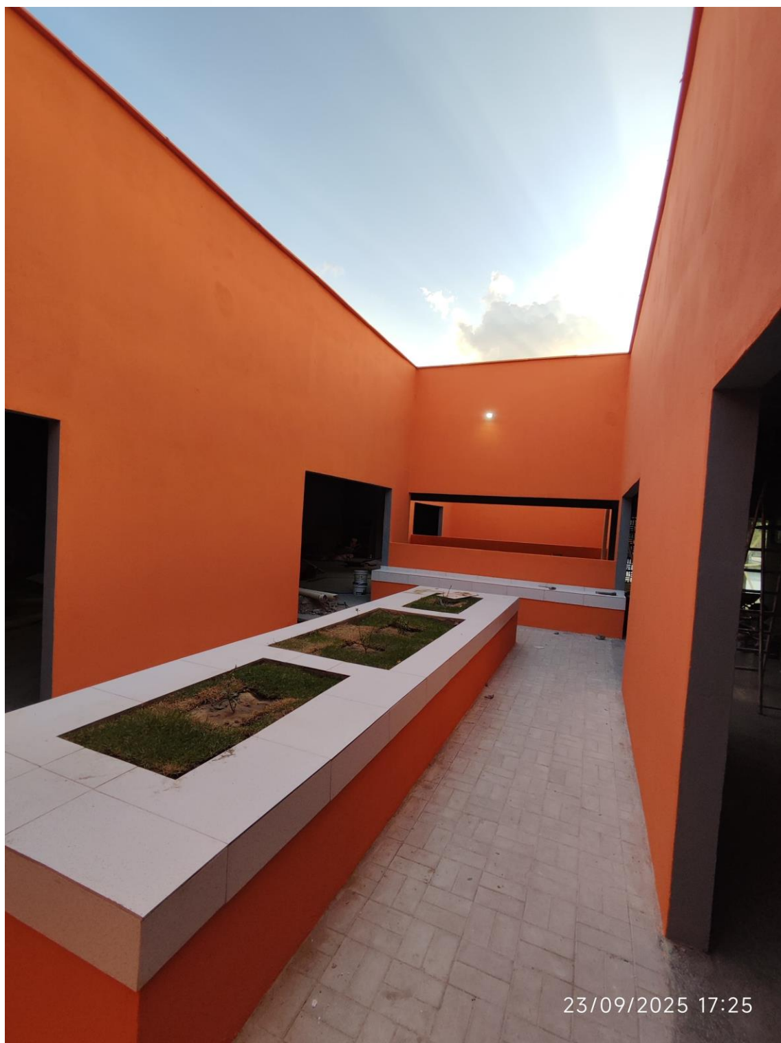
Foto 1: Pintura e piso intertravado finalizados
