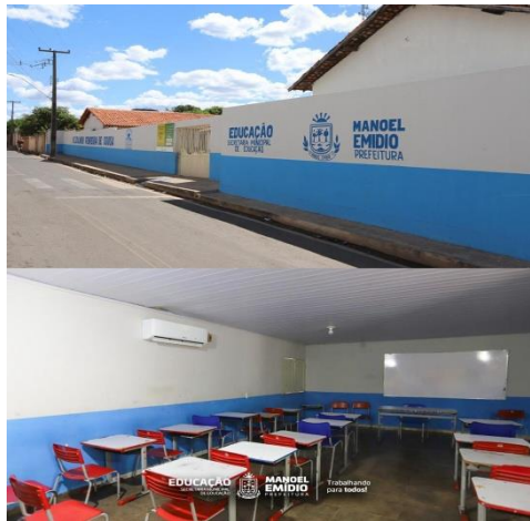
MELHORIA NA INFRAESTRUTURA
