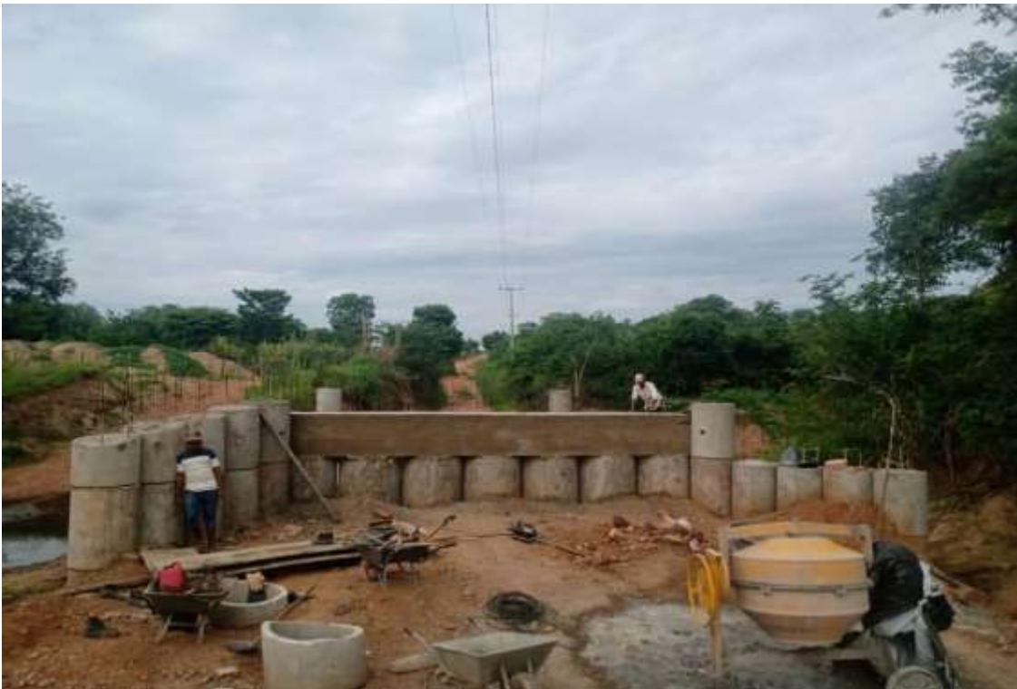
Figura 6- Construção de ponte
