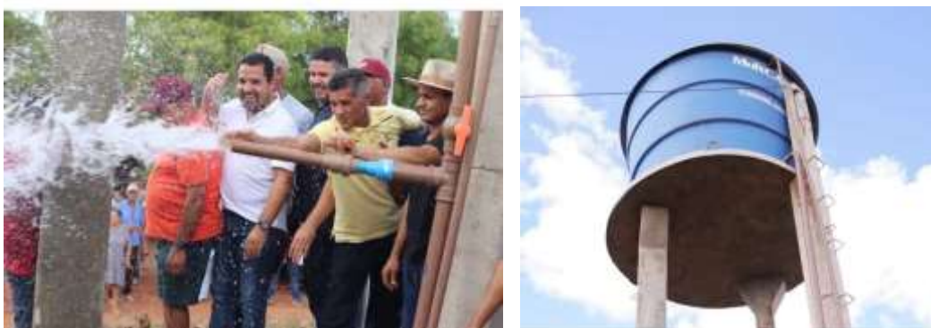
Figura 4- Perfuração de poços e rede de abastecimento de água
