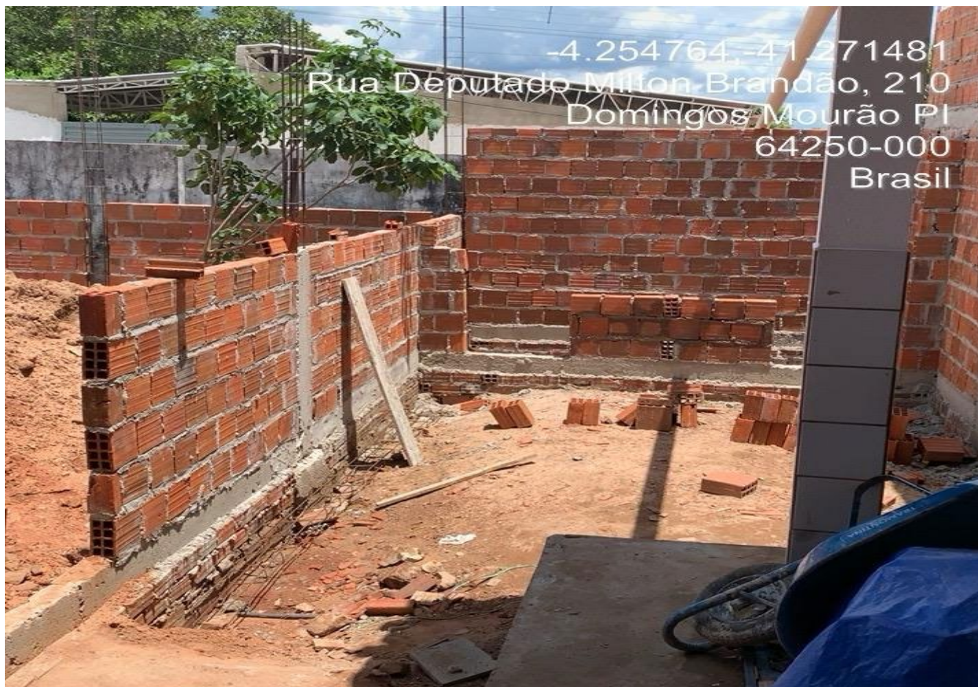
Figura 10: Ampliação da Unidade Escolar Monsenhor Uchôa
