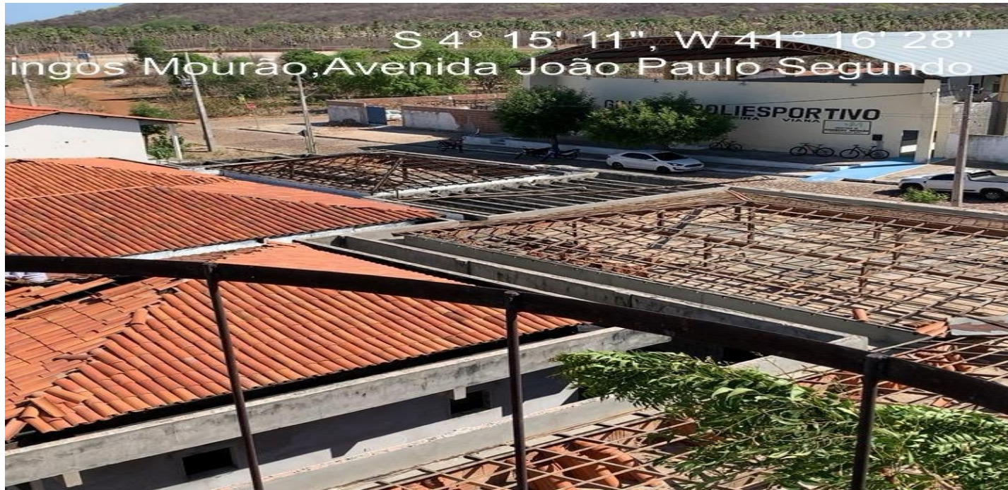
Figura 9: Conclusão da Creche
