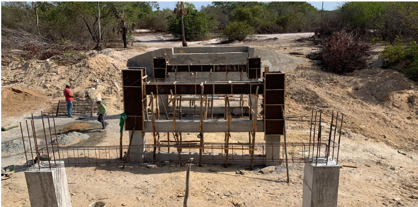
Figura 8: Ponte do Povoado Jacarandá
