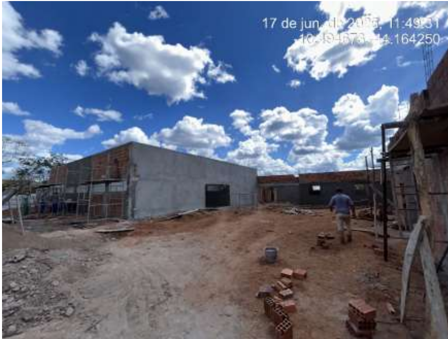
Foto 4: Levantamento de alvenaria e supra estrutura e reboco
