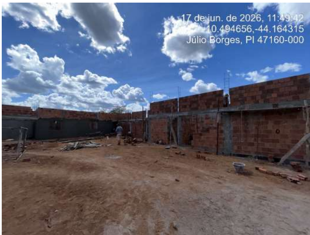
Foto 3: Levantamento de alvenaria e supra estrutura
