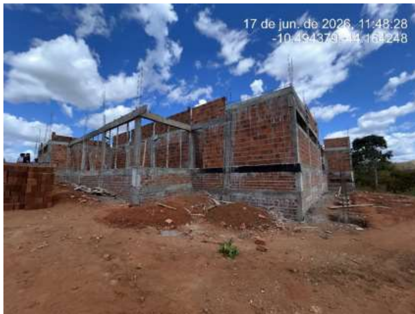
Foto 5: Levantamento de alvenaria e supra estrutura
