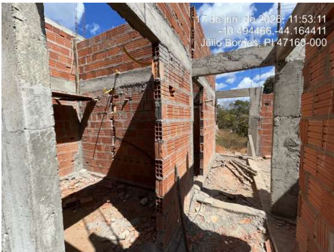
Foto 1: Levantamento de alvenaria e supra estrutura
