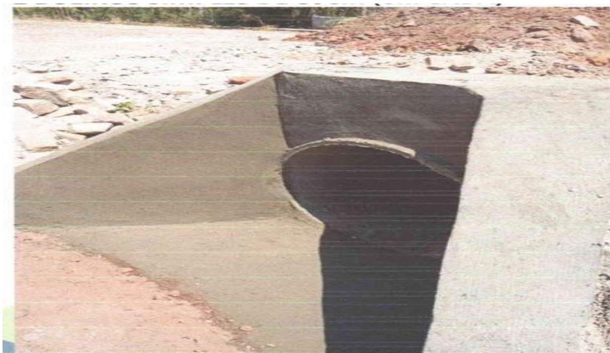
BUEIRO BELA FONTE
