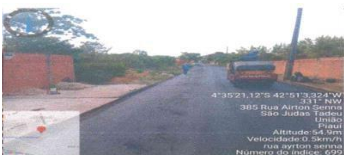
Asfalto Rua Ayrton Senna
