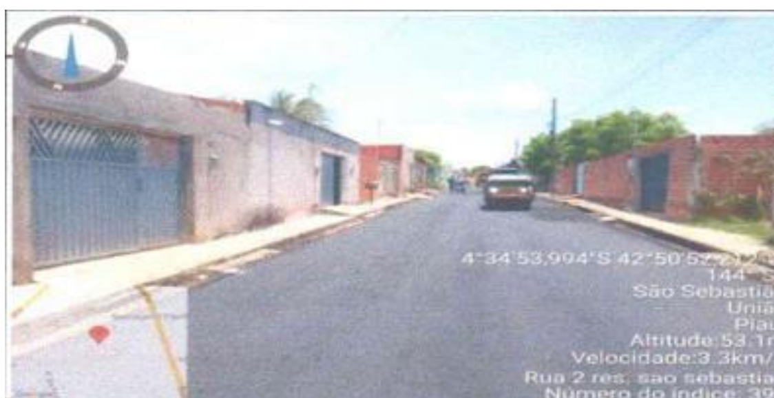
Asfalto Rua 2 Res São Sebastião
