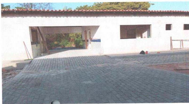
Prédio Adm Divinópolis
