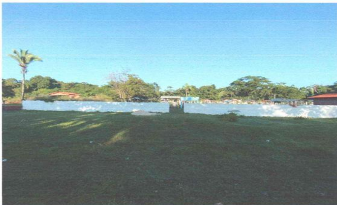
MURO CEMITÉRIO DO XIXÁ
