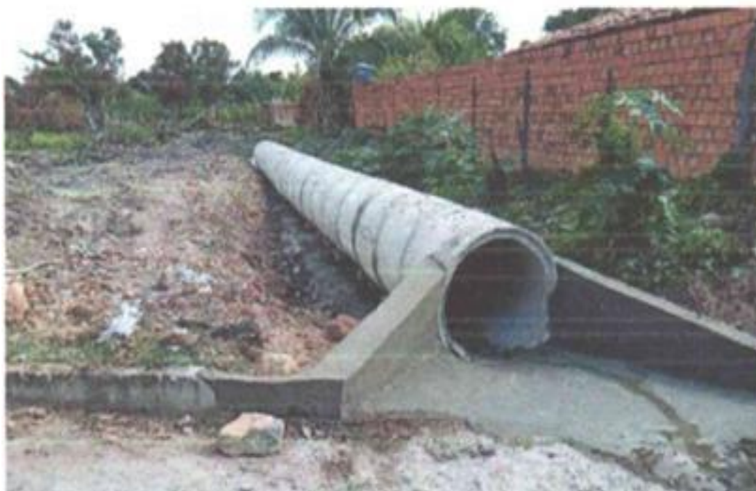
BUEIRO RUA DA PEDREIRA
