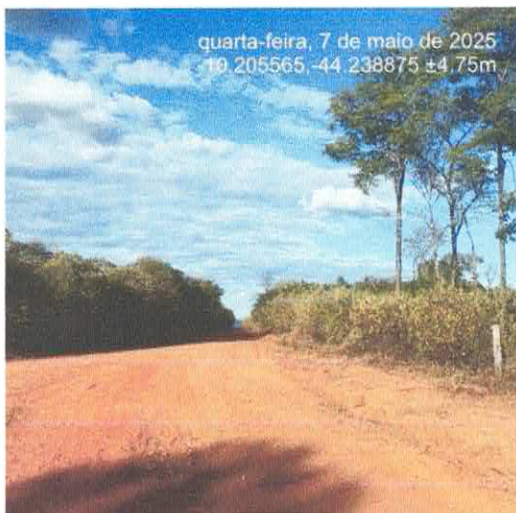
Trecho 03 - Acesso Barragem Dos Algodões II ( PI-255) á Lagoa Grande
