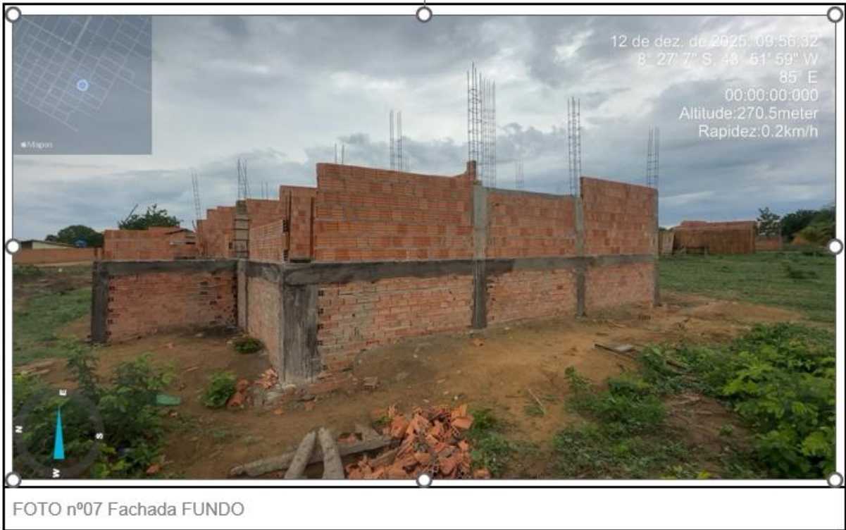
Figura 33 - Fachada do Fundo
