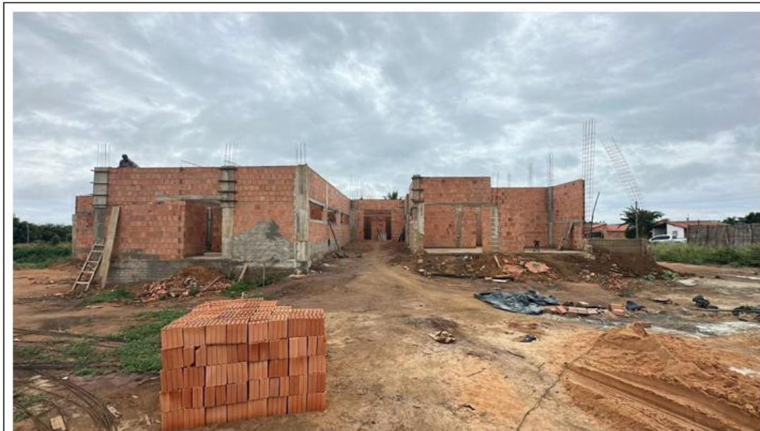
Figura 3 Fachada LATERAL ESQUERDA
