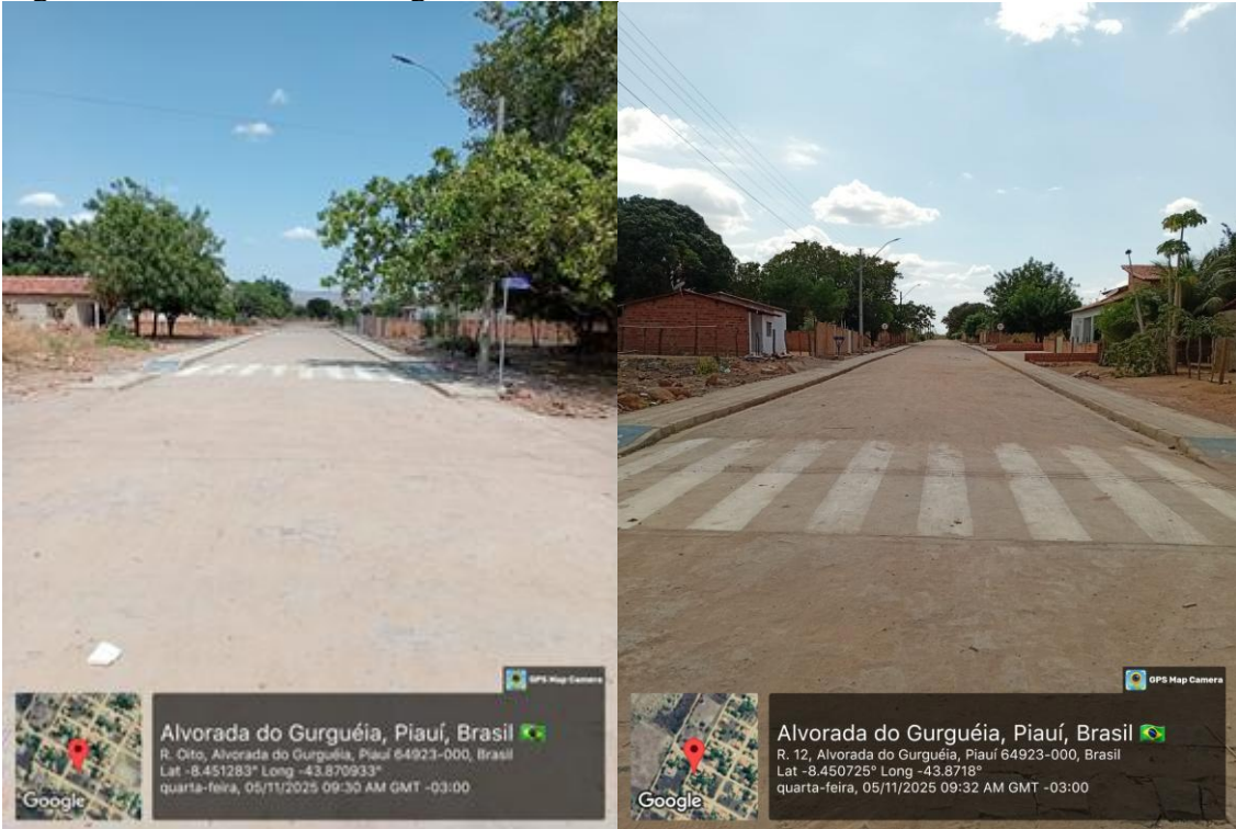
Figura 27 - Rua Bruno Rodrigues De Oliveira – Ultimo Trecho
